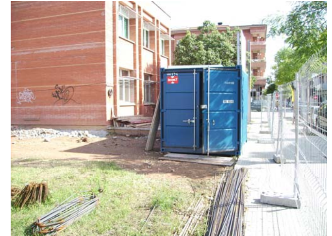
Implantació a l'obra: El mòdul de magatzem.
