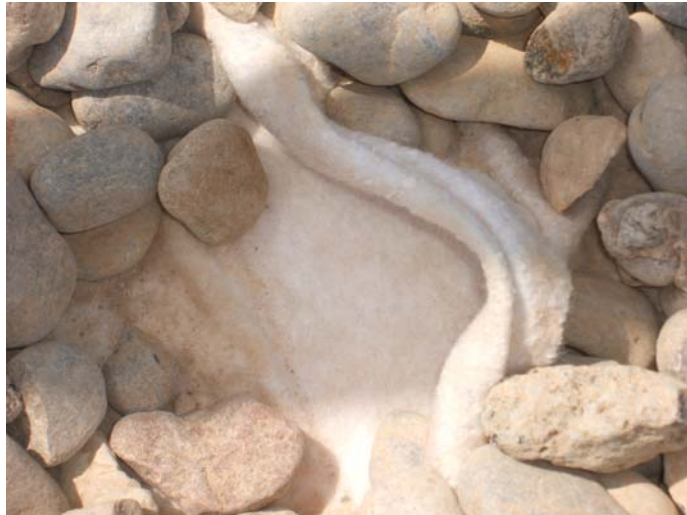
Detall del geotèxtil
