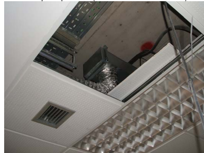
Una de les reixes de ventilació de la sala de personal.
