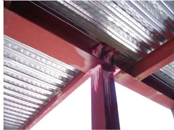
Comprovacions de les soldadures.
