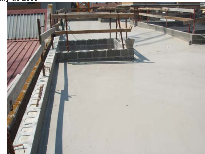
Cos central de l'ampliació. Enlestides les pendents de la coberta.
