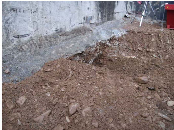
Nivell de fonamentació del mur de formigó del garatge veí. Excavació feta per a estudiar la trobada del mur l'ala Nord amb el mur del garatge veí.
