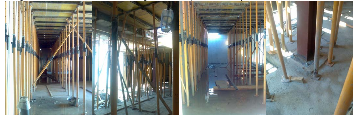
Apuntament de la llosa del sostre de l'ala Sud
