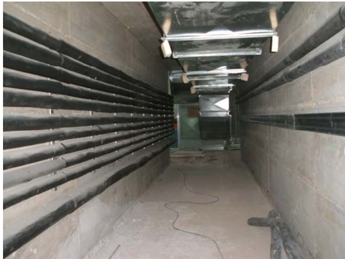
Vista del túnel entre ales, Al fons, el recinte del climatitzador de l'ala Sud.
