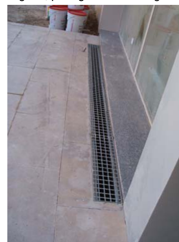
Reixa d'admissió d'aire del generador, col·locada.
