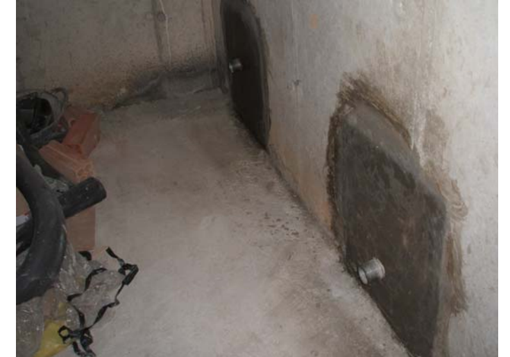
Solució de la connexió de les bombes d'incendis amb el dipòsit d'aigua.
