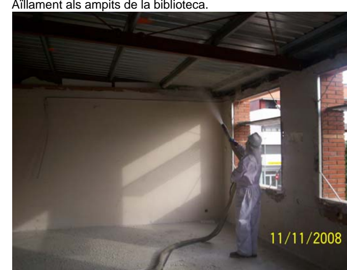
Projectat aïllant de sota la teulada de planxa sandvitx de la biblioteca antiga.
