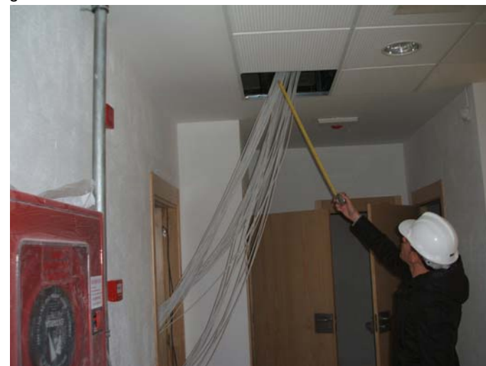
A l'obra han entrat els instal·ladors de les telecomunicacions enviat per la Diputació. Estesa dels cables de xarxa informàtica.
