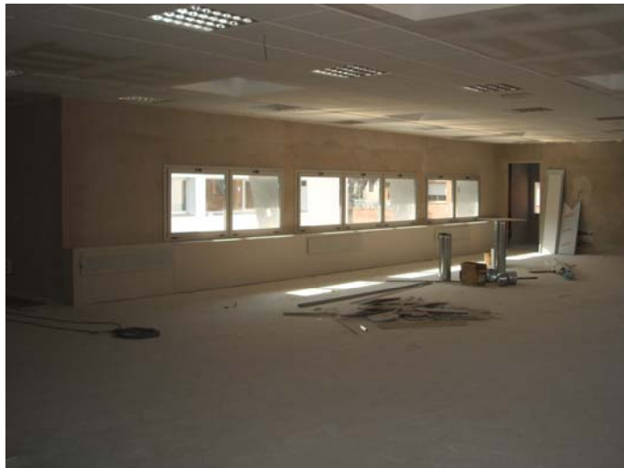
Col·locació dels difusors per desplaçament. (ala Nord, façana Sud)
