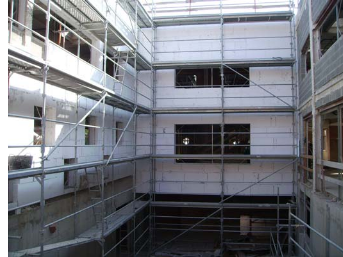
Estat del revestiment amb aïllant. Col·locació de planxes.
