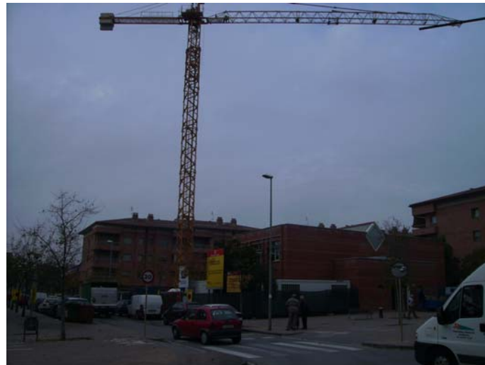
Grua, muntada sobre el seu dau.
