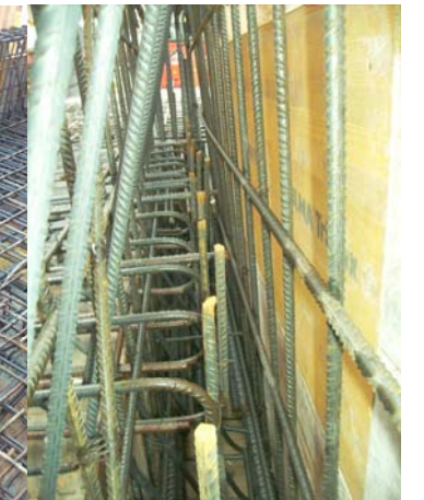
Interior de la jàssera, amb l'armat complet.
