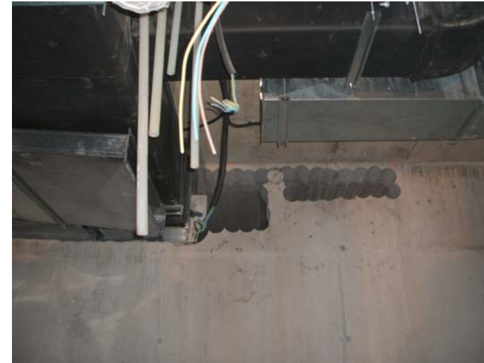
Correccions en el traçat de l'aire condicionat. Per a evitar encreuaments que haurien fet baixar el fals sostre de la sala polivalent.
