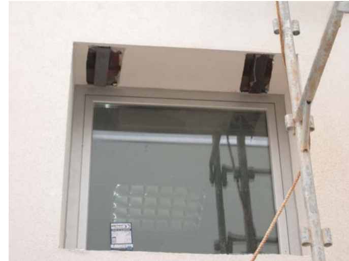
Sistema de suport dels brise-soleil. S'han deixat perfils metàl·lics embeguts al revestiment, per a suportar el vol i mantenir la planxa plana.
