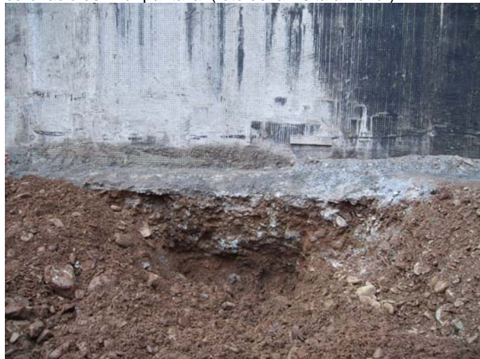
Nivell de la fonamentació del mur de formigó del garatge veí.
