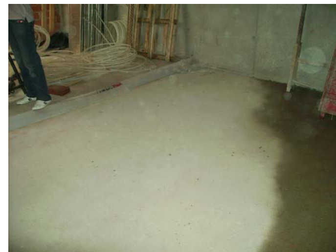
Sòl de la sala de personal. Final de la part amb sòl radiant, i inici de la part amb recrescut de morter, per a poder suportar un "Compactus".
