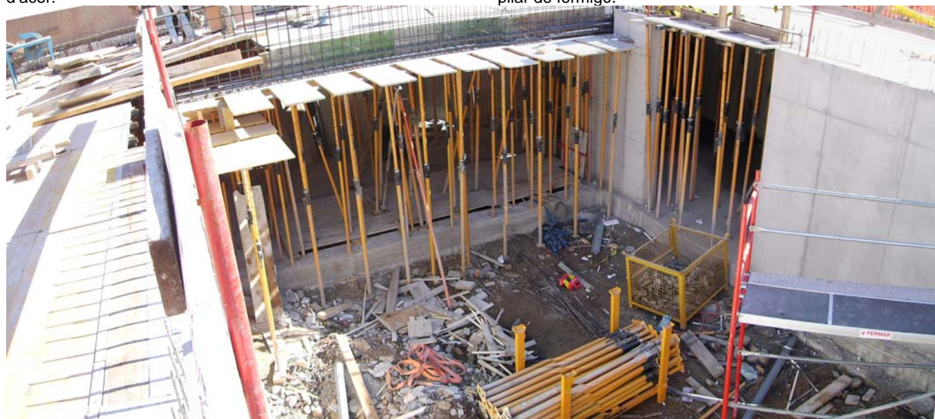
Visió general del pati central, amb els encofrats de la llosa
