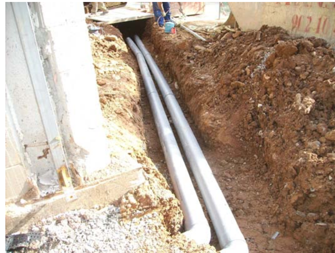
Tubs de sanejament col·locats a la rasa.
