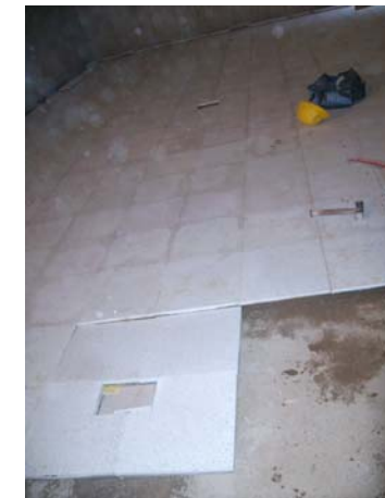
Pavimentació de la sala polivalent del soterrani, sobre aïllament i morter de retrescut.
