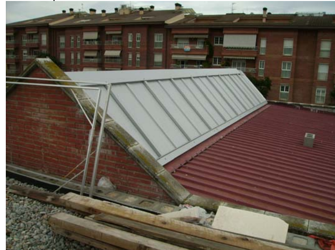
Exterior del penell sandvitx que tapa la cara Sud de la claraboia de la biblioteca antiga.
