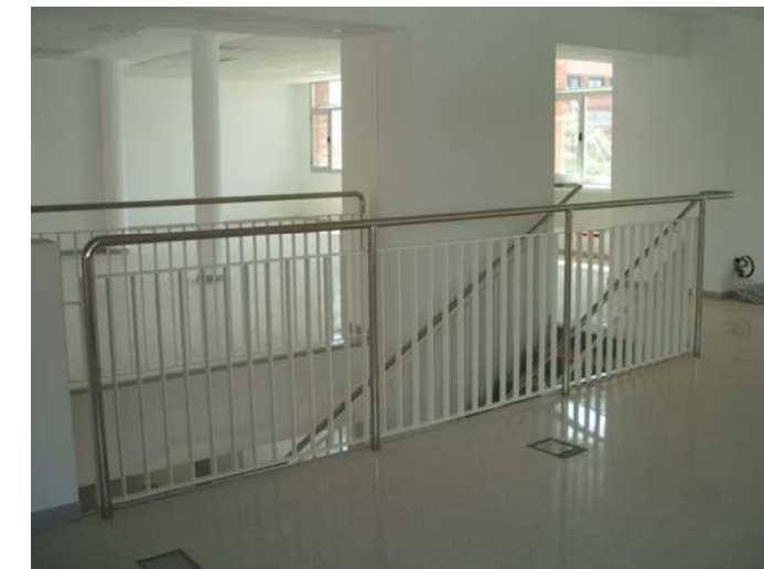
Baranes de l'escala col·locades.
