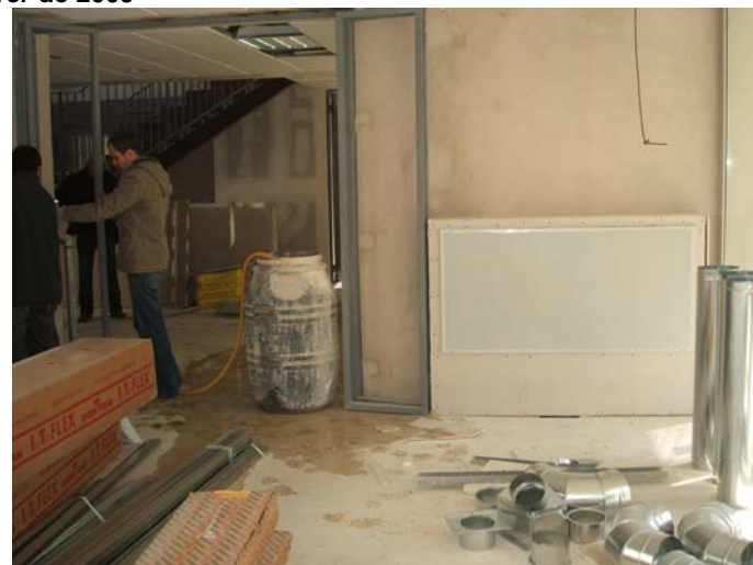
Inici de la col·locació de les portes proposades per la Diputació per a permetre el funcionament de la sala polivalent amb la biblioteca tancada.
