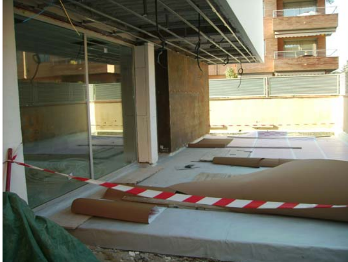
Impermeabilització de la llosa sobre el generador, la sala de caldera i el dipòsit d'aigua per a incendis.
