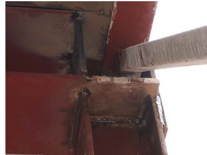
Platines de reforç per a la continuïtat de les ales dels pilars
