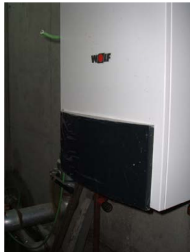
Nova caldera estanca de condensació al recinte de caldera i bomba de calor geotèrmica.
