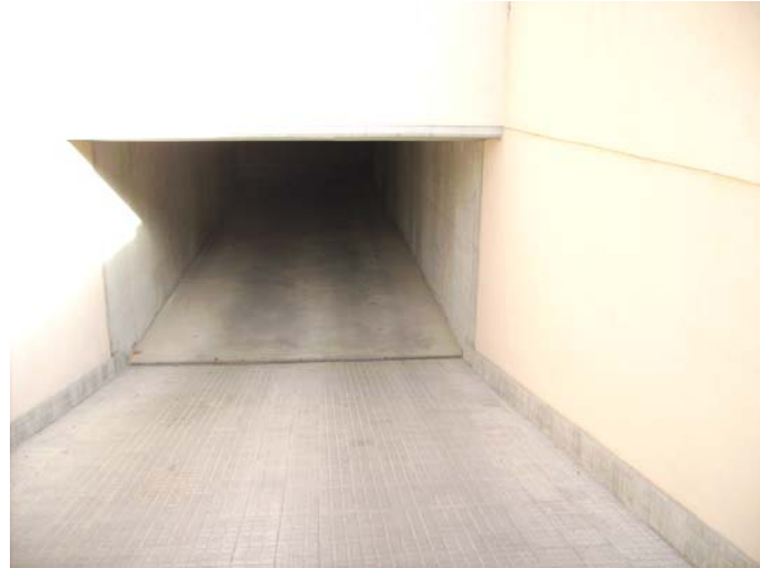
Visita al garatge veí per a poder veure l'estat actual.
