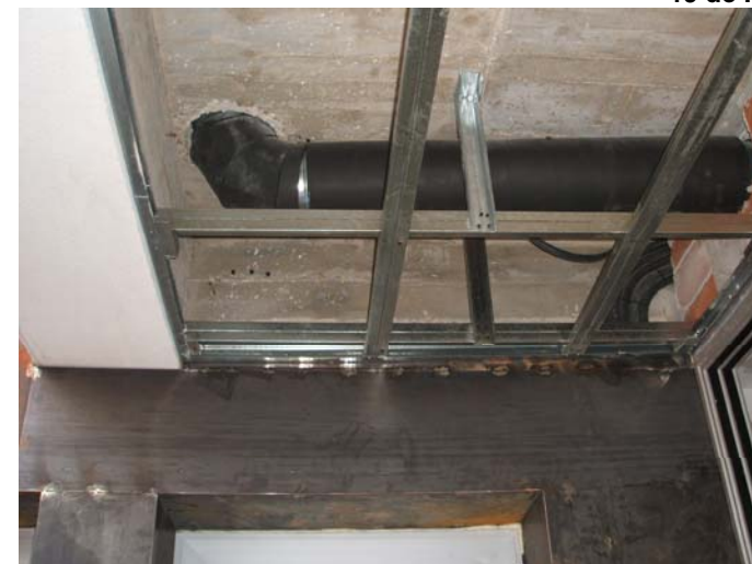
Tub d'aire condicionat al sostre del porxo del soterrani. Connecta el traçat amb el difusor per desplaçament de davant del taulell de l'entrada.
