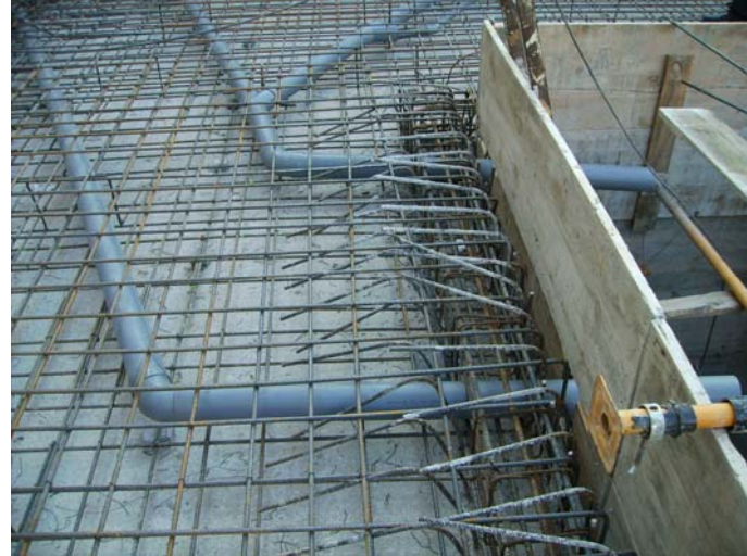
Al fons, xarxa de sanejament del soterrani. Davant, tub per a ventilació del sanejament.
