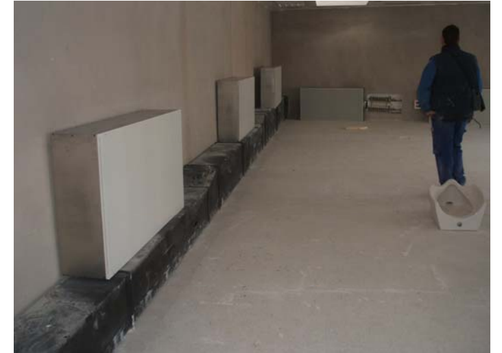
Inici de la col·locació dels difusors per desplaçament.
