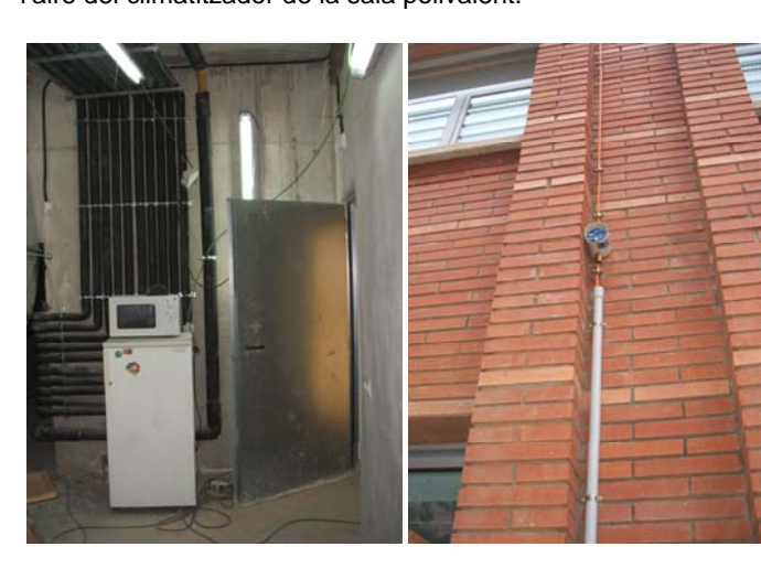
Instal·lacions del terra radiant, des del túnel entre ales, cap a l'ala Sud.
