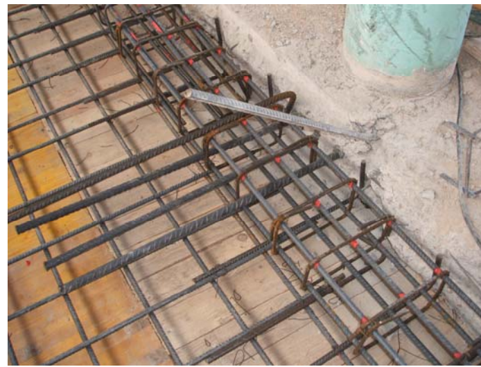
Tres rodons de connexió entre la nova llosa i l'antic forjat a l'altura dels pilars.
