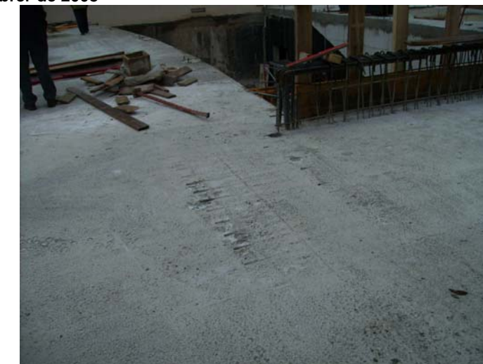
La zona amb més densitat d'armat. Resta per formigonar la part alta de la jàssera invertida.
