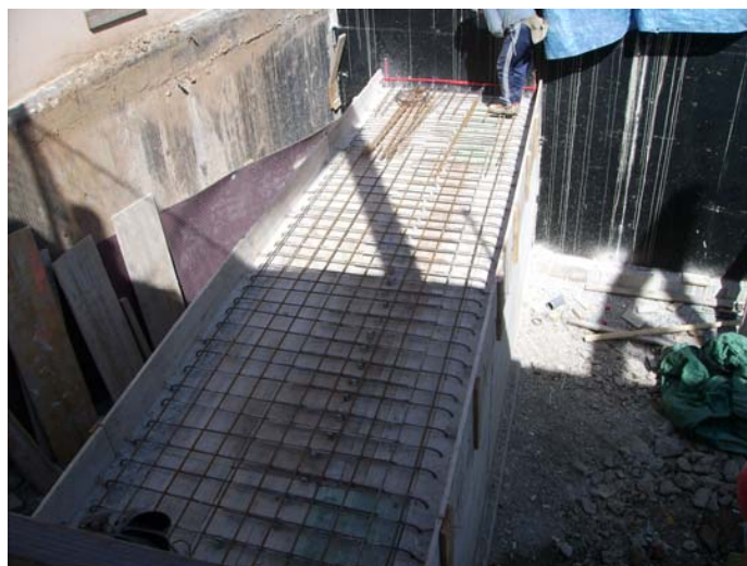
Inici de l'armat del sostre del passadís subterrani entre ales.
