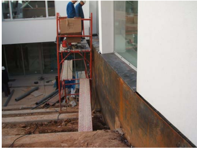
La corba de planxa cortén ha estat corregida, i s'estan posant els remats dels ampist
