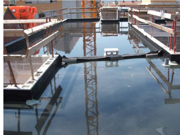
Proves d'estanquitat a planta coberta
