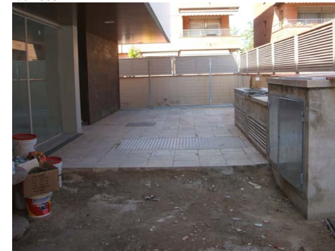
La superfície de sobre del generador i recinte de la caldera, pavimentats, i tapa del generador, al seu lloc.
