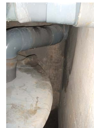
Visió lateral de la connexió del tub de drenatge cap al dipòsit de fecals.
