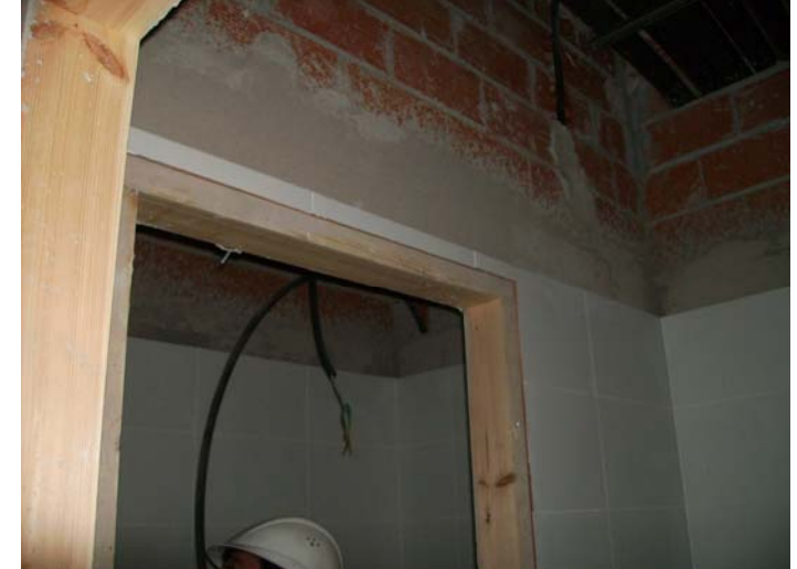
Mur interior que s'ha d'enderrocar per a convertir-lo en un lavabo per a minusvàlids.
