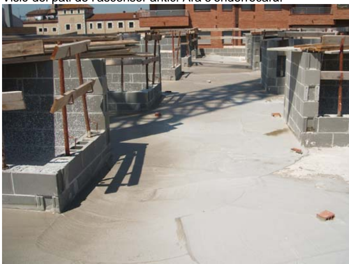
Inici de l'estesa del formigó per a pendents de la coberta.
