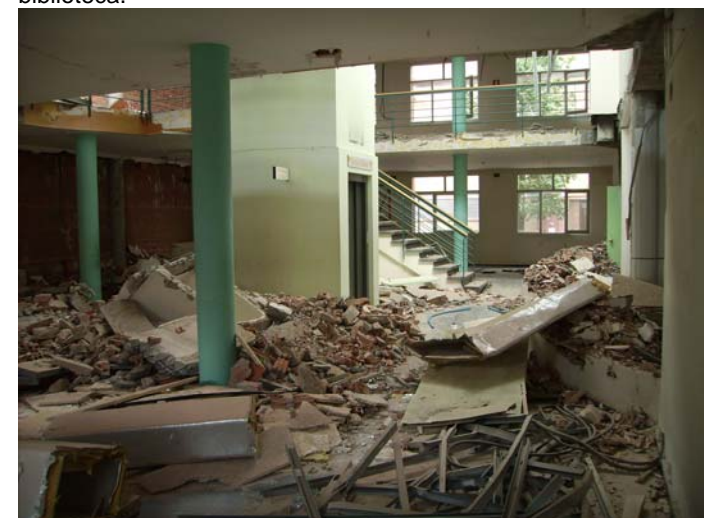
Enderrocs de tancaments, i estructura i instal·lacions de la biblioteca antiga.
