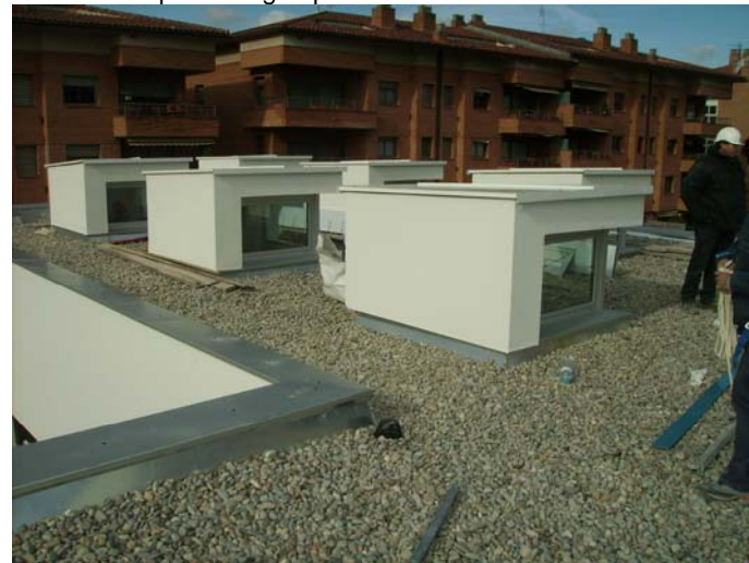
Coberta, de l'ala Nord, pràcticament acabada. Amb finestres a les claraboies i petites cobertes de planxa d'alumini.
