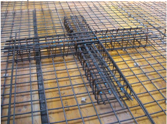
Creueta sobre un dels dos pilars. (el més proper a l'edifici nou)
