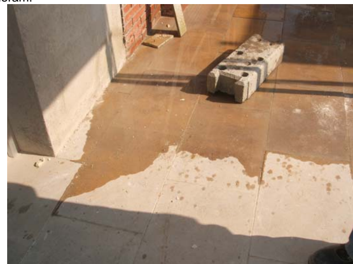
Prova de pendents del paviment de davant de la biblioteca. Els pendents han estat corregits.
