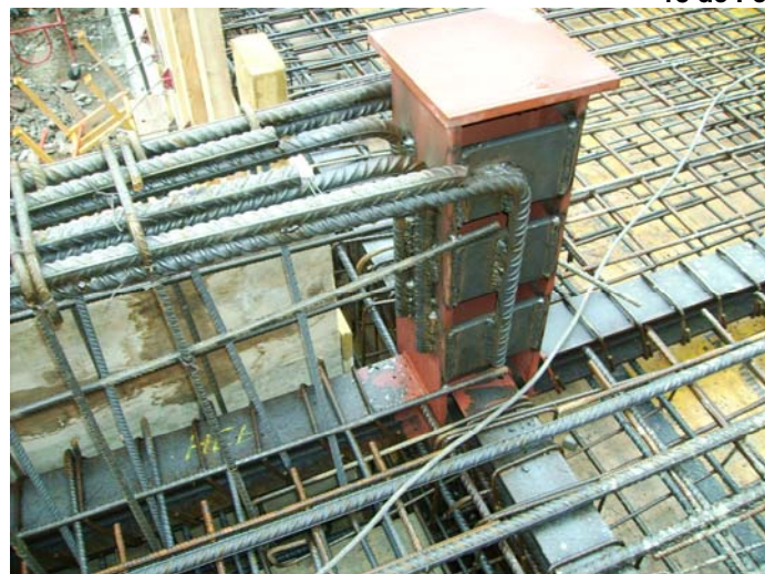
Unió de l'armat de la jàssera invertida, amb el pilar d'acer.
