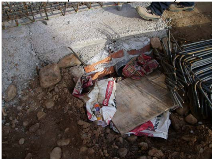
Sortida del sanejament de l'arqueta (1) al pati interior
