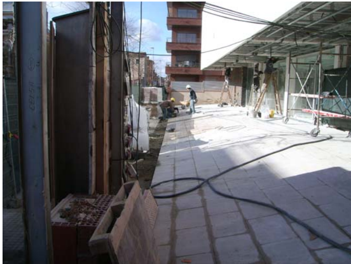
Entrada pavimentada amb llosa Vulcano.
