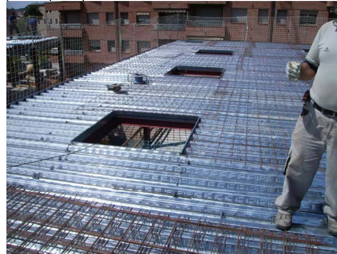
Estesa de la planxa col·laborant del forjat de coberta i armat. (ala nord)
