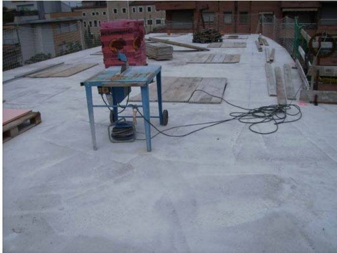
Forjat col·laborant de coberta, formigonat (ala Sud)
