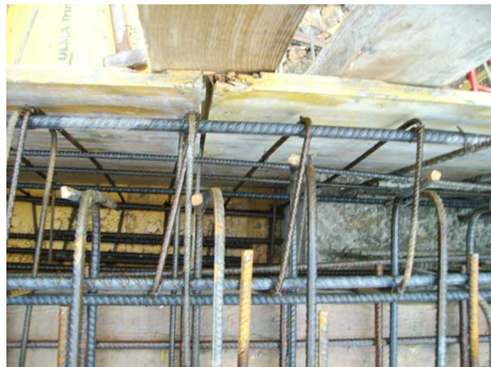
Final de la jàssera del mur de la sala polivalent. (a l'encaix)
