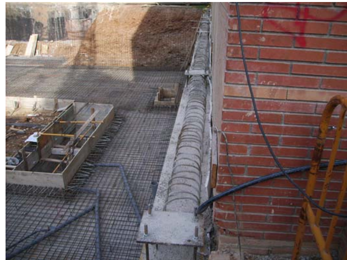
Armat de la llosa. No està armat totalment. Falta la zona de prop del mur del fons. Abans s'han de recalçar els fonaments del mur.
