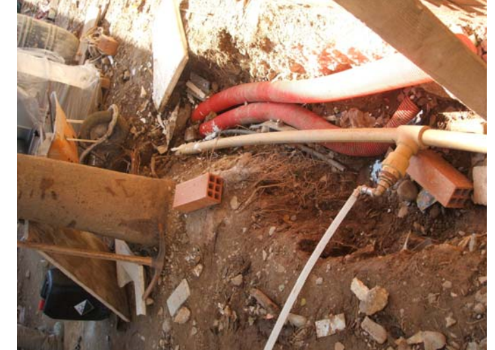
Conducció d'aigua cap a l'edifici.
