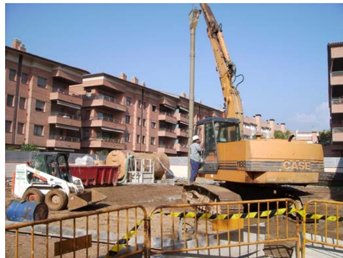
La mànega de l'embut de formigonat amb llots tixotòpics.
