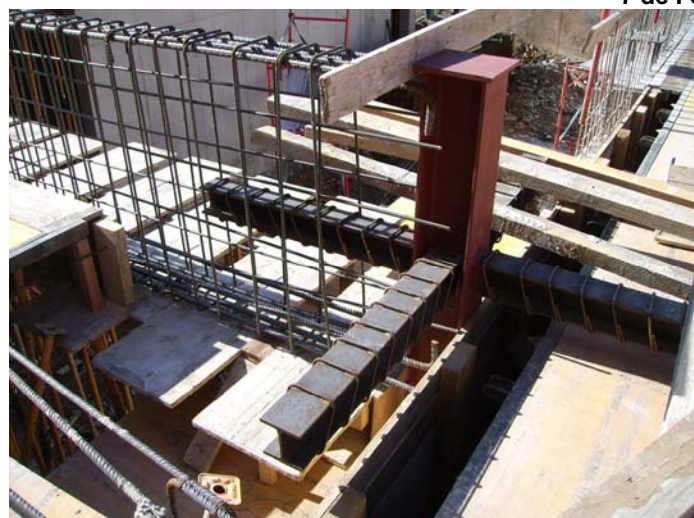
Inici de l'armat i de la unió de jàsseres de formigó amb el pilar d'acer.
