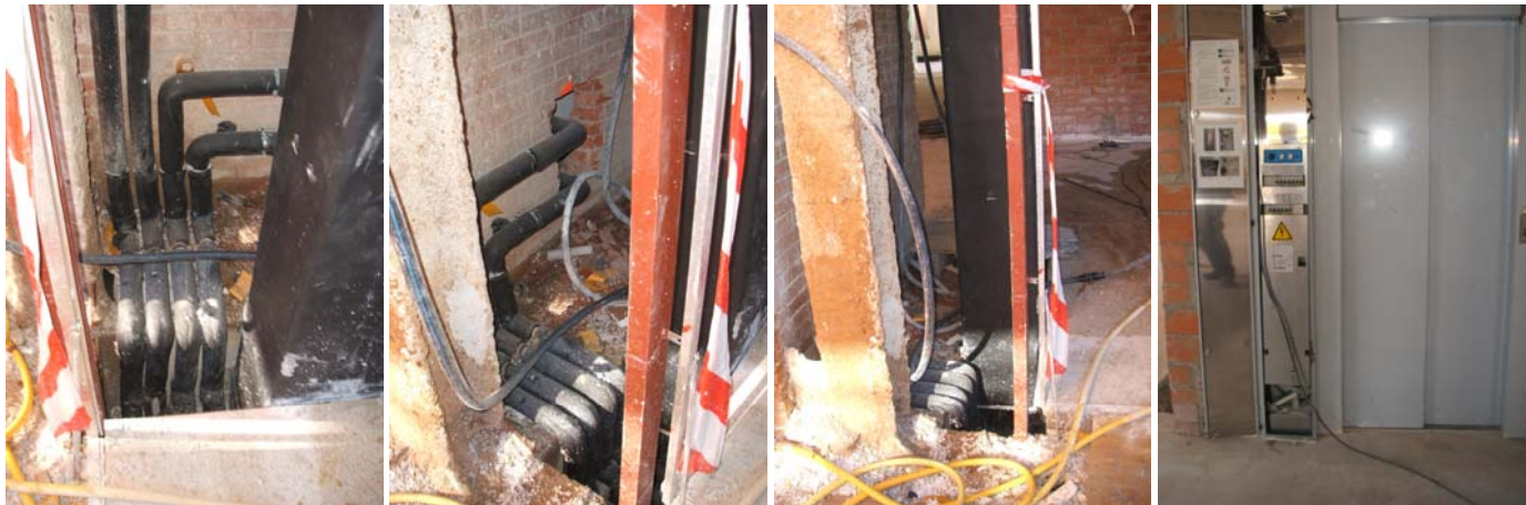
Conductes del sòl radiant i aire al límit de la biblioteca nova, planta baixa façana Nord.
