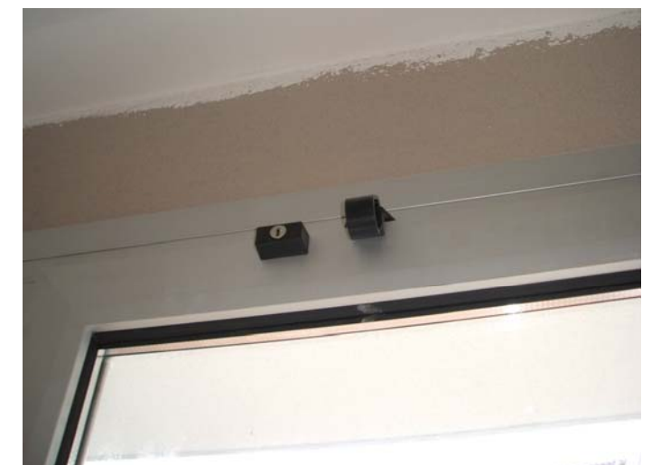
A les finestres practicables s'hi ha afegit un pany amb clau, per a que sols les pugui obrir el personal de la biblioteca.
