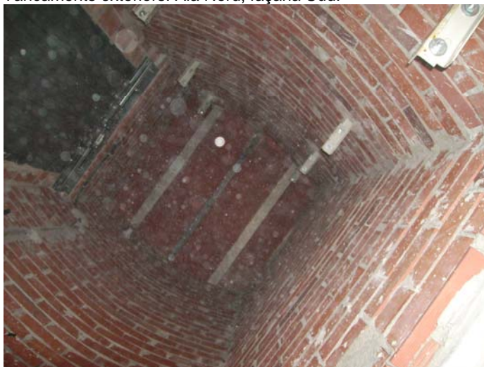
Visió del pati de l'ascensor antic. Ara s'enderrocarà.
