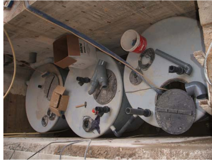
Treballs de connexió dels dipòsits de sanejament.
