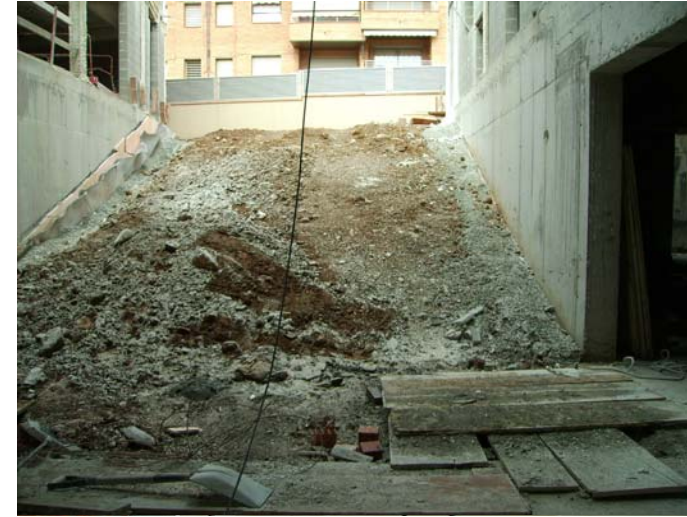
Terraplenat del pati central des del soterrani.
