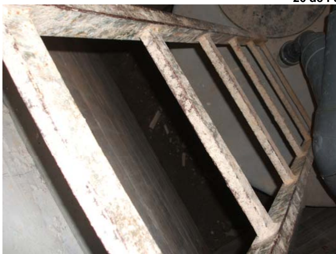
Nova inspecció del recinte dels dipòsits de sanejament, sota el porxo del soterrani.
