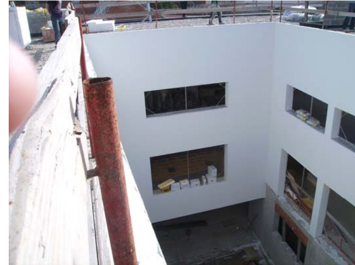
Visió general de l'estat del revestiment al pati interior.
