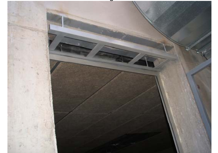
Nova llinda, acabada en obra per a la balconera de la sala polivalent. (amb l'encofrat del mur de formigó es va fer un forat massa gran)
