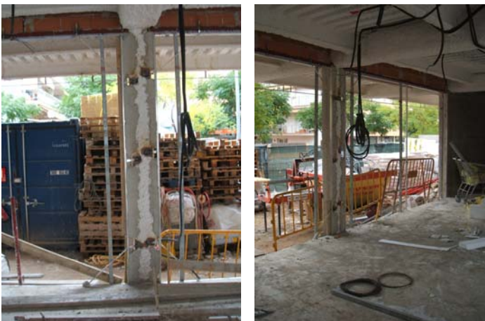
Finalment, es tapa amb obra, la part superior dels premarcs de finestra a Planta baixa. Fins a arribar al forjat.
