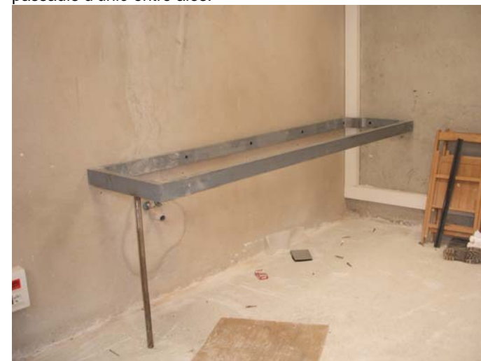
Estructura de suport del marbre de cuina de la sala de personal de la biblioteca.
