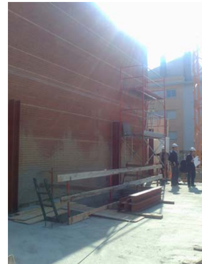
Col·locació de pilars a la junta entre edificis
