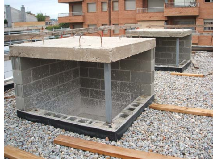
Pilarets de les claraboies, col·locats. (no previstos al projecte, però necessaris per estabilitzar, i com a base del premarc)
