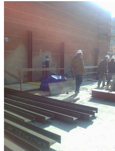
Col·locació de pilars
