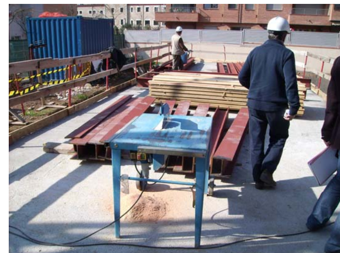
Ala Sud. Treballs amb l'acer dels pilars
