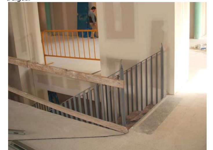
Construcció de la barana amb brèndoles de l'escala principal.
