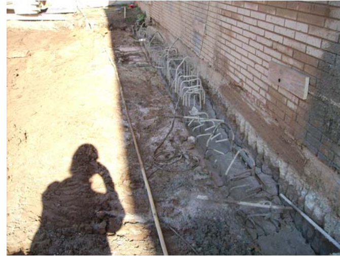
Pantalles formigonades. Falta l'extrem
