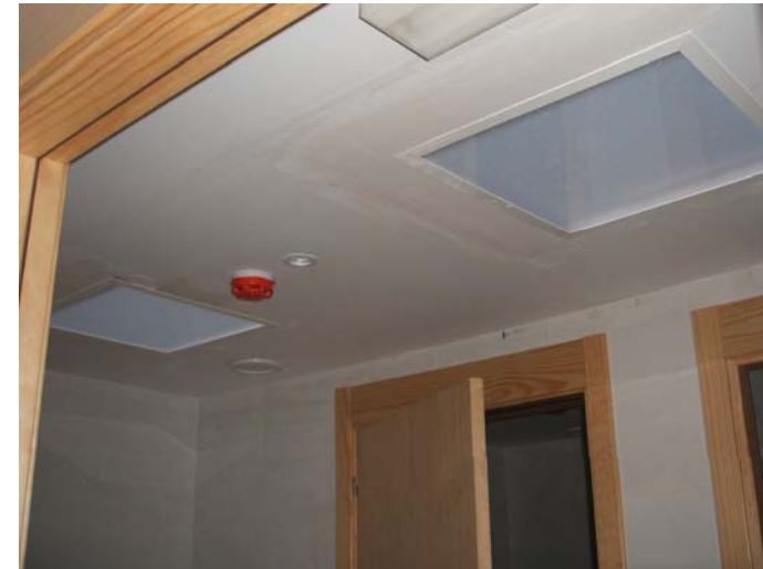
Claraboies al distribuïdor dels lavabos de la planta pis.
