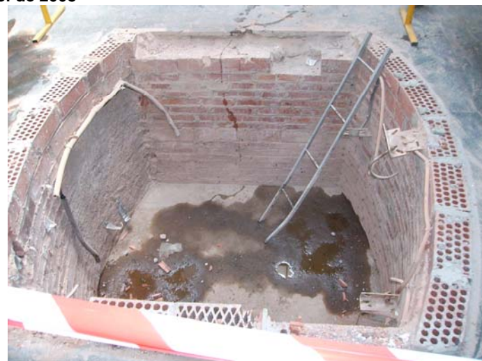
Un cop enderrocades les parets de l'ascensor antic, queda el pou de l'ascensor.
