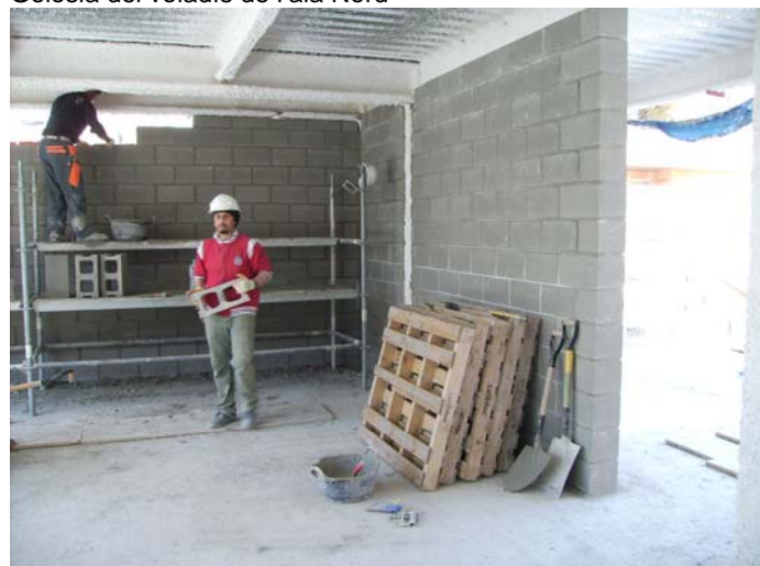
Inici dels tancaments exteriors de Planta Baixa en bloc de formigó. (Fons de l'ala Nord)
