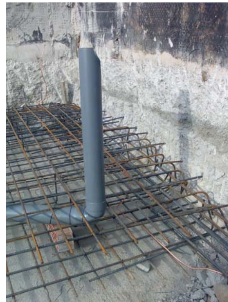
Armat llosa ala Nord. Trobada amb el mur del garatge veí. Ancoratge al recalçat.
