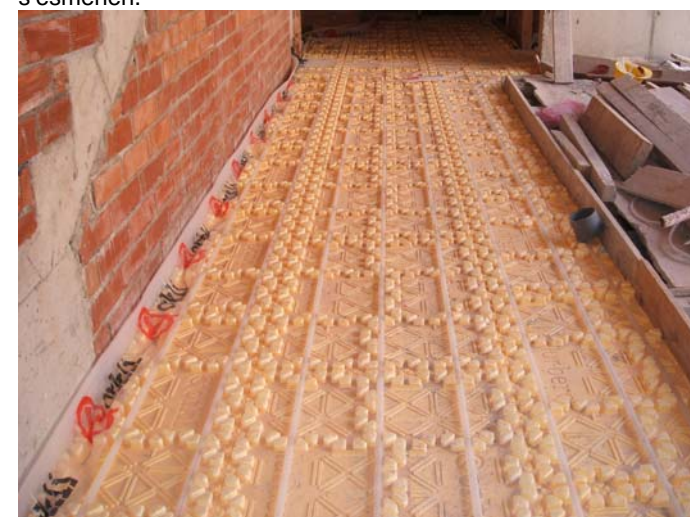
S'estenen les planxes aïllants pel soterrani, i comença el traçat dels tubs del terra radiant.
