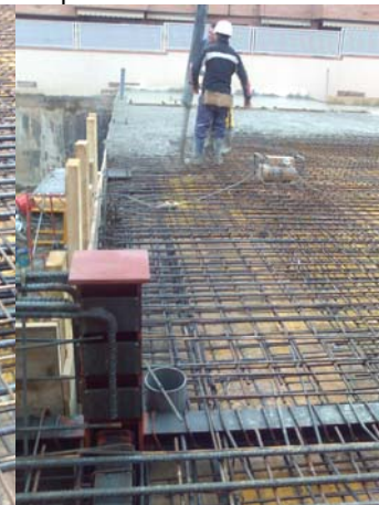
Es comença a formigonar la part acabada.
