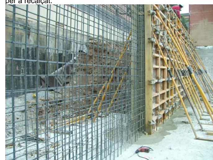
Inici de l'encofrat del mur de contenció de terres del jardí Nord. A l'esquerra es veu el tub de drenatge del veí. (de color groc)
