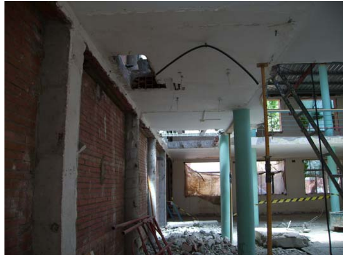
Estat dels enderrocs. Ja s'ha enderrocat la segona escala.
