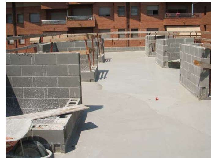
Ala Nord de l'ampliació. Enlestides pendents de coberta.
