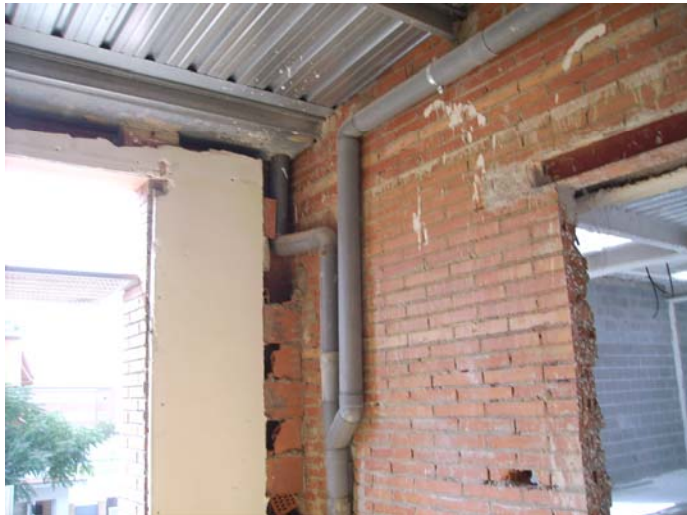
Connexió de part de la nova coberta al baixant antic.
