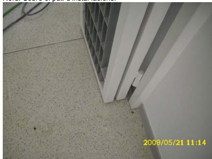
Elements de fixació de les portes i forats al terratzo.
