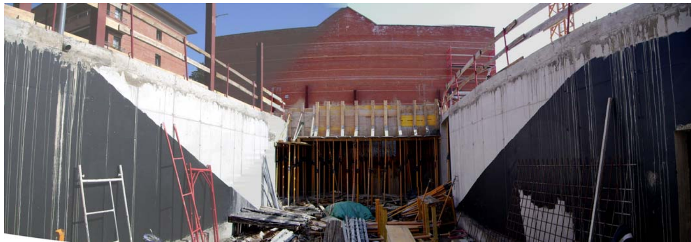
Murs de contenció pintats, i inici de la col·locació dels pilars de Planta Baixa. (composició a partir de 3 fotos)
