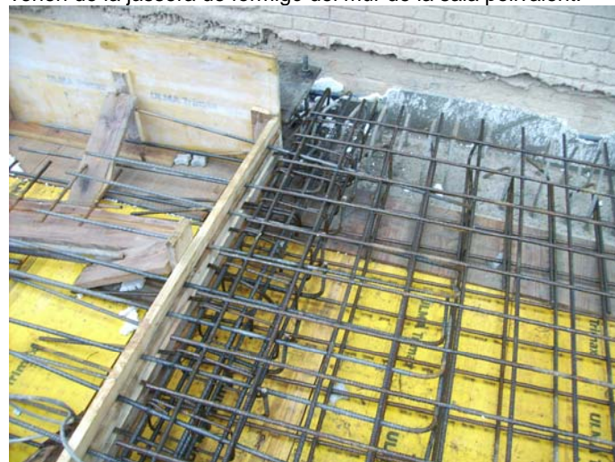
Armat del inici de l'escala al soterrani, i esperes per al la llosa inclinada.
