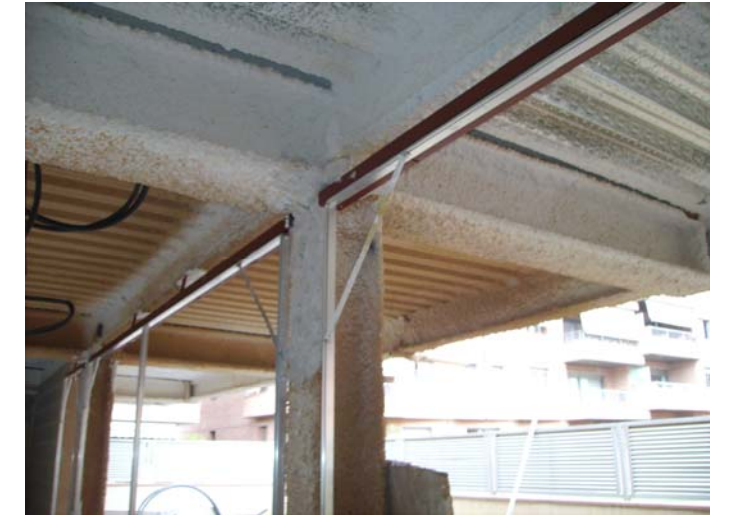
Col·locació de premarcs als grans finestrals de la façana Nord, de l'ala Nord.
