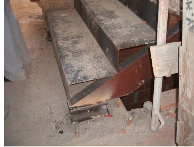
Col·locació de la nova escala principal. Recolzament a planta baixa.
