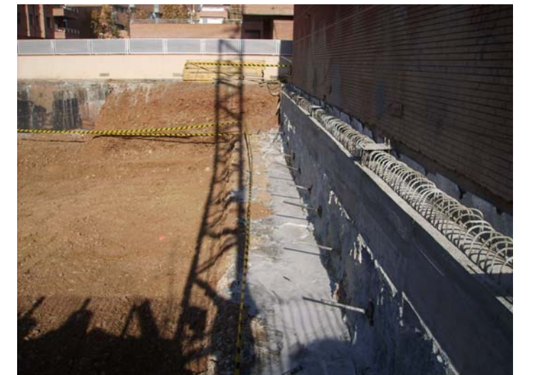
Visió general dels ancoratges, en tensió.
