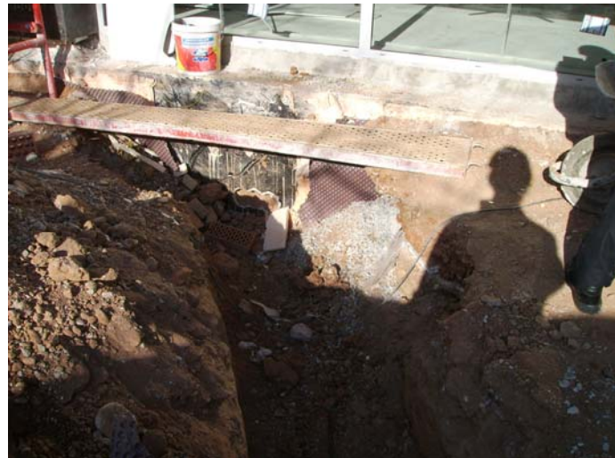
Rasa per a la connexió de telecomunicacions.
