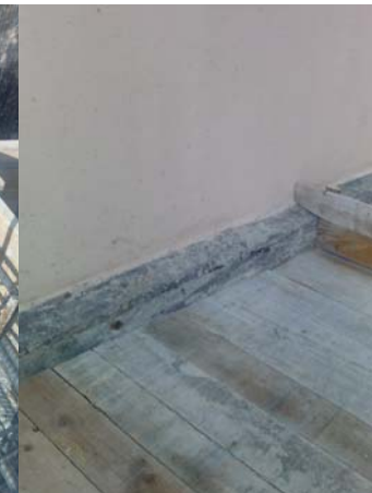
Trobada de l'ala Nord amb el mur veí. Es preveuen ancoratges.
