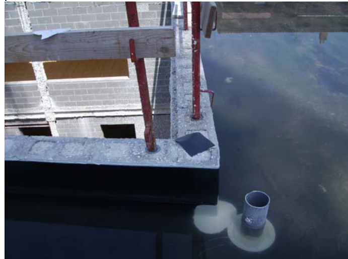
Continuen les proves d'estanquitat de la coberta.
