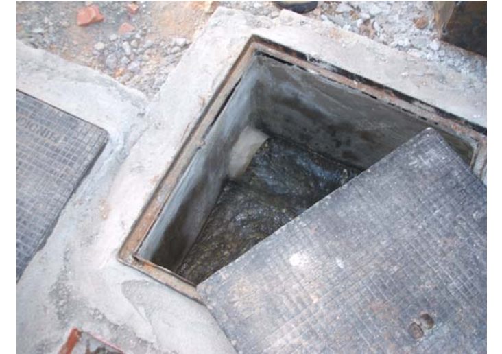
Prova del funcionament de les bombes del dipòsit de fecals.
