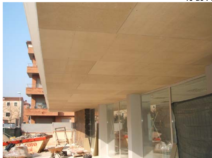
Col·locat el fals sostre de fusta del porxo de la entrada.
