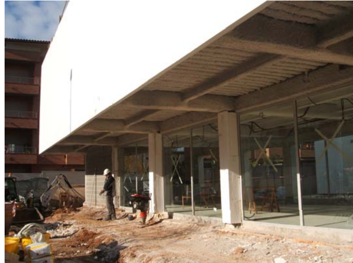
Preparació del terreny per a la solera del nou paviment de la entrada, resolt amb llosa Vulcano.
