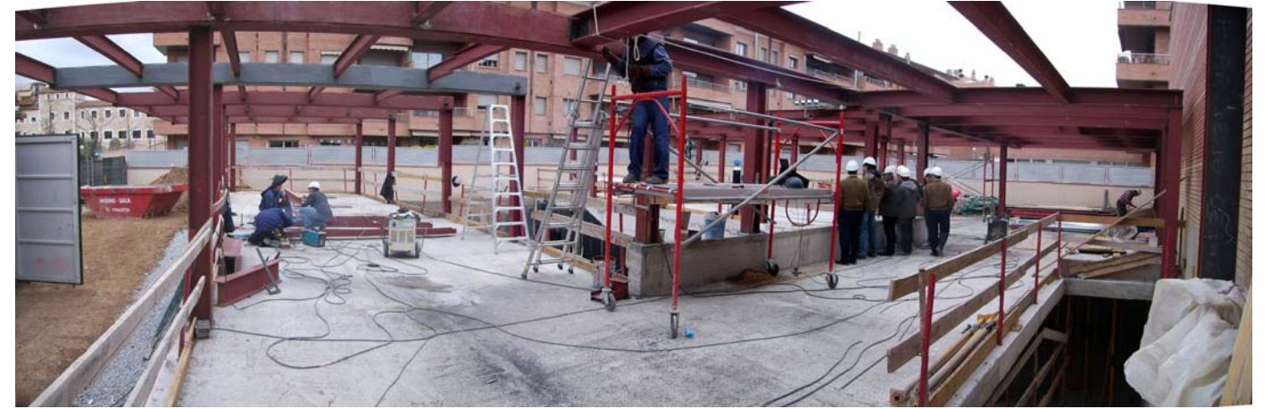
Visió general de la col·locació de les jàsseres i corretges del sostre de Planta Baixa.
