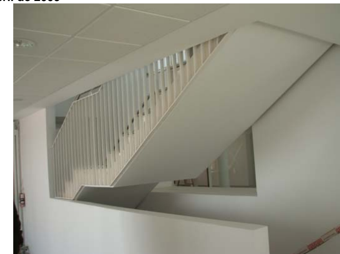
Escala acabada, amb revestiment ignífug.
