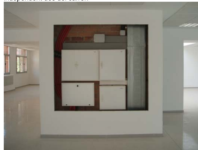
Cambra de pas d'instal·lacions i nucli d'ascensor al primer pis.
