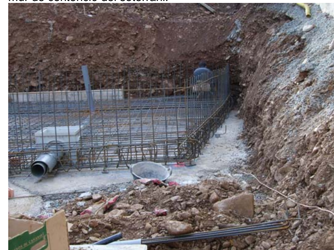
Final de la llosa de l'ala Sud.
