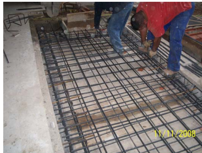
Armat de la llosa de sobre del recinte de dipòsits de sanejament.
