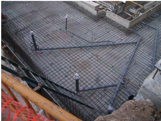
Visió armat de la llosa. Instal·lacions embegudes: Sanejament dels lavabos de soterrani i tub de ventilació del sanejament.
