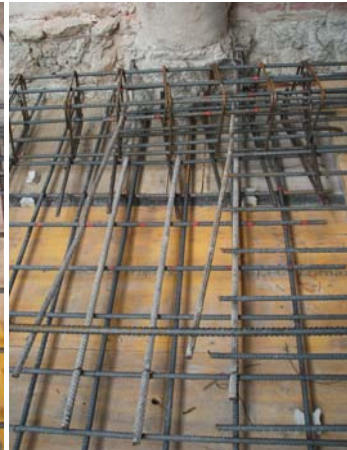
Armat de l'antiga jàssera plana, integrada a la nova llosa. Junta entre edificis.
