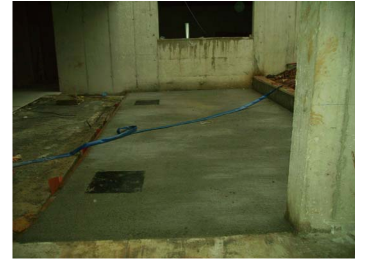
Fons de pati pavimentat, i arquetes amb tapa.
