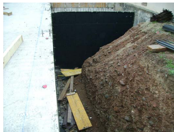
Mur de contenció del jardí Nord. Murs pintats amb imprimació.
