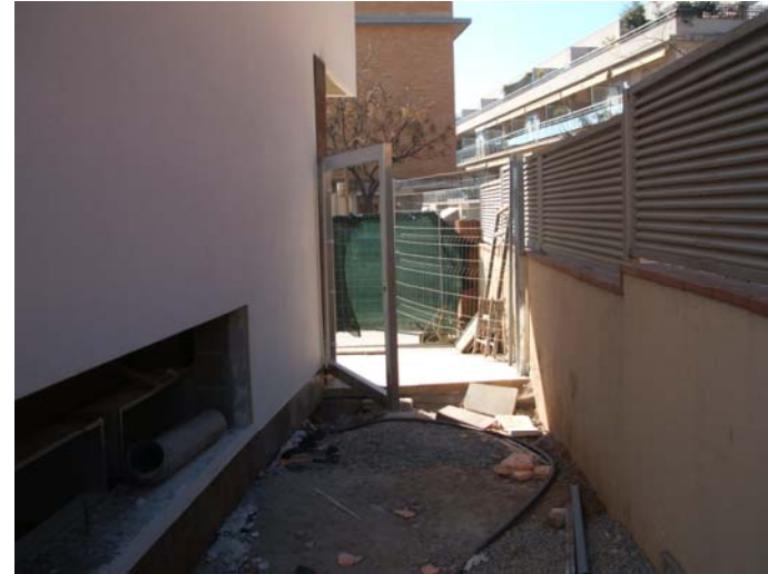
Nou marc de la tanca d'entrada.
