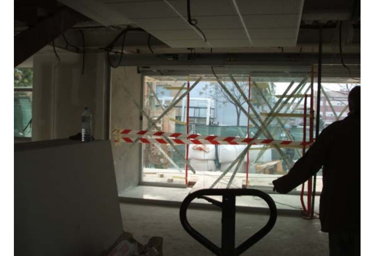
Porta automàtica de la entrada, col·locada sobre el seu marc.
