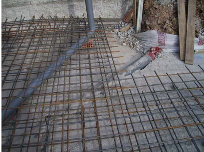
Aflorament del tub enterrat que arribarà fins al recinte del generador. (i arriba al nivell inferior de l'arqueta amb 2 nivells)
