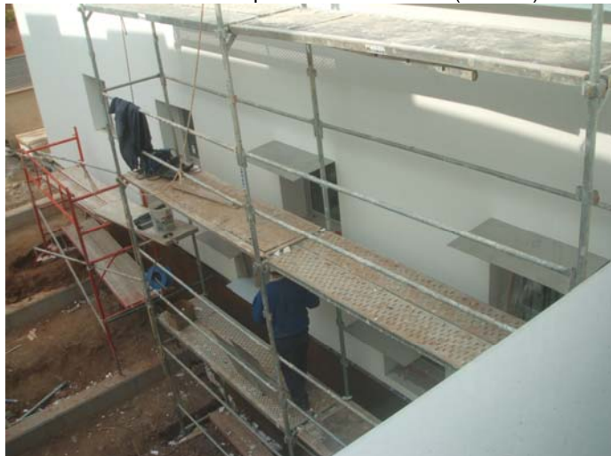
Inici de la col·locació dels brise-soleil d'acer inoxidable de la façana Sud de l'ala Nord.
