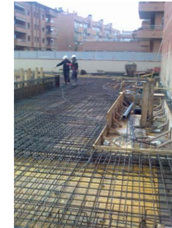
Armat de la zona de l'entrada a la Biblioteca. (Forat de l'escala)
