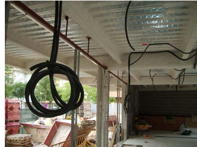
Col·locació de premarcs als grans finestrals de la façana Sud, de l'ala Sud.
