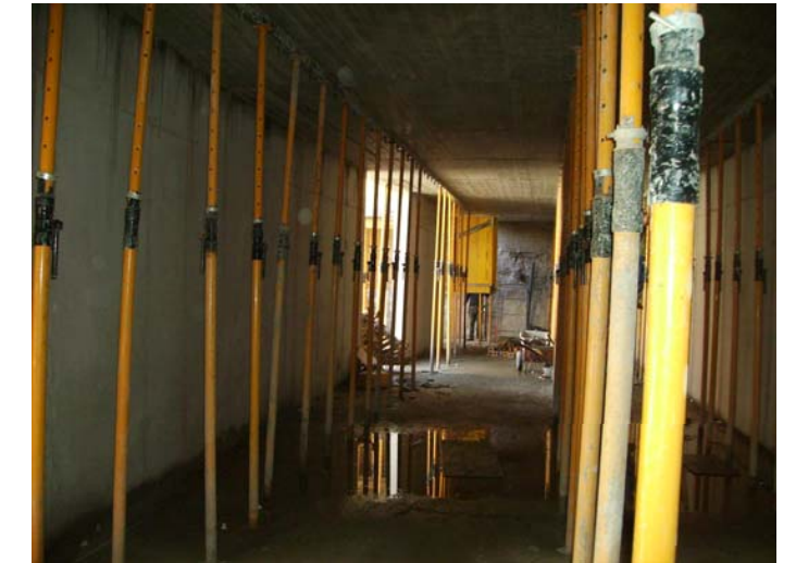
El forjat està apuntalat, però s'han tret les planxes d'encofrat.
