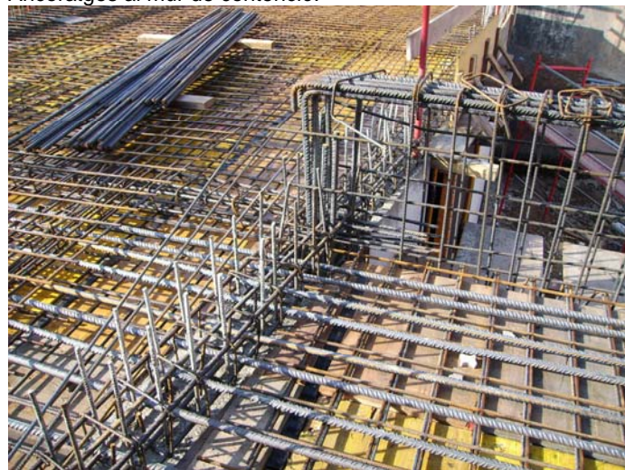
Es segueix treballant en l'armat. Aquí sols hi ha la capa inferior.
