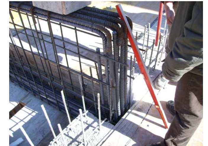
Extrem Sud de la jàssera que uneix les dues ales.
