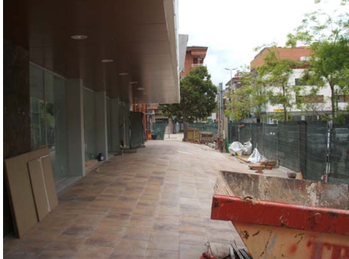
Porxo de l'entrada amb el fals sostre pintat i amb els llums. A rel d'una visita dels regidors municipals, es considera que el pendent de davant de la façana és massa fort, i es posarà una barana.
