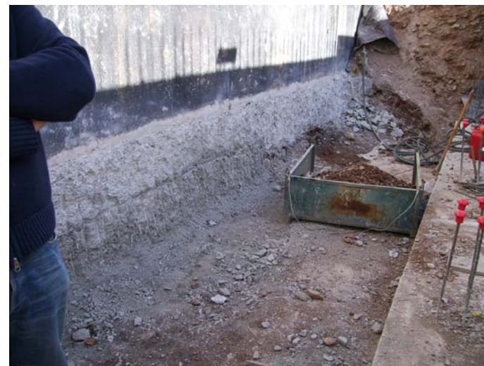
Treballs de repicat i recalçat, a la zona del generador.
