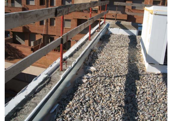
La col·locació d'aquest remat, permet veure l'aïllament.
