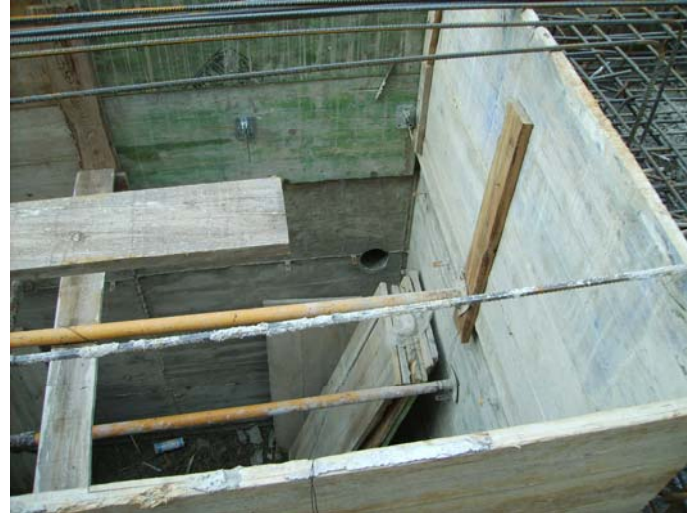
Forat al mur per al pas dels tubs de drenatge del pati. (recinte sota el soterrani)
