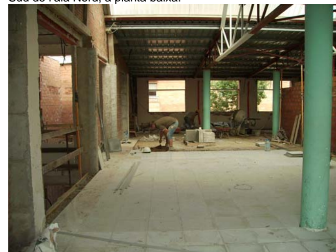
Pavimentació de la planta primera de la biblioteca antiga.
