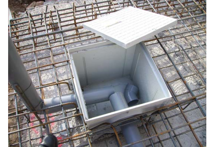
Arqueta al futur pati de instal·lacions del soterrani.
