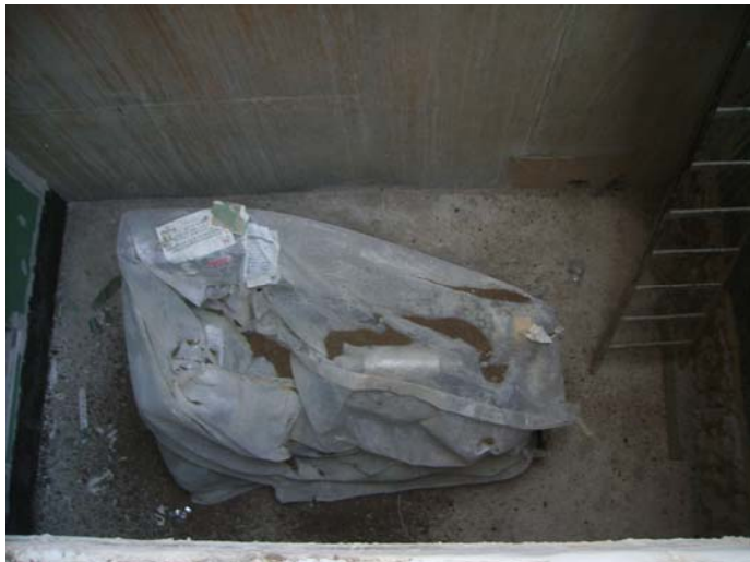
El generador ja està col·locat.
