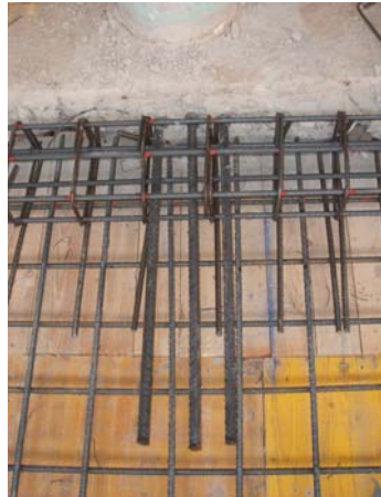
Tres rodons de connexió entre la nova llosa i l'antic forjat a l'altura dels pilars
