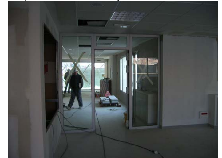
Fusteria interior. Porta de la sala juvenil al vestíbul d'entrada.
