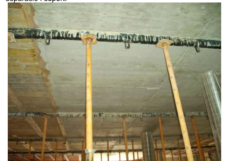
Llosa de la biblioteca antiga, parcialment desencofrada. (resta per desencofrar el vol, que té menys cantell).
