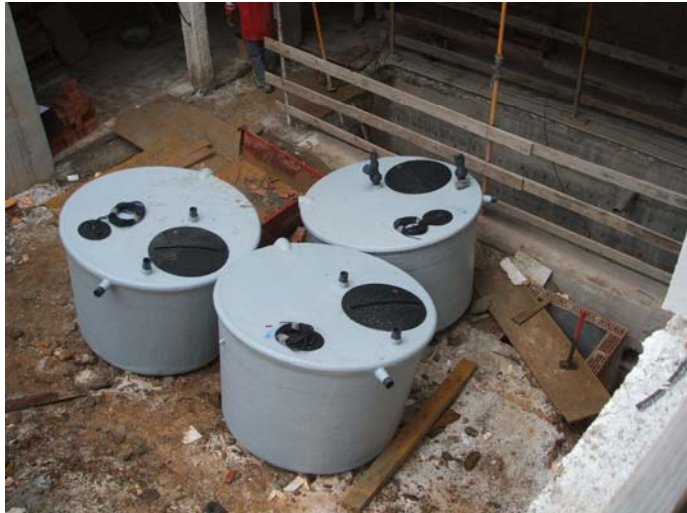
Els tres dipòsits amb bombes (2 per a pluvials i 1 per a fecals) abans de situar-los al seu fossat del soterrani.
