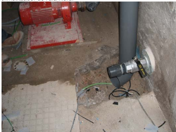
Treballs de connexió del sobreeixidor amb l'arqueta.
