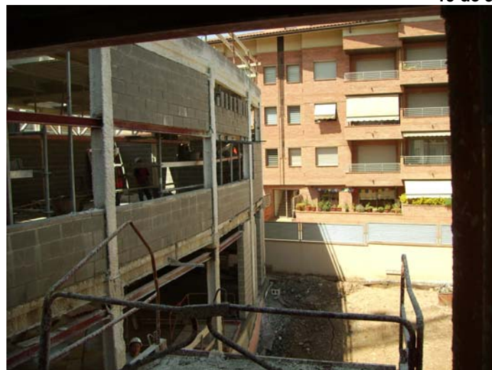
Tancaments exteriors Ala Sud, façana Nord.
