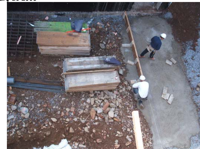
Capa de neteja per a la construcció del nou passadís entre ales.
