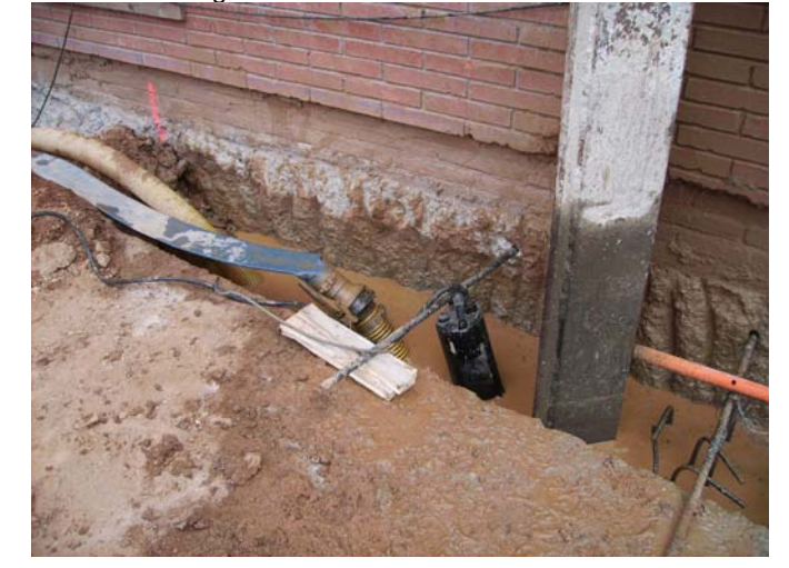
Embut de formigonat i bomba per als llots.
