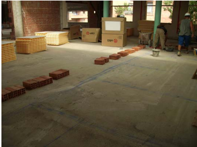
Replanteig dels lavabos nous al primer pis de l'edifici antic. Sobre la nova llosa.
