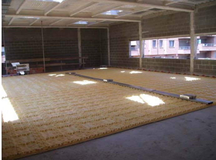
Estesa de planxes aïllants a l'ala Nord del primer pis. Safates per a instal·lacions, embegudes al terra radiant.
