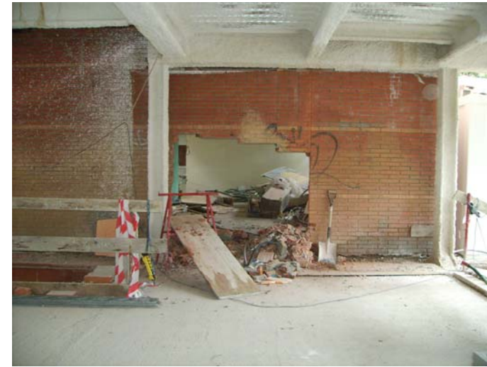
Obertura de porta entre l'edifici antic i el nou, a Planta Baixa.
