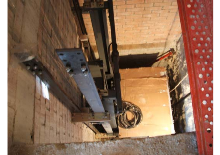
Inici dels treballs d'instal·lació de l'ascensor.
