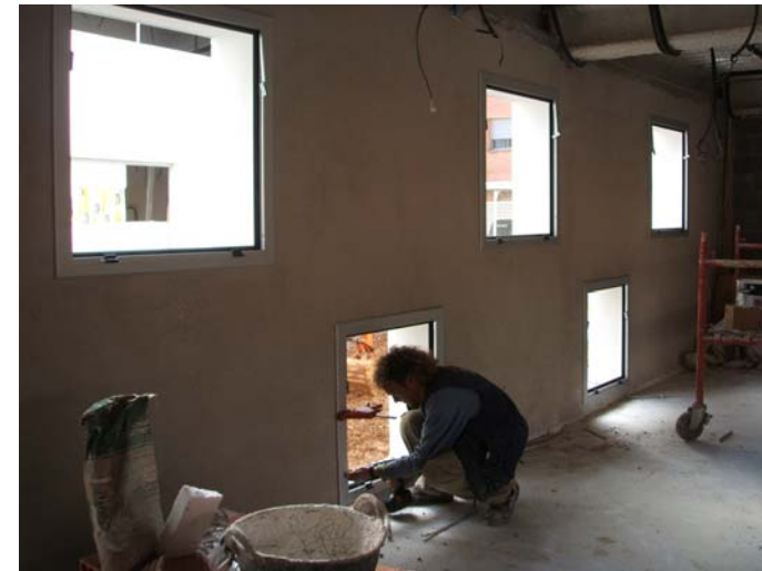
Inici de la col·locació de la fusteria d'alumini.
