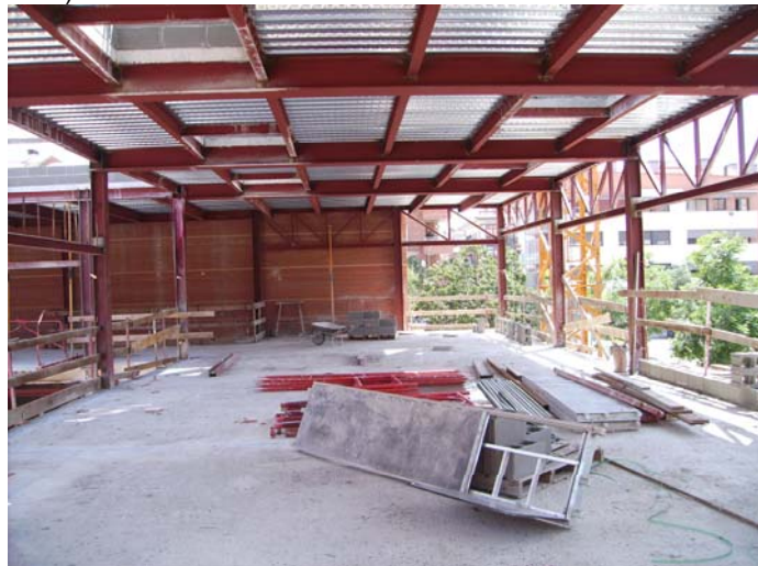
Primers treballs d'estintolament de la mitgera de l'antiga biblioteca.
