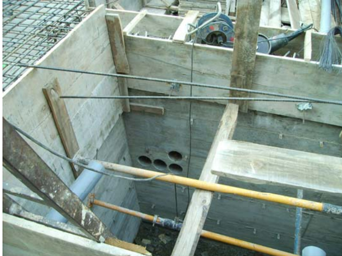
Forat al mur per al pas dels tubs de drenatge del pati. Forats al mur per al pas de sortida dels tubs de sanejament.
