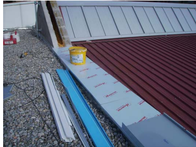
Remat de coronació de la junta entre els edificis. S'ha construït un mur triangular, igual que el de l'edifici antic, per a poder rematar bé aquesta unió.
