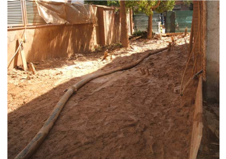
Situació dels pous geotèrmics fets.
