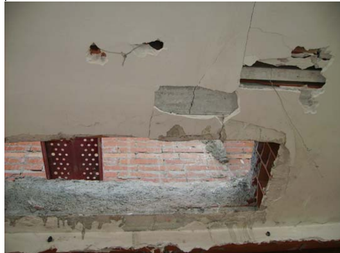
Detall del forat de pas d'instal·lacions.
