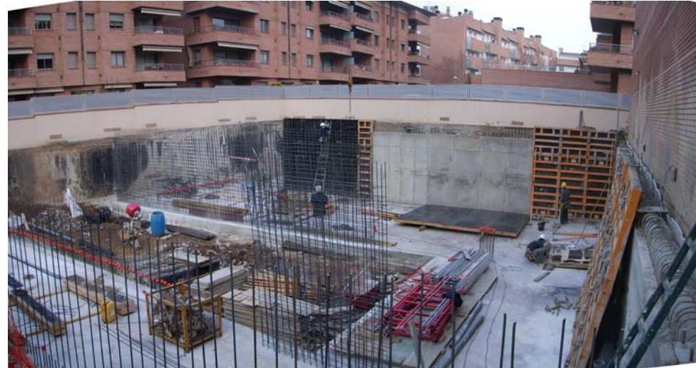
Visita al dia següent. Desencofrat, i encofrat del següent tram del mur de la cara Nord de l'ala Nord. Estat general de l'obra. 17 de Gener de 2008
