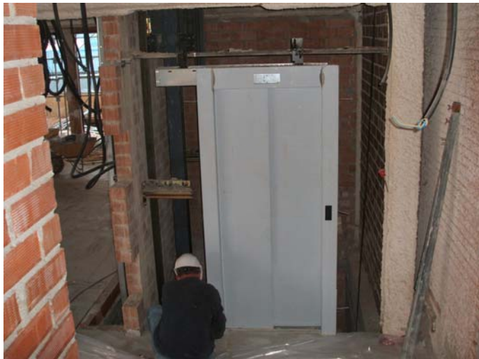
Instal·lació de la porta de l'ascensor a planta baixa.
