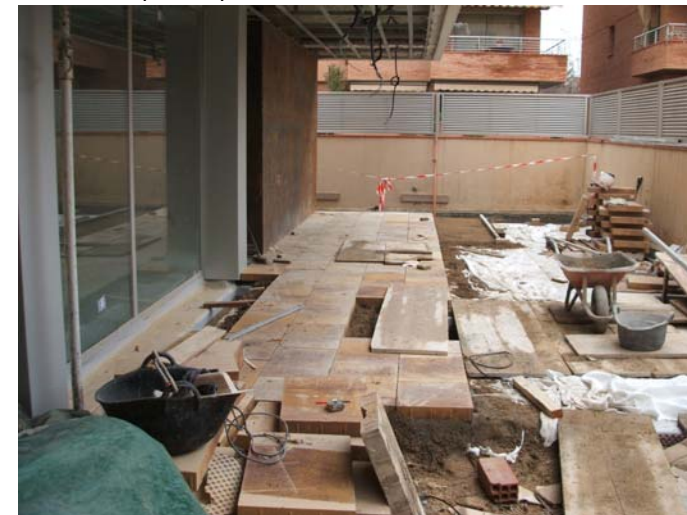
Pavimentació de la llosa sobre el generador i recinte de la caldera.
