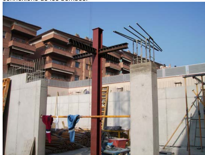
Pilars i murs de formigó, preparats per a la trobada amb la jàssera de formigó, i pilar metàl·lic amb la creu per a quedar embeguda a la llosa del primer forjat.
