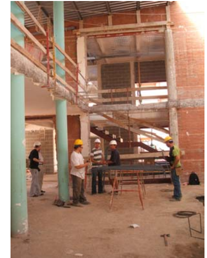
Forjats retallats i jàsseres planes amb l'armadura per a embeure a la nova llosa.
