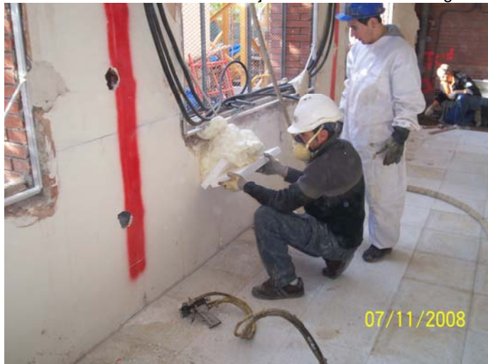
Aïllament de les cambres de la façana de la biblioteca antiga.
