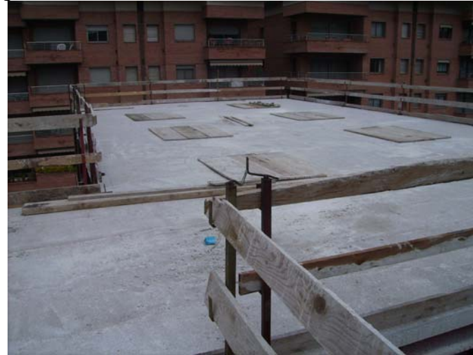
Forjat col·laborant de coberta, formigonat. (Ala Nord)
