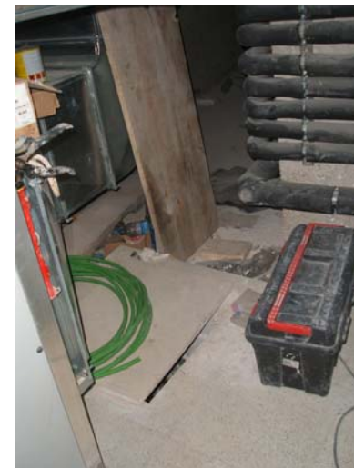
Pas d'instal·lacions de climatització i terra radiant cap al passadís d'unió entre ales.
