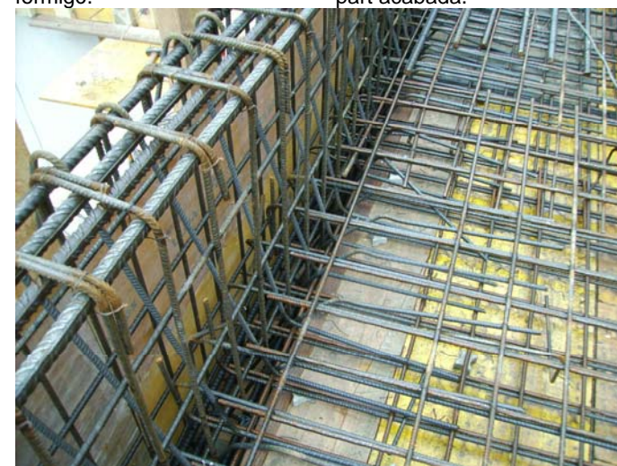
Jàssera amb l'armat complet.
