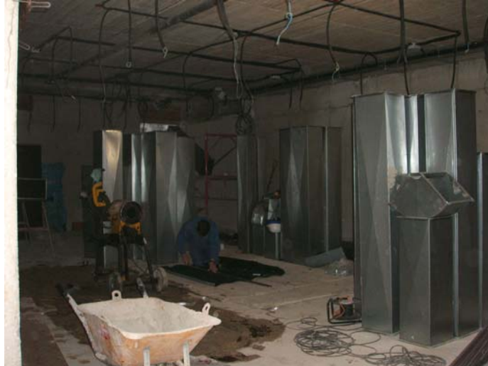
Inici de les instal·lacions d'aire condicionat.
