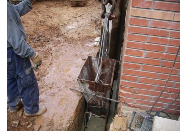
Embut de formigonat.
