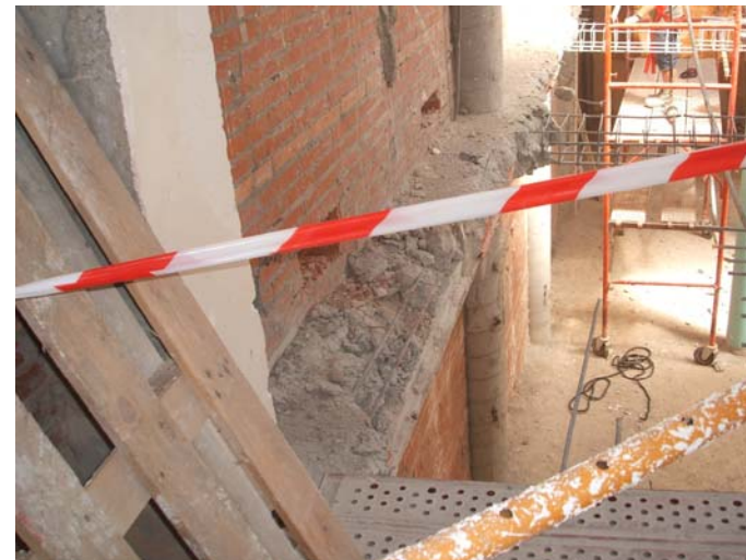
Enderroc de forjat a la biblioteca antiga. Estat de la riostra entre pilars.
