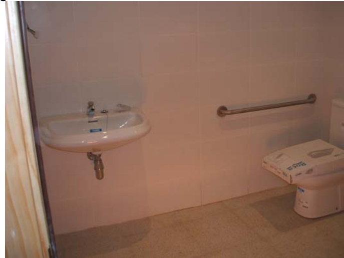
Lavabo minusvàlids del soterrani (homes)
