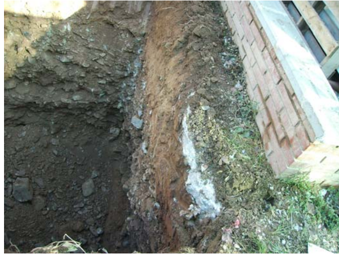
18-10-07: Excavació del dau de la grua.
