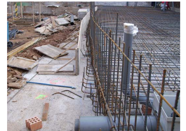
Llosa de fonamentació de l'ala Sud-pati interior.
