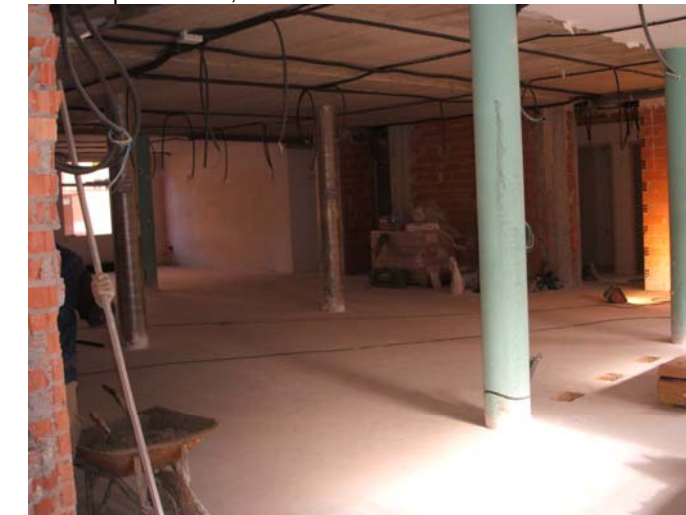
Tancaments interiors, i instal·lacions a la planta baixa de l'antiga biblioteca.
