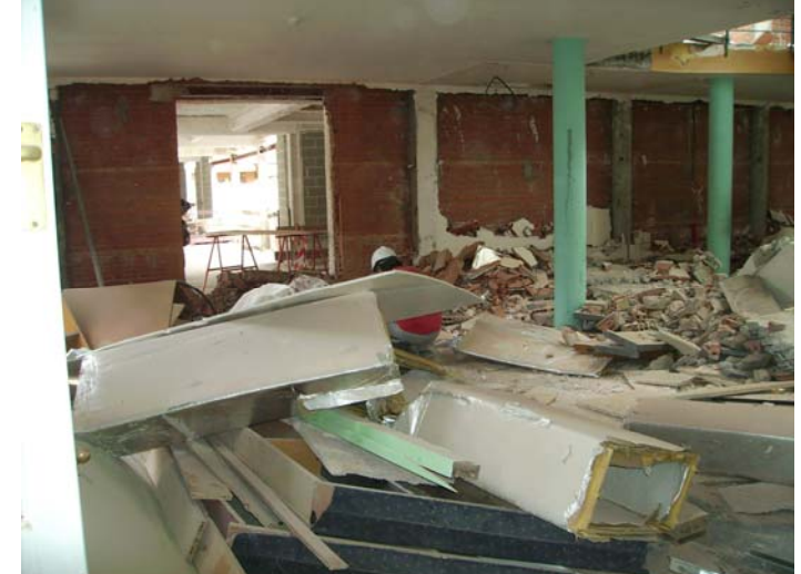
Obertura feta, amb biga col·locada, i vist des de l'antiga biblioteca.
