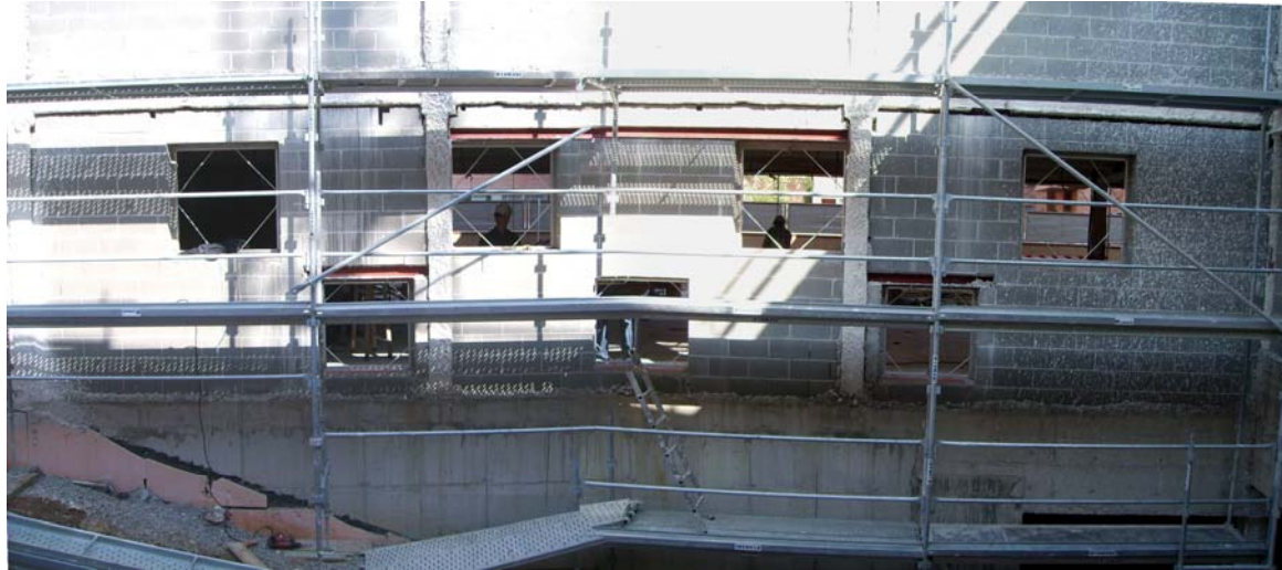
Inici dels treballs per al revestiment exterior de les façanes del pati interior (composició de dues fotos)
