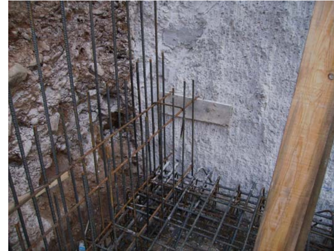
Ancoratge de l'armat de la llosa al mur pantalla. Esperes del mur de contenció del soterrani.
