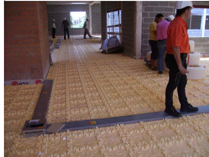
Estesa de planxes aïllants per al terra radiant, i canals enterrades al primer pis.
