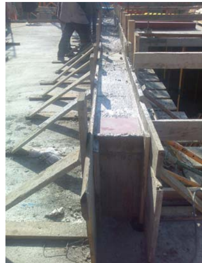
La jàssera invertida, ja formigonada
