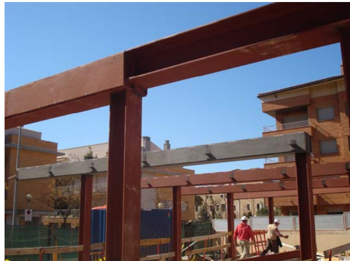
Jàsseres empletinades col·locades.
