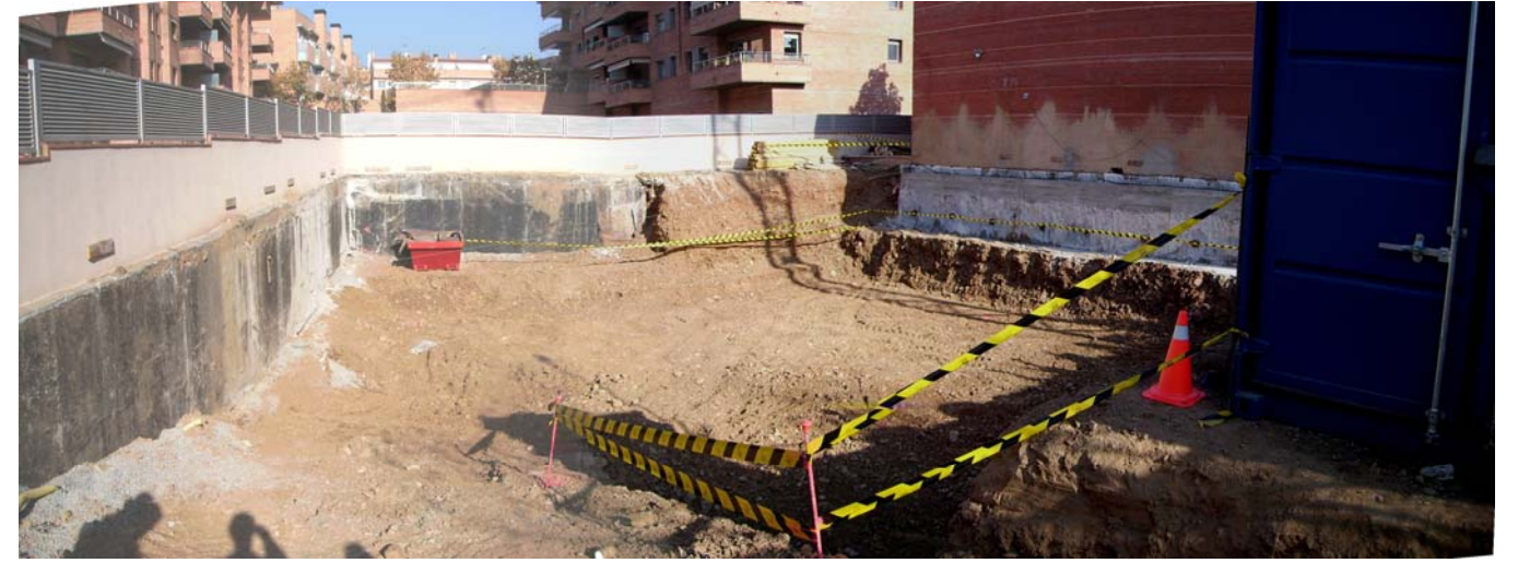
Visió general de la excavació.
