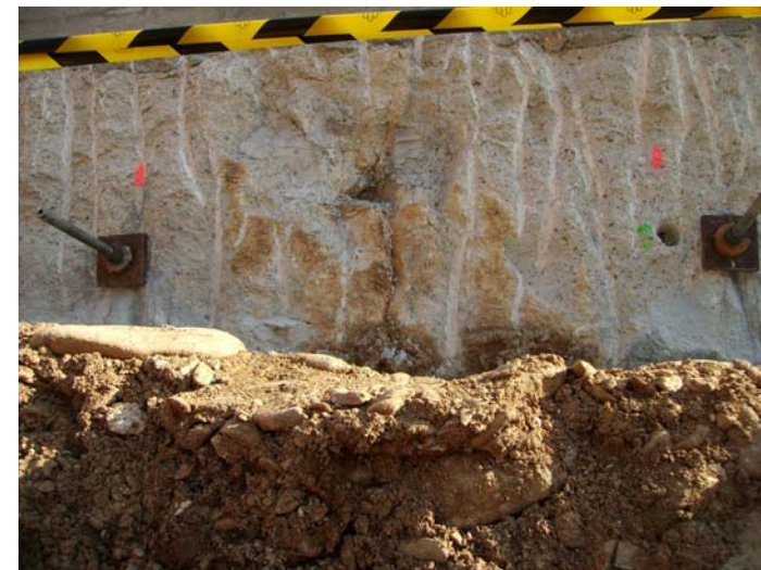
Detall del tercer i quart ancoratge (des de l'esquerra) Ancoratges cargolats.
