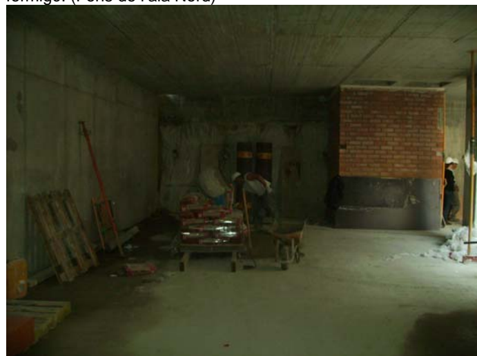
Tancaments interiors al soterrani (Murs de l'ascensor)
