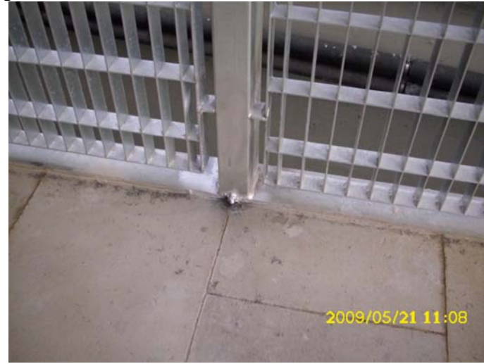
Fixació complementària dels pilars de la tanca del fons del pati Nord. Sobre el pati d'instal·lacions.
