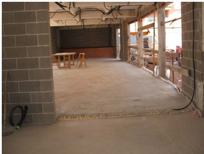
Sòl radiant, amb aïllament, tubs i morter, preparat per a rebre el paviment.
