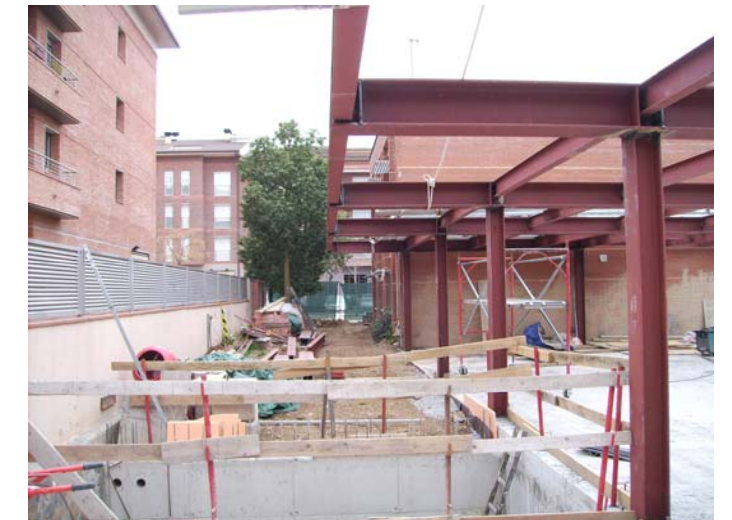
Vol del jardí de darrera. (ala Nord)Última jàssera, ja corregida. Del mur sobressurt l'aïllament i la làmina drenant. (ja reomplert amb terra el jardí Nord).
