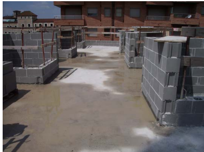
Construcció dels badalots de les claraboies.
