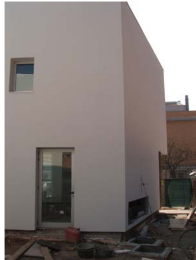
Situació de les arquetes de sanejament. Davant, la de pluvials, darrera la de fecals.
