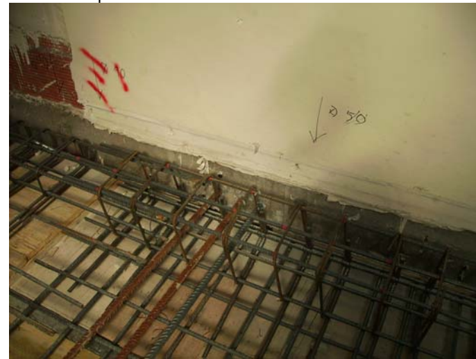
Ancoratge de la nova llosa amb l'antic forjat, a la zona de la façana amb el carrer Mare de Déu del Pilar.
