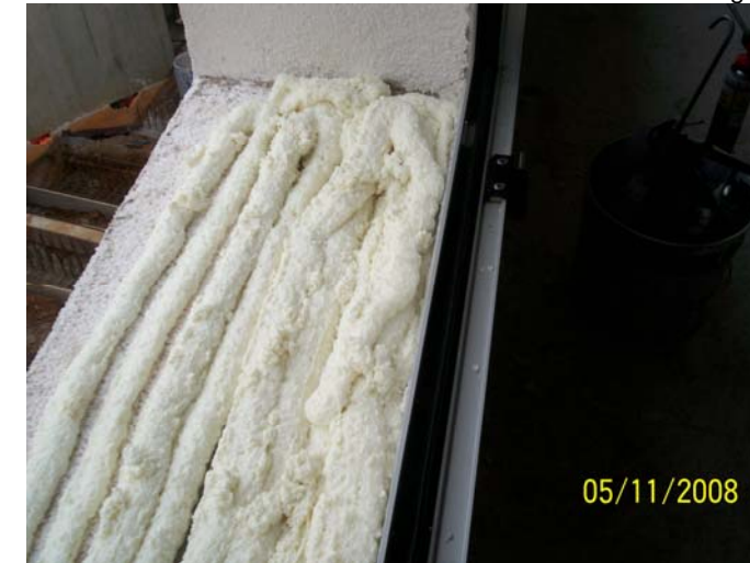
Aïllament als ampits de la biblioteca.
