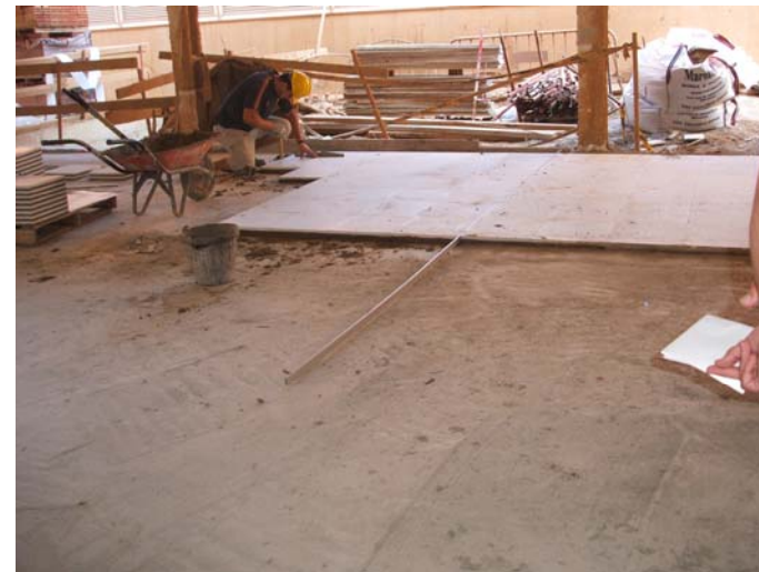
Col·locació de rajoles a l'ala Nord de la planta baixa. Col·locació de la junta de dilatació del paviment.
