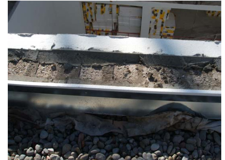
Realització de l'aïllament i remat perimetral de protecció a la coberta. A sobre d'això hi va el remat de coronació.
