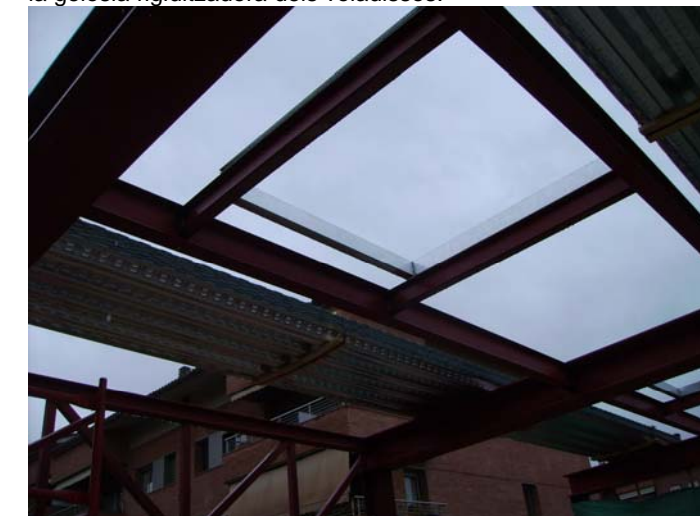
Planxa del límit del forjat col·laborant, per a conformar les claraboies.
