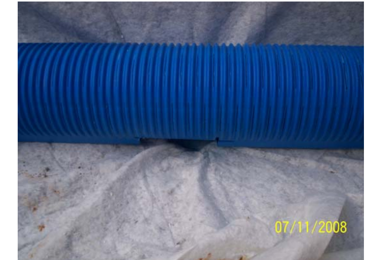
Detall del tub drenant.
