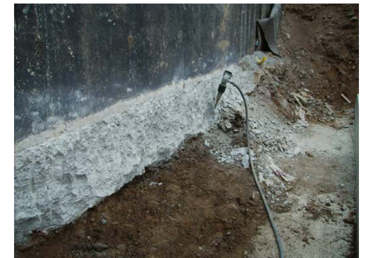
Repicat del fonament veí i excavació de la zona del generador per a recalçat.
