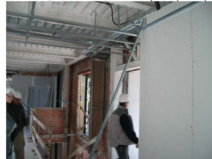
Zona de comunicació entre edificis a planta primera.
