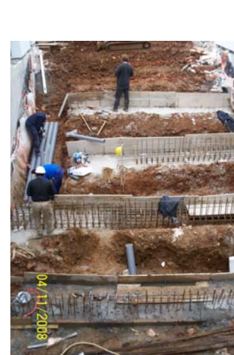
Construcció dels murets de contenció del pati central.
