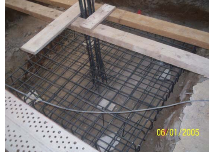
Armat de les sabates dels nous pilars
