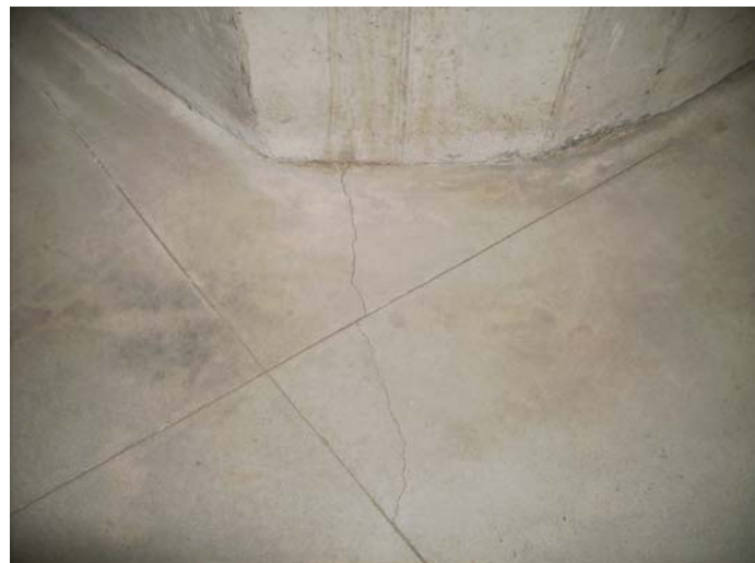
Cantonada del mur de formigó del garatge, que limita amb el solar de la Biblioteca
