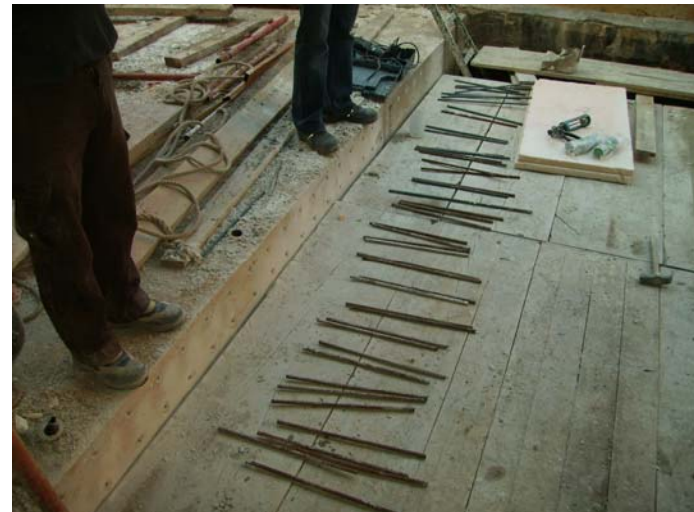
Preparació de la llosa. Ancoratges per a la connexió amb la nova llosa sobre el recinte del generador.
