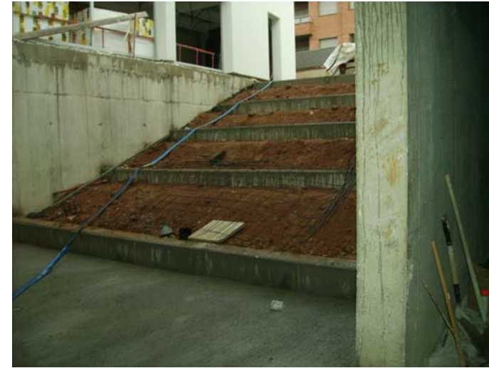
Murets del pati acabats.
