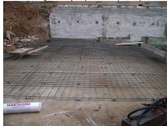
Inici de l'armat de la llosa de fonamentació de l'ala Nord.
