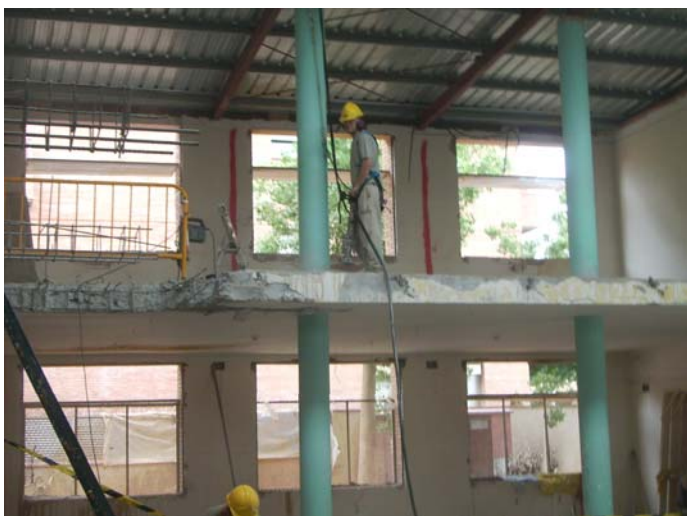
Treballs de repicat de voladissos de la biblioteca antiga.
