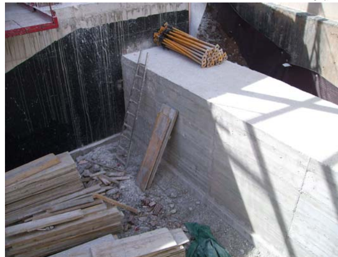
Passadís entre ales, formigonat.
