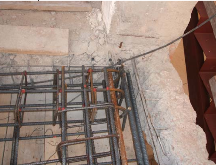
Connexió de la nova llosa amb l'antic forjat. Ancoratges en la posició del pilar.
