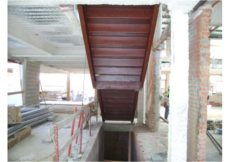
Col·locació de la nova escala principal
