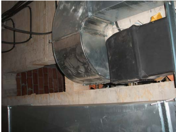
Connexió de l'aire condicionat des del soterrani(sala polivalent) cap a les plantes superiors.
