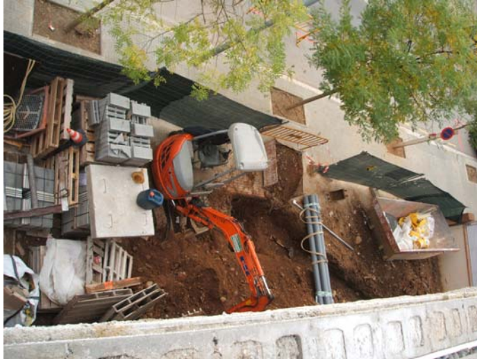
Rasa per a la connexió del sanejament i connexió amb la claveguera del carrer.
