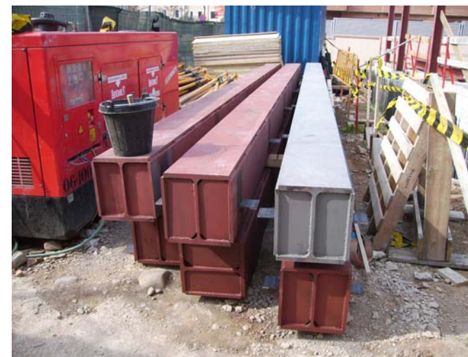
Abassegament de jàsseres empletinades de l'ala Sud.
