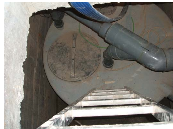
Primer dipòsit (extrem Nord). Pluvials. (fotografia feta des de la tapa d'entrada)
