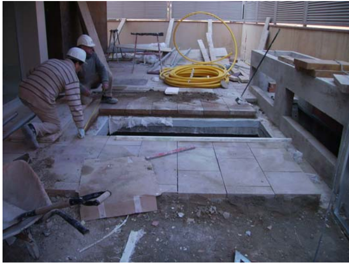
Treballs de preparació de la col·locació de la tapa del generador.
