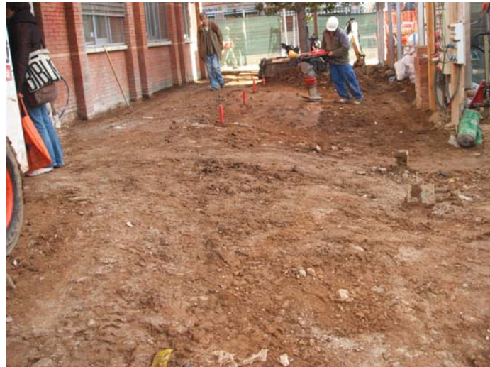
Treballs de piconat de la base per a la col·locació de la solera armada per al paviment de llosa Vulcano davant de la porta de la biblioteca.
