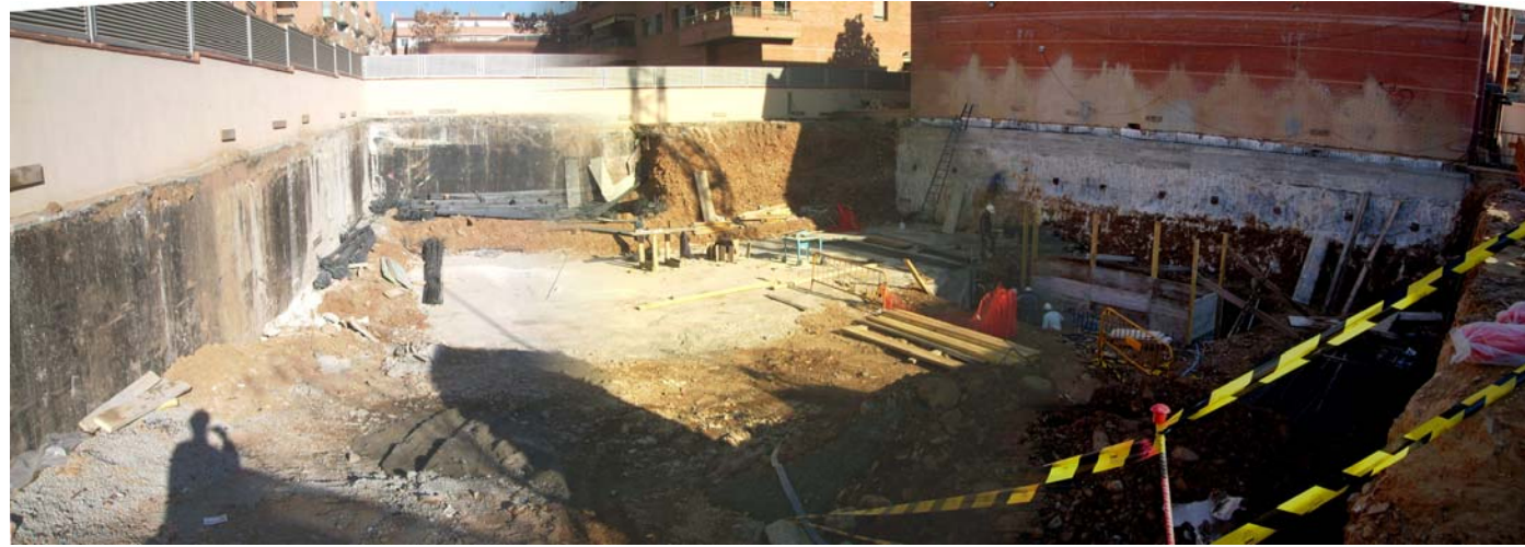
Visió general de l'obra. S'ha estès part de la capa de neteja de l'ala Nord, s'ha fet el pou de l'ascensor i s'està fent el fossat per al sanejament del soterrani i dels drenatges.
