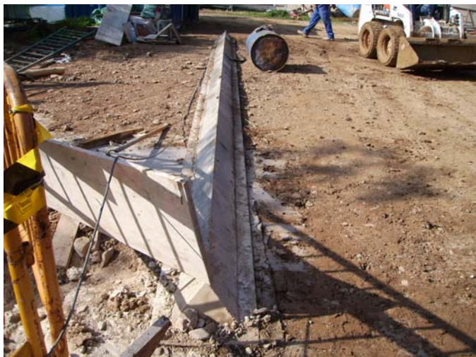
Peça d'encofrat de separació entre les diferents pantalles.
