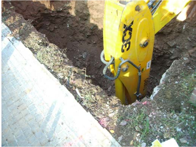
18-10-07: Excavació del dau de la grua
