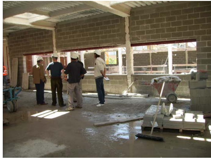
Tancaments exteriors. Planta pis, ala Nord, façana Sud.
