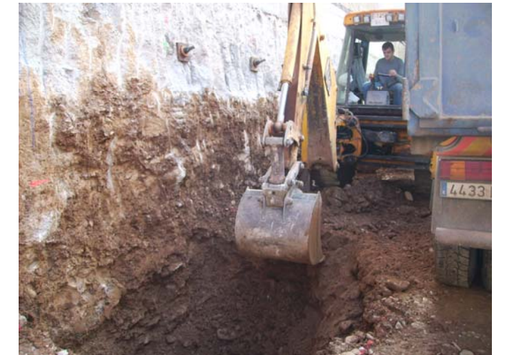
Inici d'excavació per als fossats de sota del soterrani (ascensor i desguassos i drenatge)
