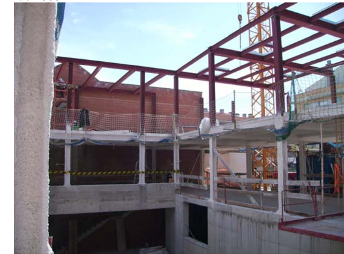
Estat de l'obra: Sostre de planta baixa, ignifugat. Forjat de coberta, en construcció.
