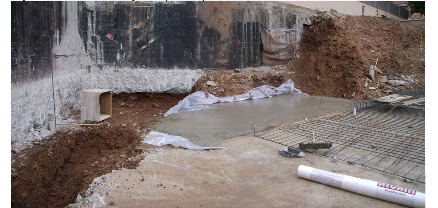
S'estén el formigó de neteja. Aquí es veu la primera part de fonament que s'ha de recalçar.
