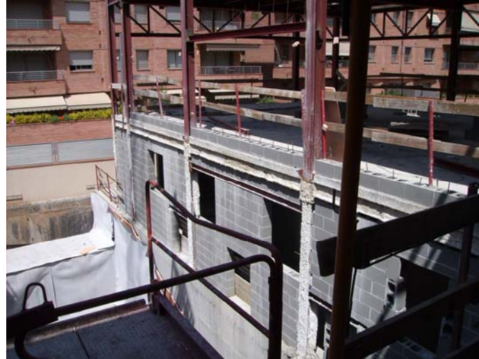
Primera filada del tancament de la façana del primer pis (ala Nord)
