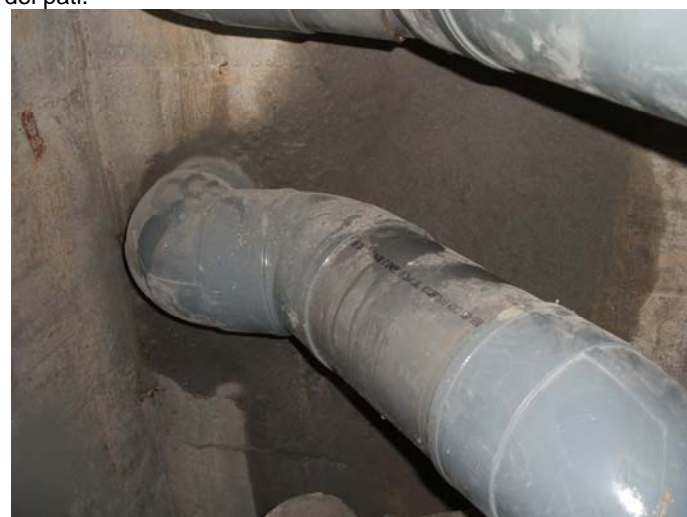
Recollida d'aigua de drenatge del pati cap al dipòsit de fecals.
