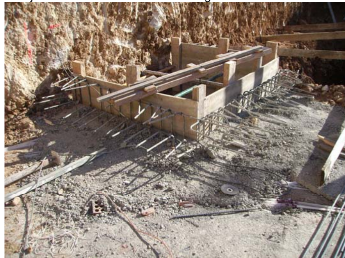
El fossat de l'ascensor
