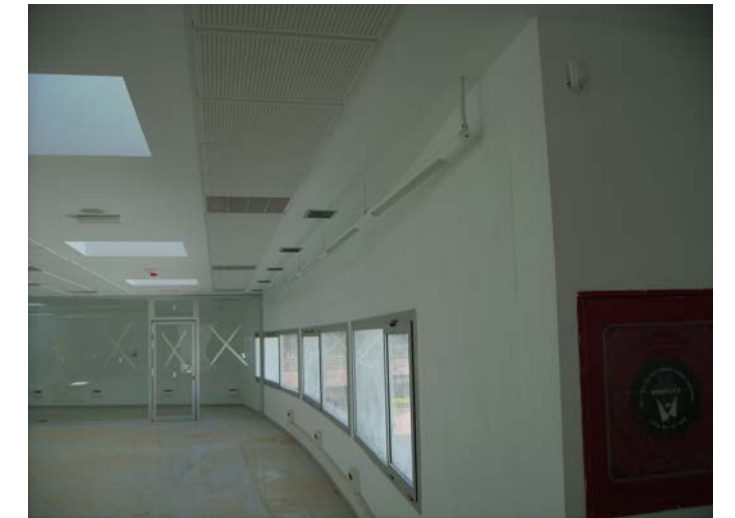
Col·locació definitiva del llum lineal sobre els llocs de lectura de la façana Nord de l'ala Sud.
