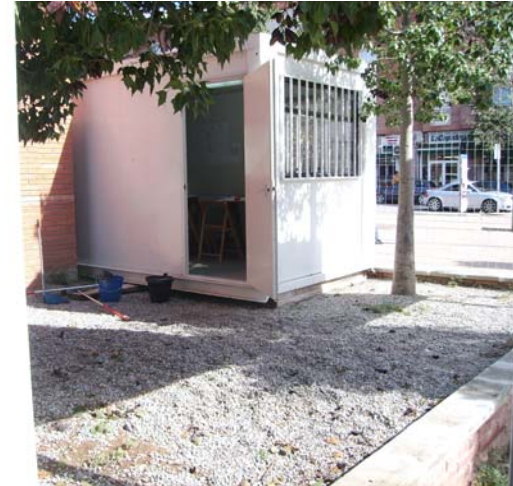
Implantació: El mòdul d'oficina d'obra.
