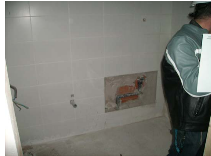
Interior del lavabo que s'ha de modificar per a fer-lo accessible per a minusvàlids. (soterrani)
