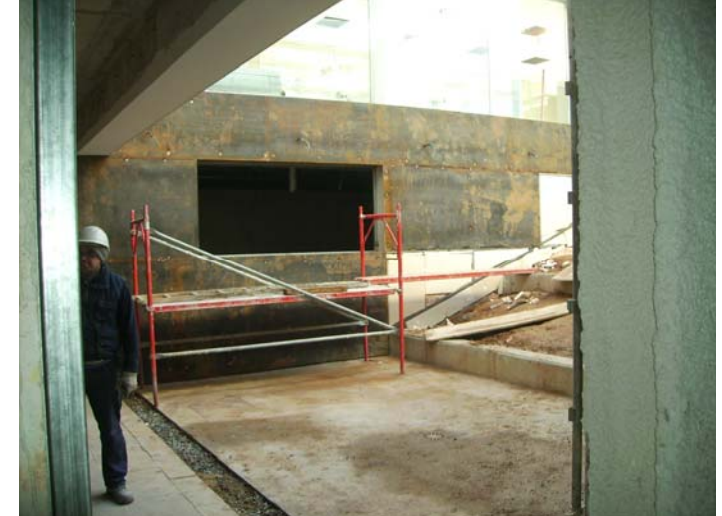
Planxa Cortén, col·locada al soterrani. (façana Nord de l'ala Sud).
