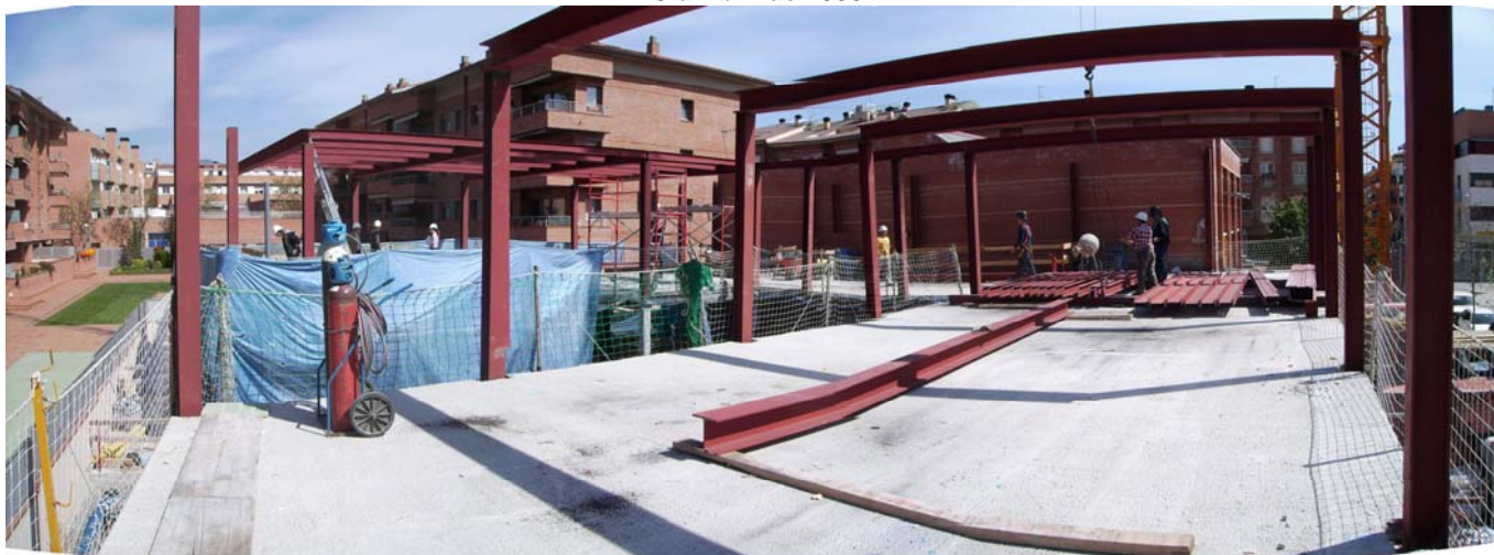
Inici de la col·locació de la estructura metàl·lica de la coberta.
