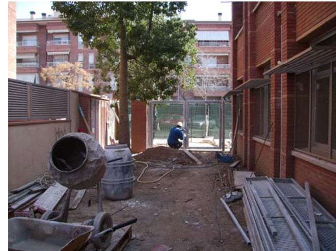
Muntatge de la porta al carrer des del jardí Nord.
