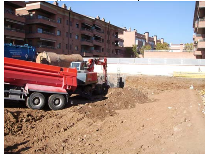
Inici de les excavacions per a arribar al nivell del soterrani.
