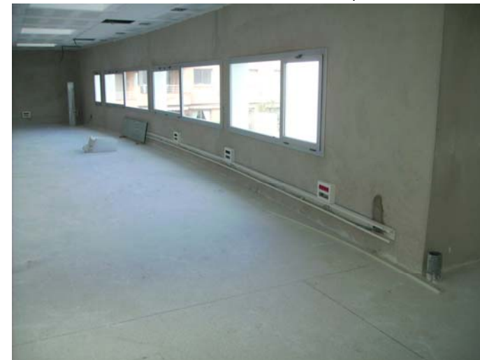
Instal·lació elèctrica i de telecomunicacions per a servir a la taula llarga de la façana Nord de l'ala Sud.
