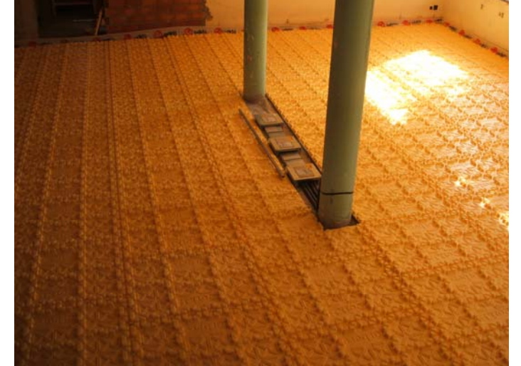
Terra radiant a planta baixa de la biblioteca antiga, i reserva per a sortides d'instal·lacions.
