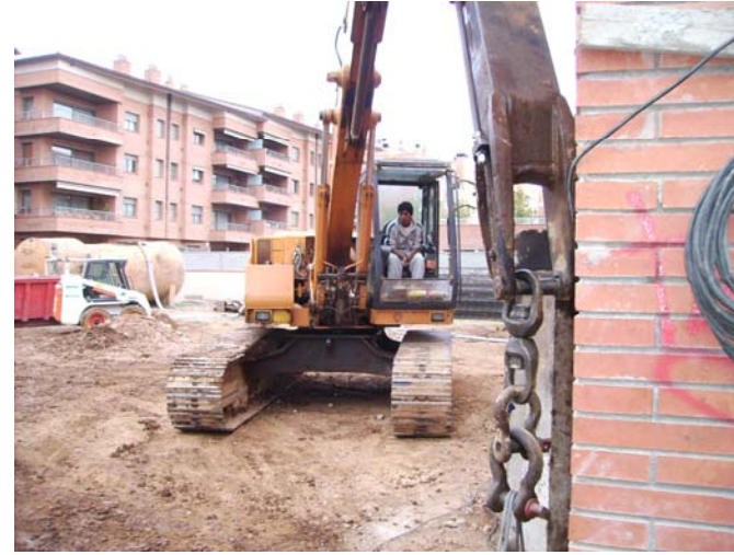
Excavació amb llots tixotròpics. Al fons, dipòsit d'aigua.
