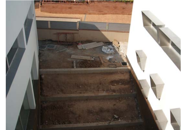
Pati interior. Situació de les arquetes de sanejament.
