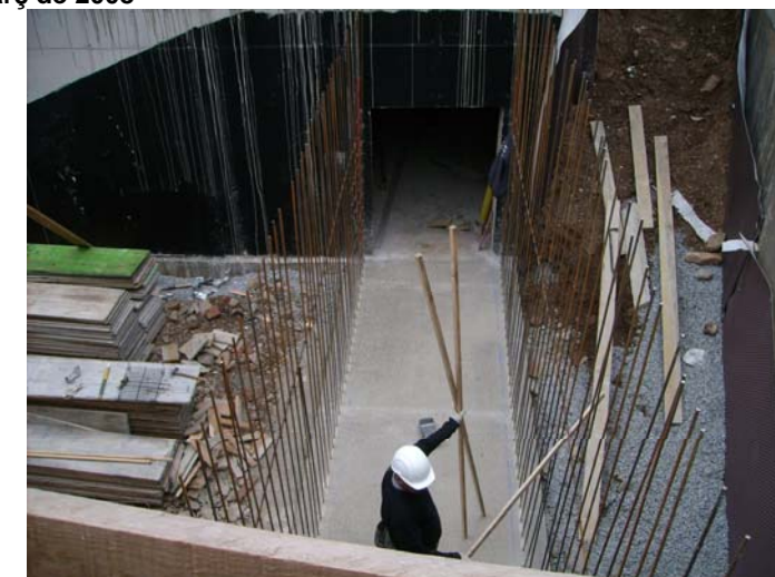
Col·locant l'armat dels murs del nou passadís entre ales.
