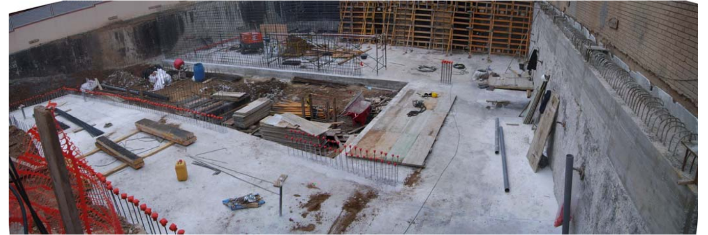
Visió general de l'estat de l'obra. Llosa de fonament, i inici del mur de contenció.
