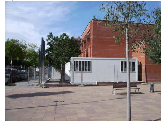
Implantació: El mòdul d'oficina d'obra.
