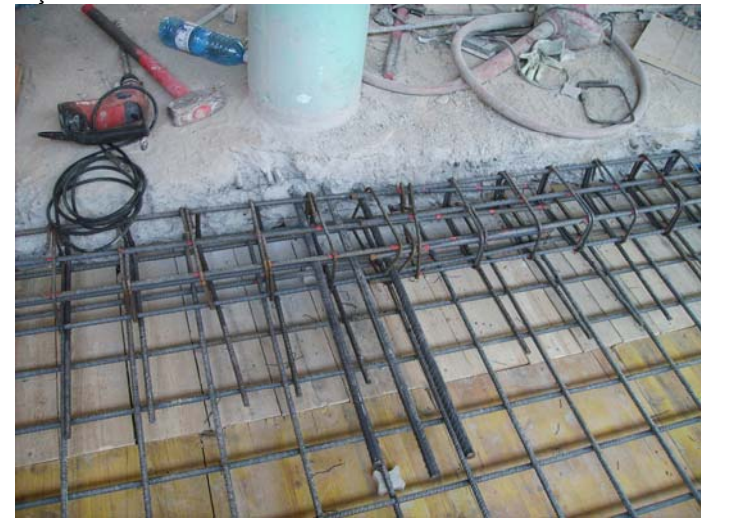
Tres rodons de connexió entre la nova llosa i l'antic forjat a l'altura dels pilars.
