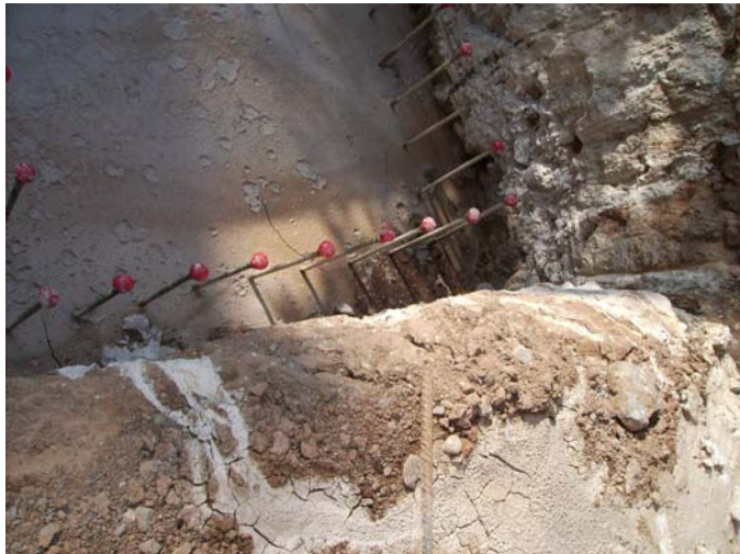
Formigonat de la base del dau de formigó de la grua.
