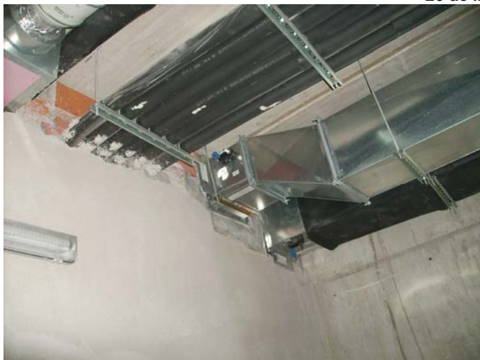
Pas d'instal·lacions des del recinte del climatitzador de l'ala Sud, cap a la sala d'electricitat.
