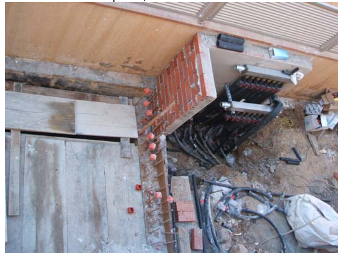
Inicis de la construcció del nou armari per als col·lectors geotèrmics.
