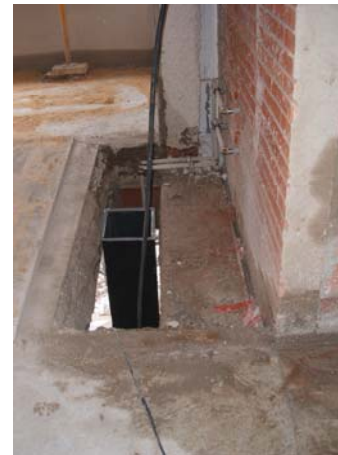
Pas dels tubs d'aire condicionat per la cambra del primer pis (cantó Nord)
