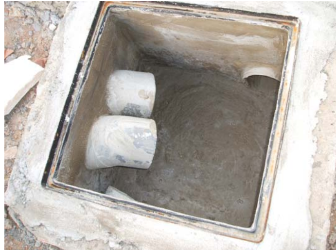
Arqueta de pluvials al tester de l'ala Sud. (tubs des del soterrani)
