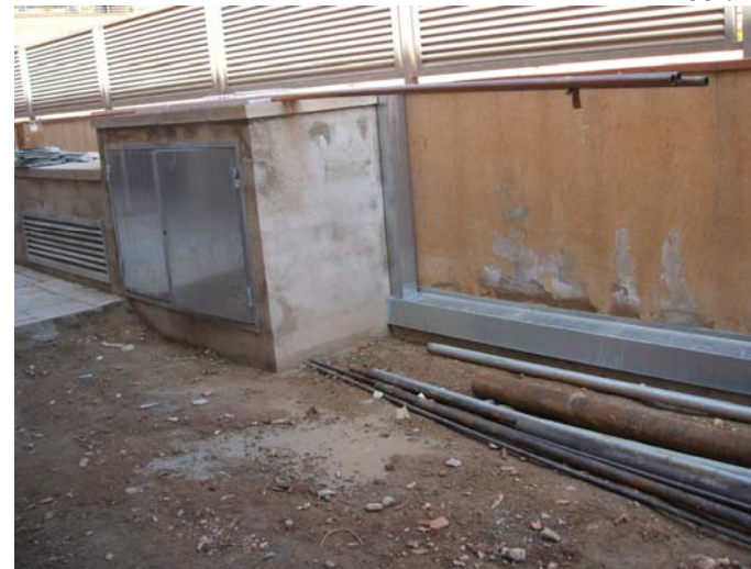
Remat de coronació de planxa galvanitzada del mur veí. A la vegada, protegeix el tub del gas.
