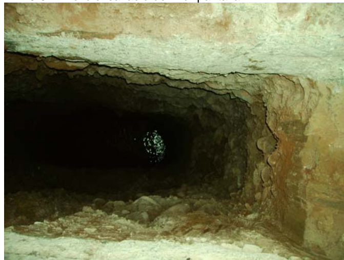
22-10-07: Es troba aigua. Es para la excavació. I es torna a omplir de terra. S'ha d'excavar amb un altre mètode.
