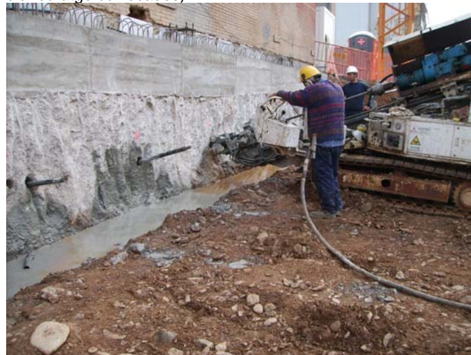
Perforació dels ancoratges del mur pantalla.
