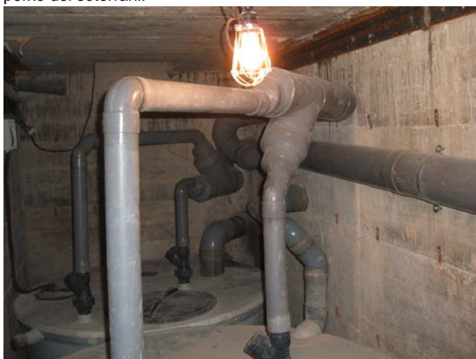
El segon dipòsit (de pluvials) i en tercer, al fons, de fecals.
