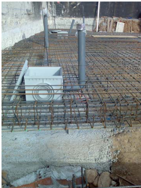
Armat de la llosa de l'ala Nord. Trobada amb el mur del garatge veí. (1)
