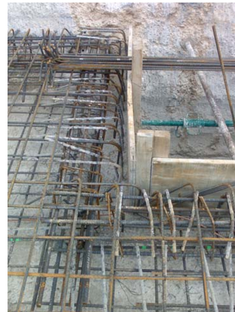
Trobada de la llosa amb els murs del pou de l'ascensor.
