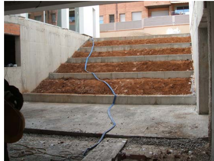
Estat del pati central, enllestit.
