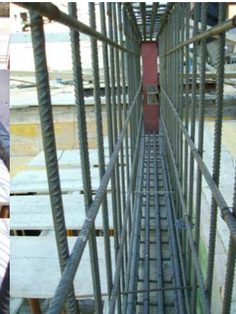
Interior de la jàssera. Armadures principals.
