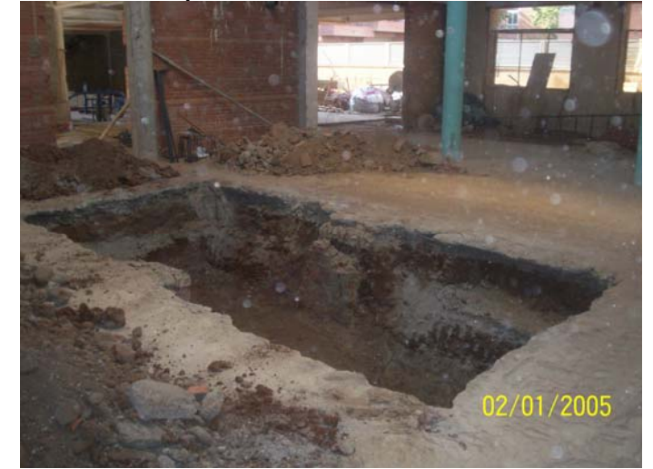
Excavació feta fins a la profunditat del pou de l'ascensor.
