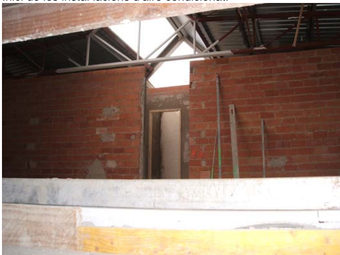
Tancaments interiors dels lavabos del primer pis a la biblioteca antiga.
