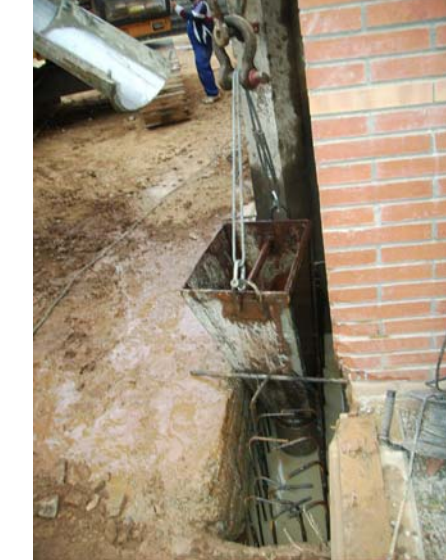
Embut de formigonat.
