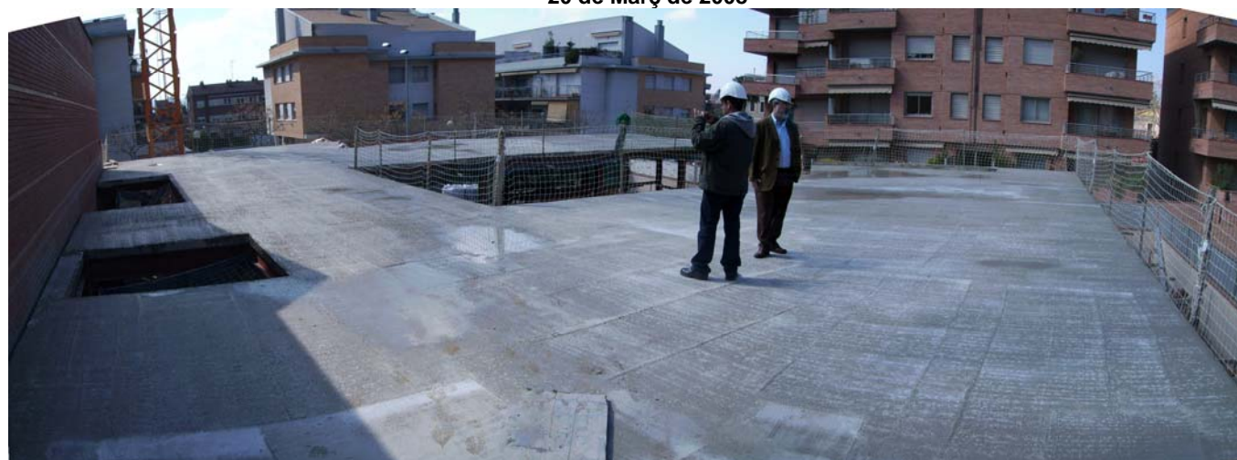
Forjat col·laborant del primer pis, formigonat.
