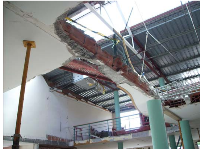
Enderrocant el forjat central del primer pis de l'antiga biblioteca.
