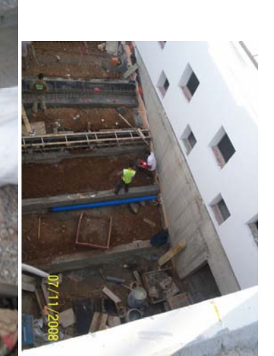
Construcció dels murets de contenció del pati central.
