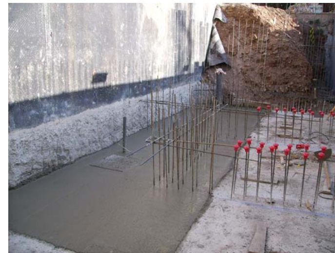
Repicat de fonament, recalçat del mur veí, i formigonat de llosa a la zona del generador. Arqueta, i connexió de bunera i per a connexió del drenatge veí.
