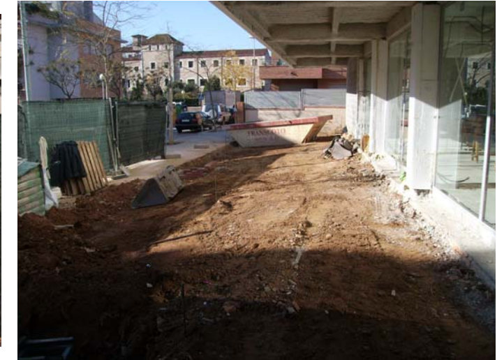
Configuració dels pendents per a fer la solera del nou paviment de la entrada. Els rodons, marquen la diagonal que forma una aresta.
