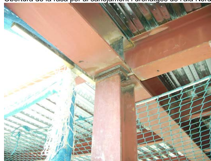
Col·locació de les platines de reforç (continuació d'ales de pilars)
