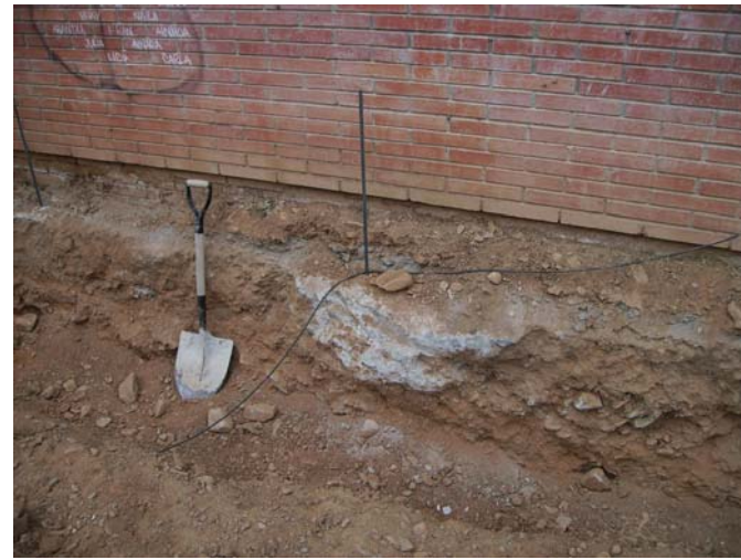
Inici del repicat del fonament de la biblioteca antiga. S'ha de fer el repicat per a poder excavar el mur pantalla.
