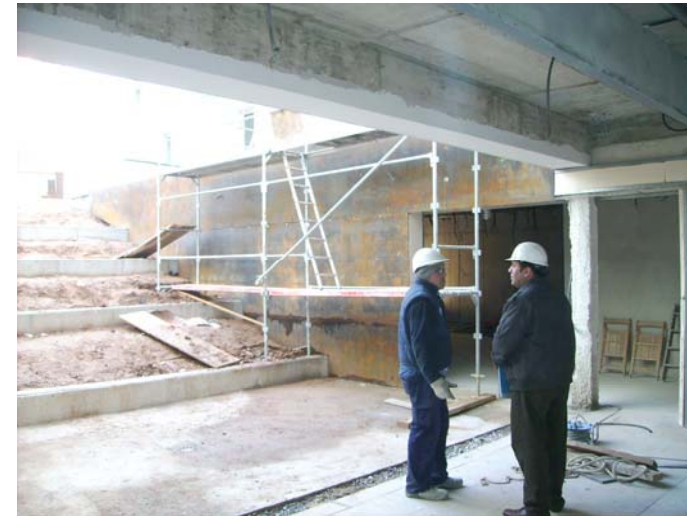
Planxa Cortén, col·locada al soterrani. (façana Sud de l'ala Nord).
