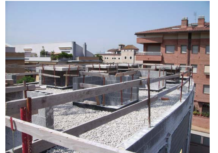
Coberta aïllada i impermeabilitzada, i amb capa de protecció de palet de riera.
