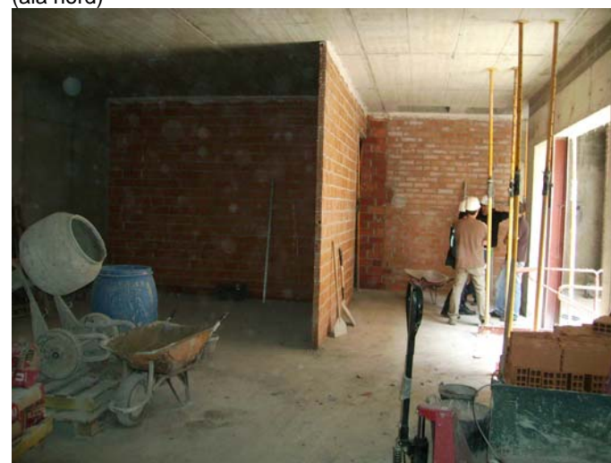
Mur de divisió interior del magatzem de la sala polivalent.
