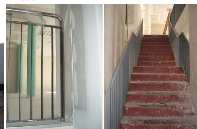
Barana de la gran obertura del primer pis a l'escala principal.
