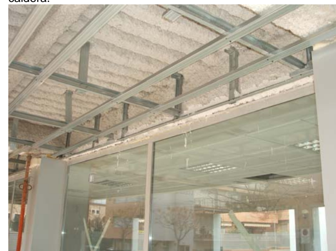
Treballs de col·locació de rastrells per a suportar el fals sostre de planxes de fusta.
