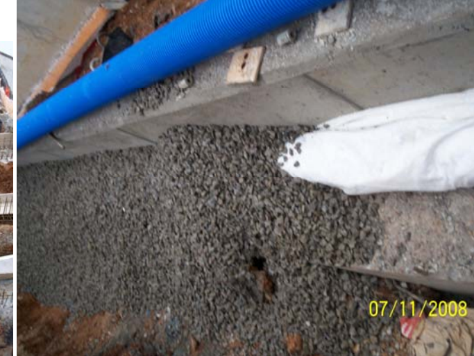
Graves i tubs de drenatge als murets de formigó del pati central. Tub drenant embolicat amb geotextil.
