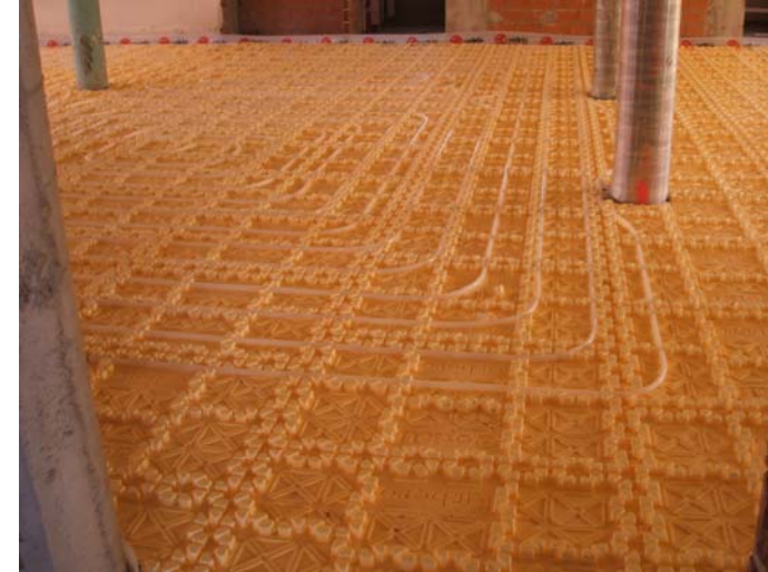
Estesa del terra radiant a Planta Baixa de la Biblioteca antiga.
