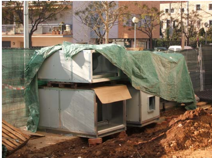
Abassegament de maquinària per a l'aire condicionat.
