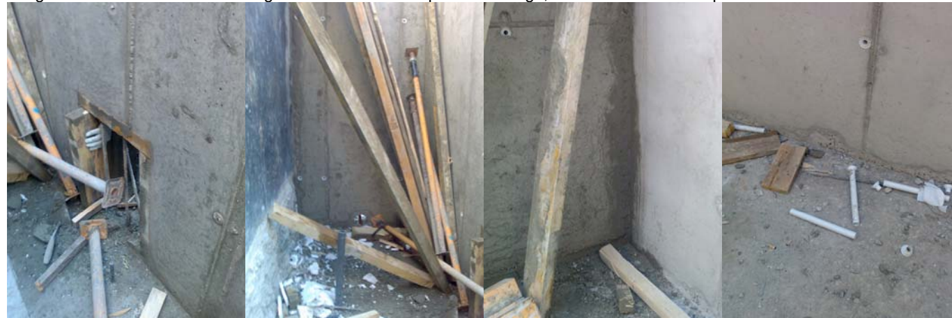
Futur dipòsit d'aigua. Es deixa una zona sense formigonar per a resoldre després les connexions de les bombes.
