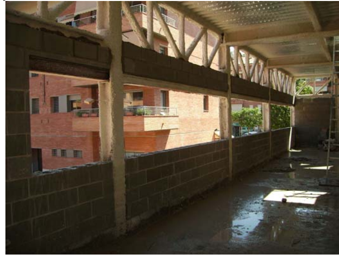
Tancaments exteriors primer pis, ala Nord, façana Nord.
