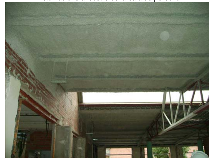
Vist el sistema d'aïllament de la coberta existent, s'ha decidit millorar-la amb un projectat aïllant.
