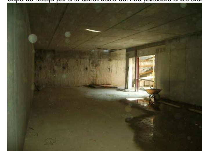
Tota la planta soterrani desapuntalada.
