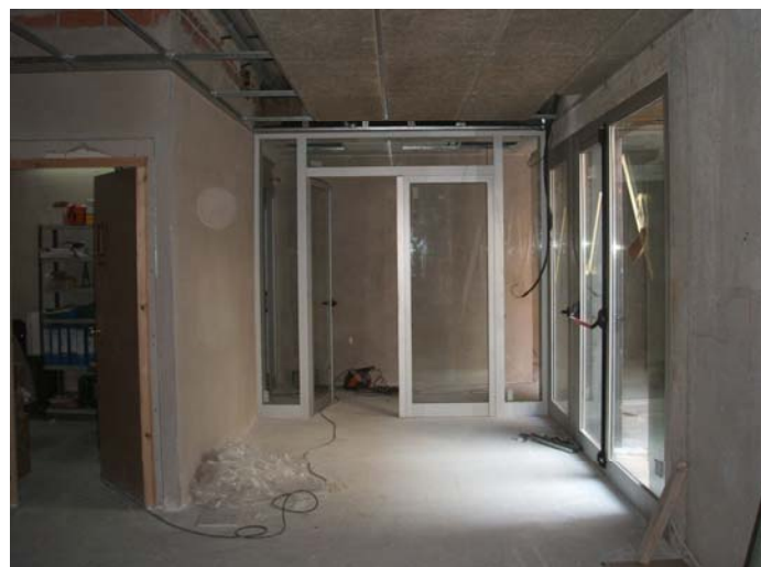
Col·locació de la porta d'emergència, de sortida al pati i d'entrada a la Sala Polivalent.
