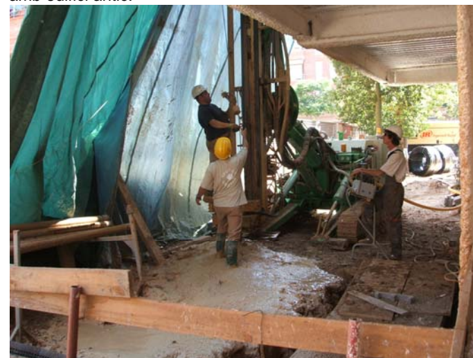
Inici dels treballs de perforació dels pous geotèrmics.
