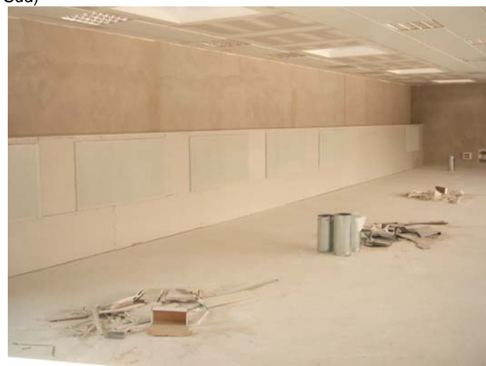
Instal·lació de difusors
