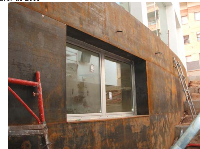
Finestra de la sala de personal de la biblioteca, amb remats de llinda, brancal i ampit.
