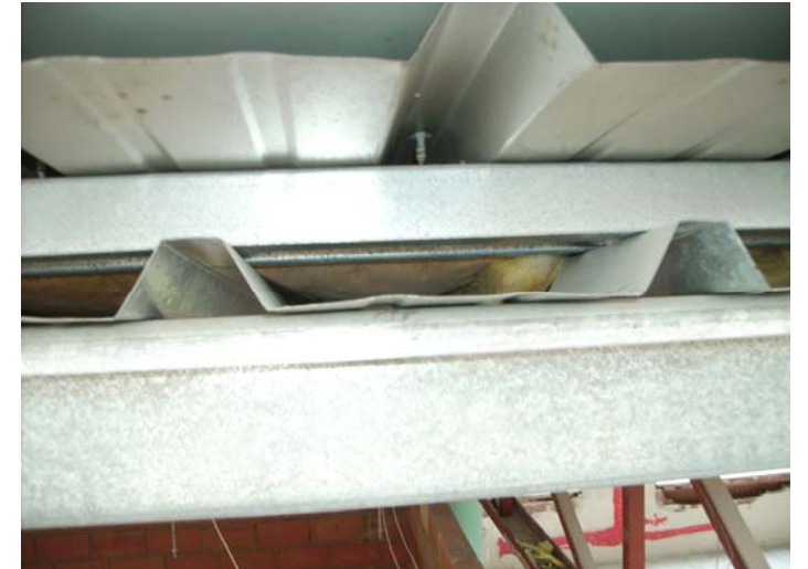
Composició de la coberta. Aïllament amb llana de vidre, separació i suport.
