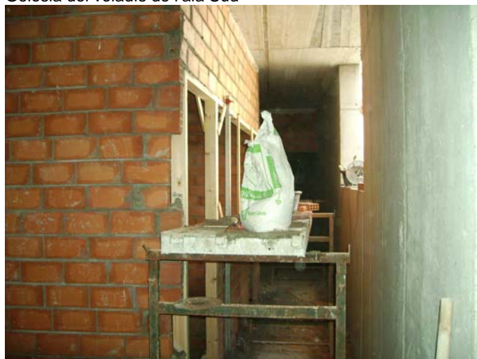
Inici de les divisòries interiors (despatxos a planta soterrani)
