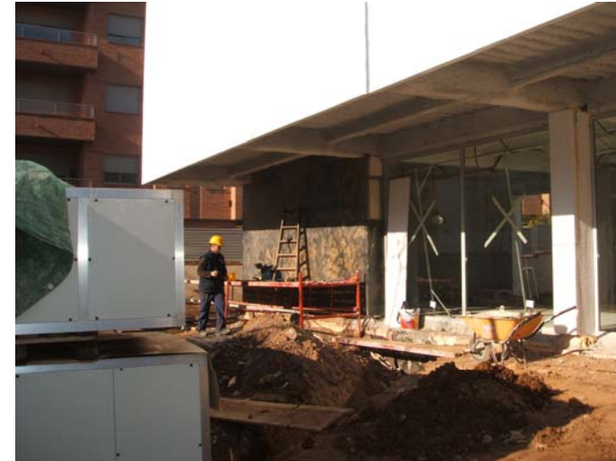
(foto del 18 de Desembre) Col·locació del Cortén en façana, sobre rastrells, i aïllament.
