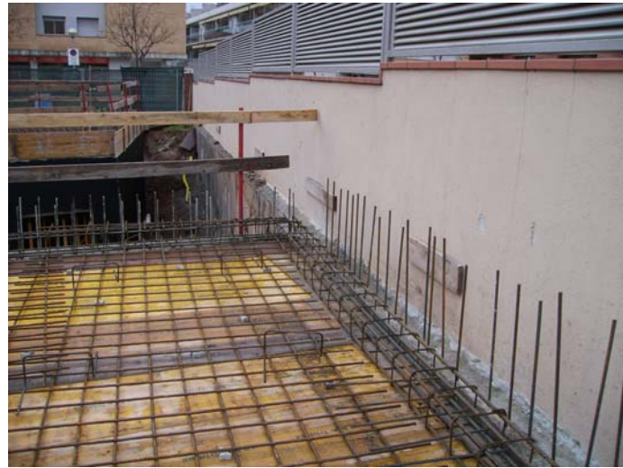
Ancoratges al mur de contenció.
