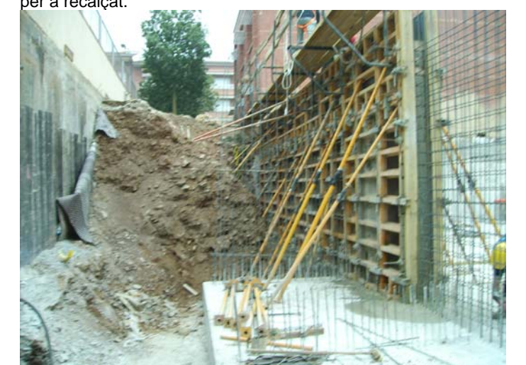
Visió de l'encofrat de l'extradós del mur de contenció de terres del jardí Nord. A l'esquerra es veu el tub de drenatge del veí. (de color groc)
