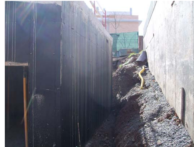
Tester de l'ala Sud. Amb pintura asfàltica. Es veu el drenatge del veí.
