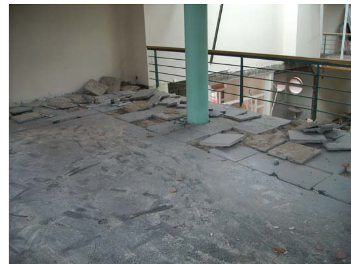
Arrencada de paviments a la biblioteca antiga.
