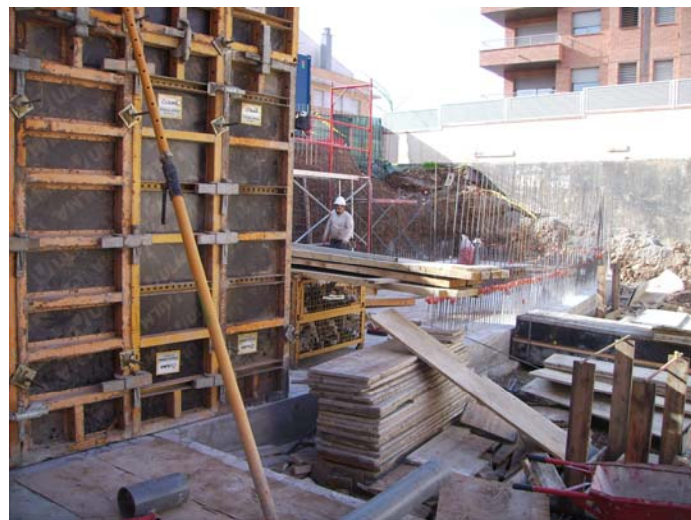
Encofrat i esperes de l'ala sud, des del pati central
