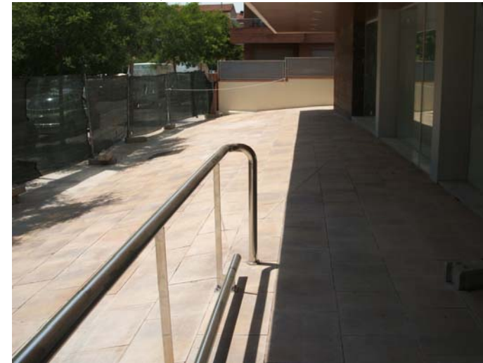
Final de la barana, i del seu sòcol.
