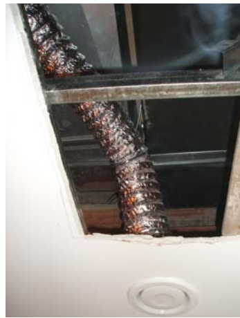
Connexió de la ventilació al lavabo d'homes del soterrani.
