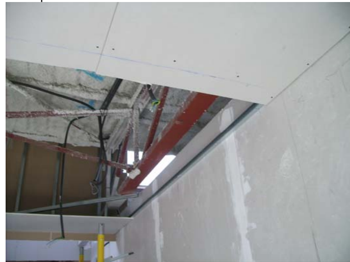
Planta pis. Edifici antic. Construcció del fals sostre dels lavabos
