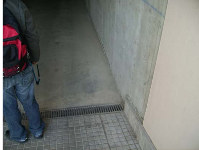
Entrada des de la rampa del Carrer Klein. (el mur de formigó de la dreta és el que limita amb el solar de la Biblioteca.
