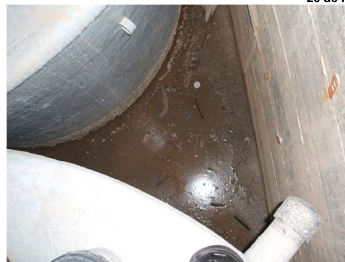
Fons del recinte de sanejament. Encara s'ha de reomplir de sorra, per a recolzar els dipòsits quan estiguin plens.
