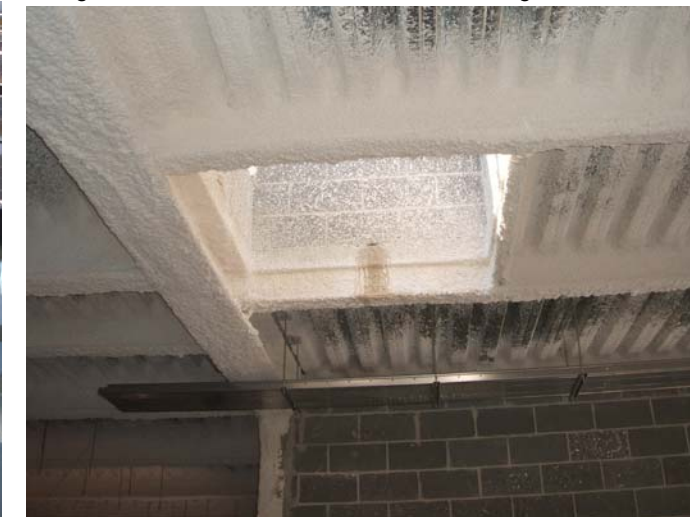
La prova d'estanquitat descobreix petits problemes, que s'esmenen.
