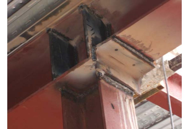
Platines de reforç per a la continuïtat de les ales dels pilars
