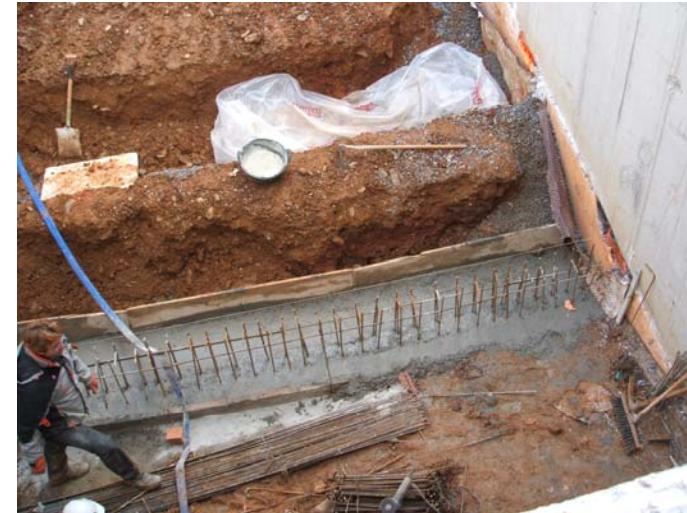
Inici de les rases murets de contenció del pati central.
