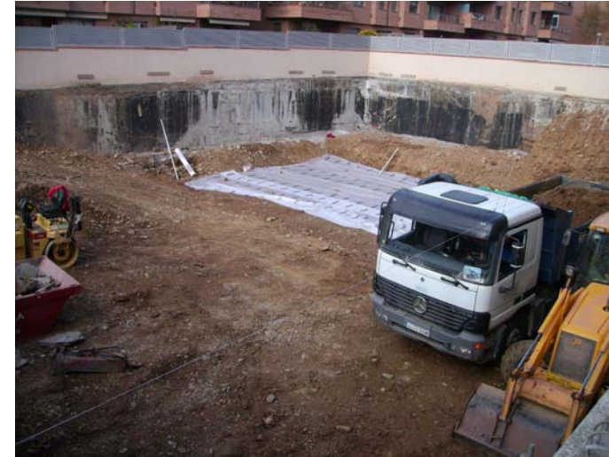
Visió general de la excavació. Prop del mur, no s'excava fins al fons perquè els fonaments del veí interfereixen.
