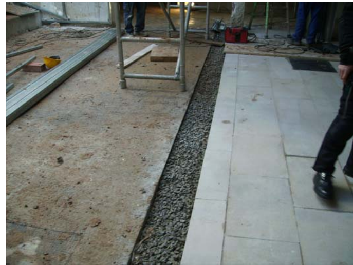
Soterrani: Solera de formigó, canal de drenatge dels regalims de façana i paviment del porxo del soterrani amb llosa Vulcano.
