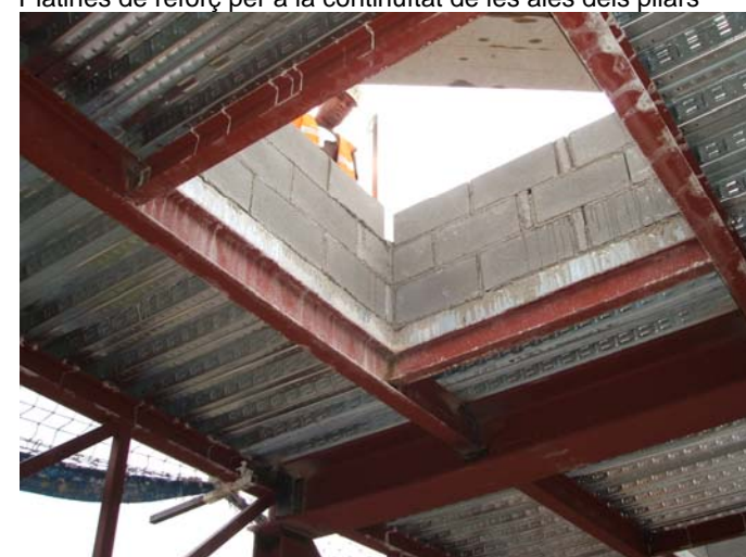
Inici de la construcció de les claraboies.
