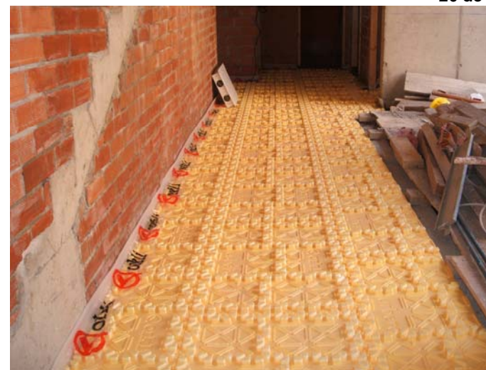
Inici de l'estesa de la planxa aïllant per a la col·locació dels tubs del sòl radiant.
