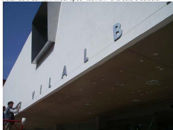
Col·locació de les lletres a la façana Sud.
