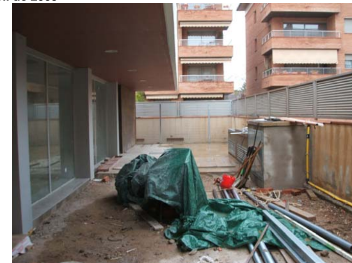
Vista general del pati Nord. Badalots d'instal·lacions fets, amb reixes i portes, i coberts amb Ilosa Vulcano.
