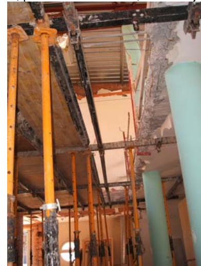
Encofrat de la nova llosa. Forjat retallat fins als pilars.
