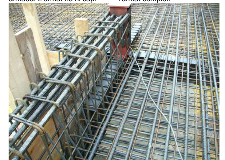
Jàssera amb l'armat complet, i unió de l'armat amb el pilar metàl·lic.
