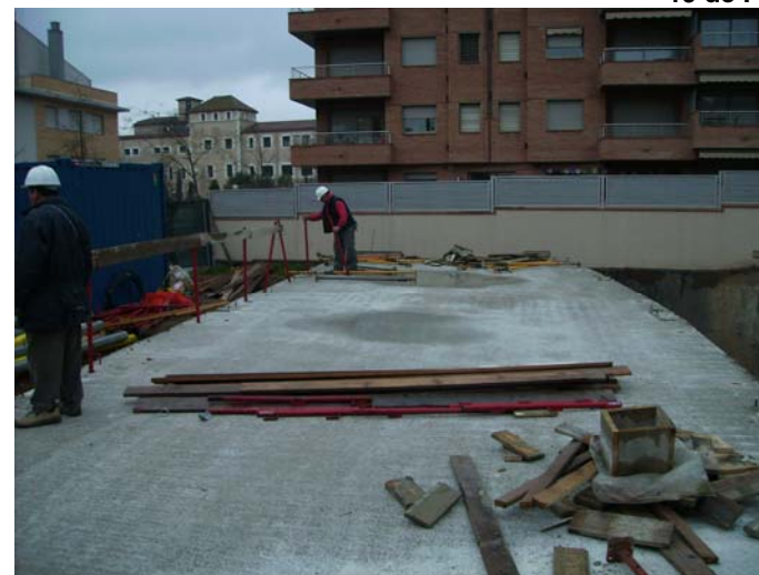
Llosa de sostre del soterrani, formigonada. Col·locant baranes
