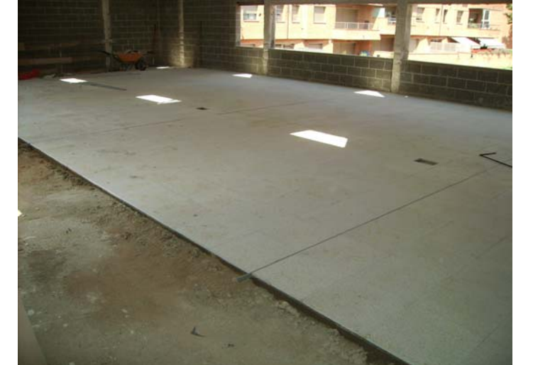
Col·locació de rajoles a l'ala Nord de la planta pis. Col·locació de la junta de dilatació del paviment.
