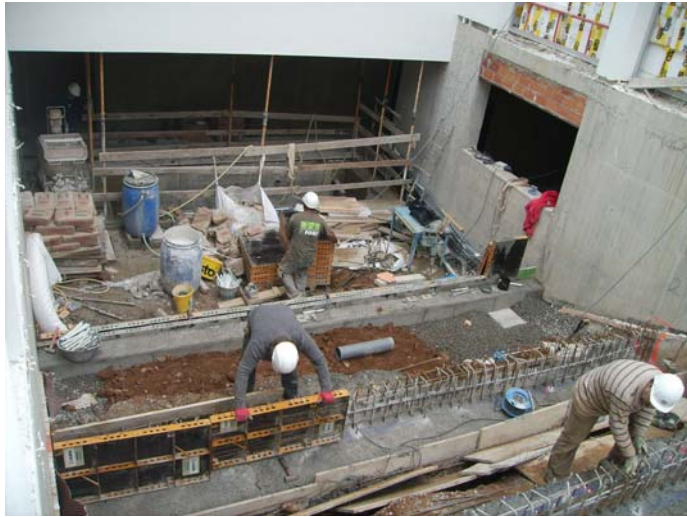
Construcció dels murs de contenció dels graons del pati.
