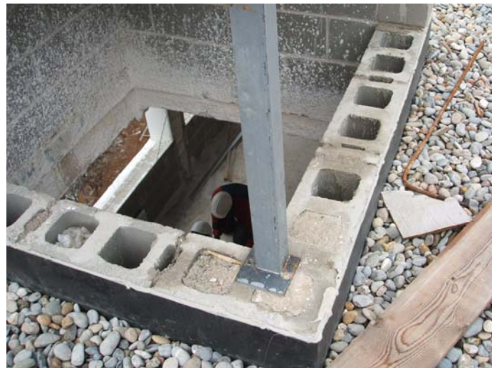
Base del pilaret de la claraboia.
