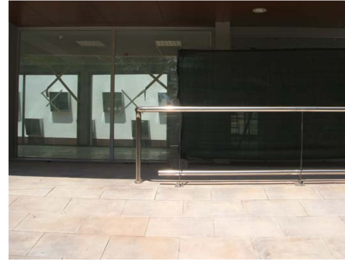
Barana de l'entrada, col·locada.
