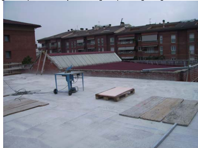
Al fons, la coberta de la biblioteca antiga. Aquesta cara de la claraboia s'ha de tapar per a impedir el pas del sol directe.
