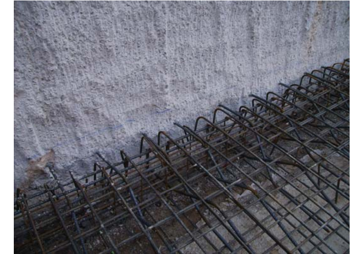
Ancoratge de l'armat de la llosa al mur pantalla
