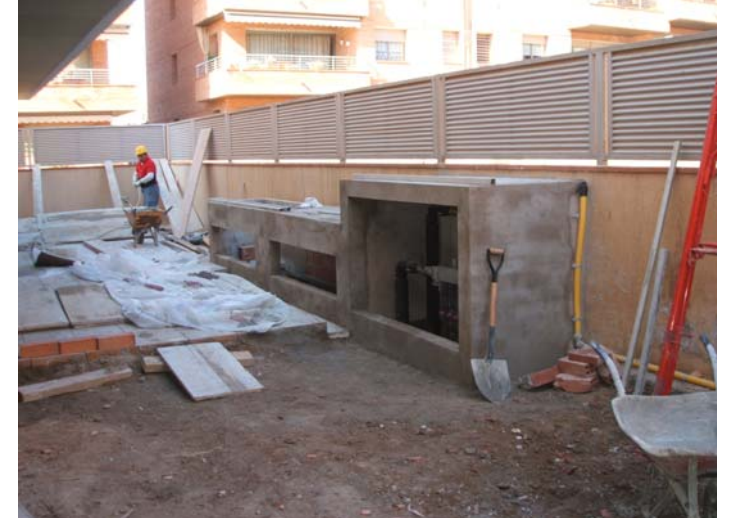
Construcció de l'armari de col·lectors geotèrmics, i del petit badalot d'entrada i ventilació del generador.
