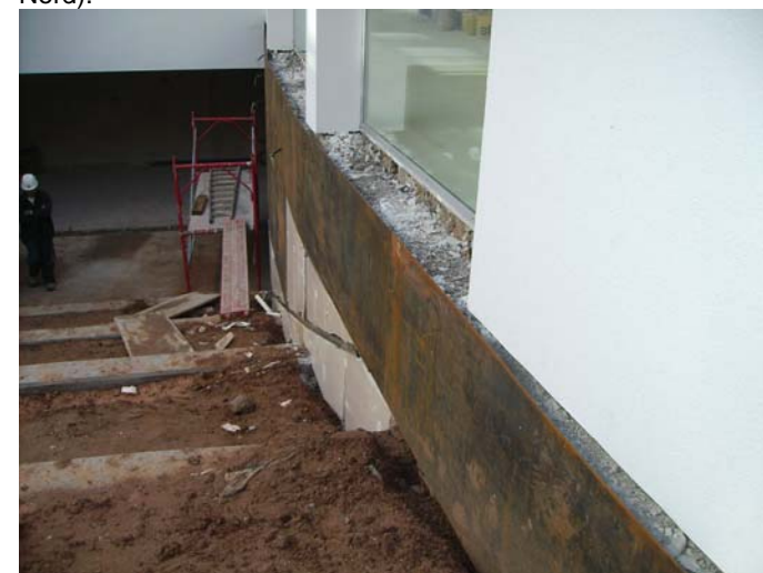
Planxa Cortén, col·locada al soterrani. (façana Nord de l'ala Sud). S'ha de corregir la corba.
