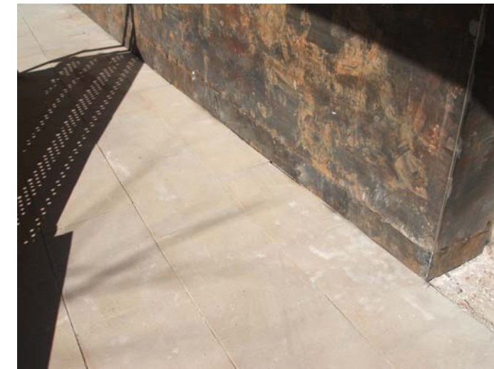
Acabat del sòcol del mur de façana revestit amb cortén
