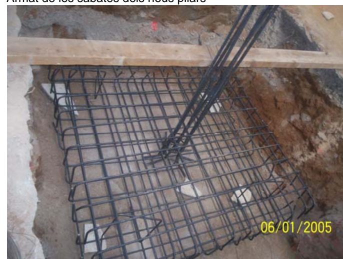
Armat de les sabates dels nous pilars
