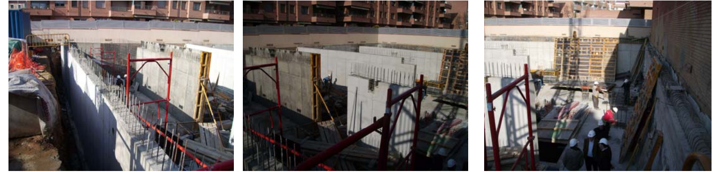
Visió general de la construcció dels murs de contenció del soterrani.
