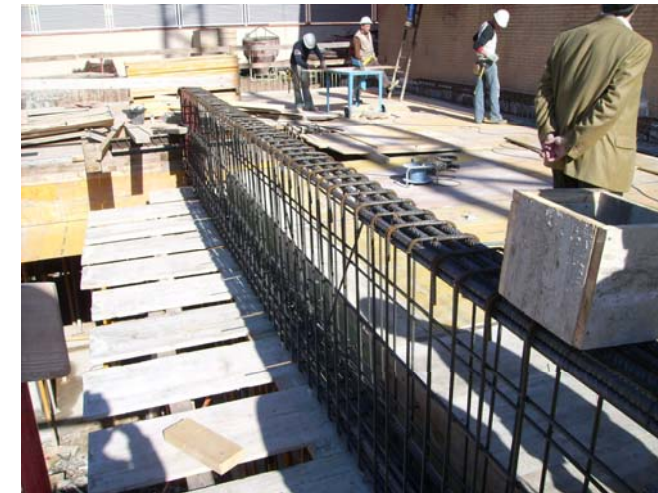
Inici de l'armat de la jàssera que uneix les dues ales.
