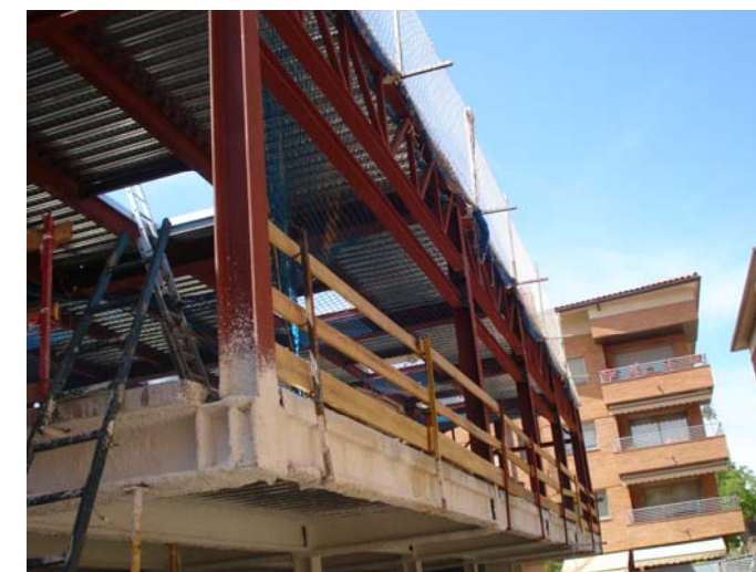
S'han fet totes les gelosies dels voladissos, i les llindes per a les finestres corregudes (façana Nord de l'ala nord)
