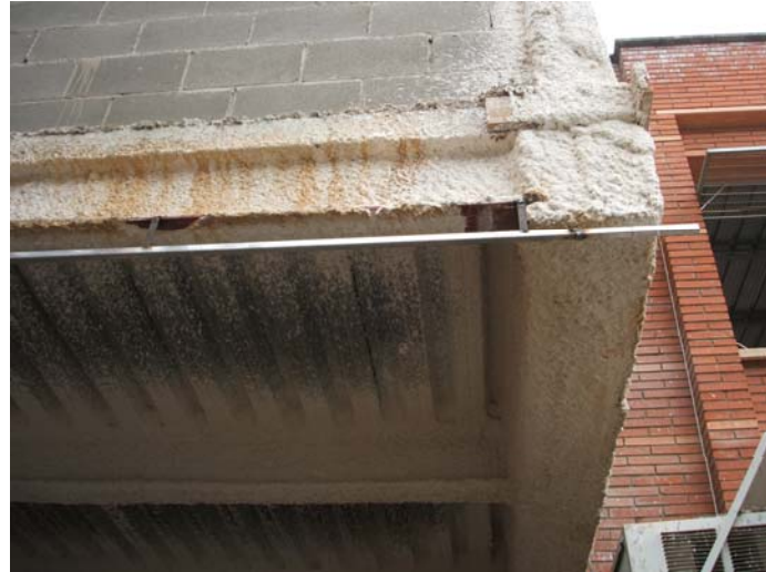
Petit perfil de límit de la façana. (Façana principal)
