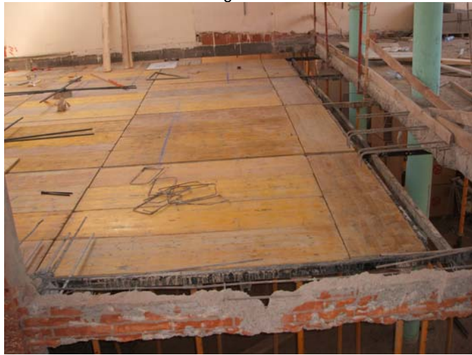
Encofrat de la nova llosa.
