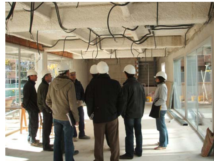
Les instal·lacions elèctriques passen amb dificultat per sota de les jàsseres de la Planta Baixa.
