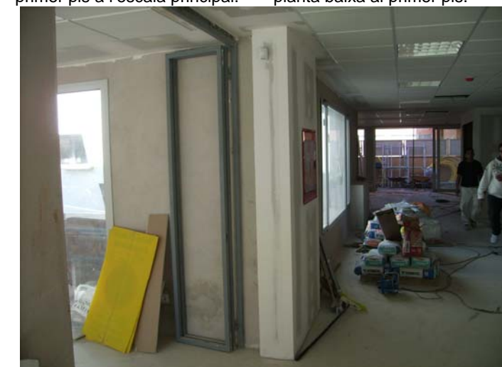
Visió del marc de les portes de religa per a permetre el funcionament de la sala polivalent, quan la biblioteca estigui tancada.
