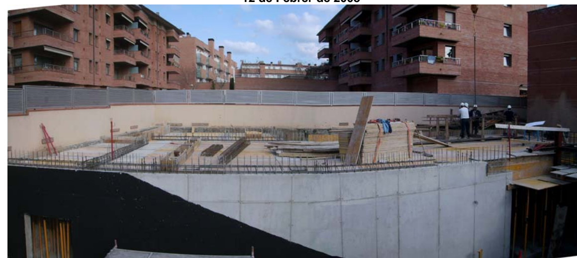
Inici de l'armat de la llosa del sostre del soterrani. Cèrcols
