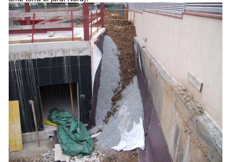
Aïllament i làmina drenant al tester de l'ala Sud.
