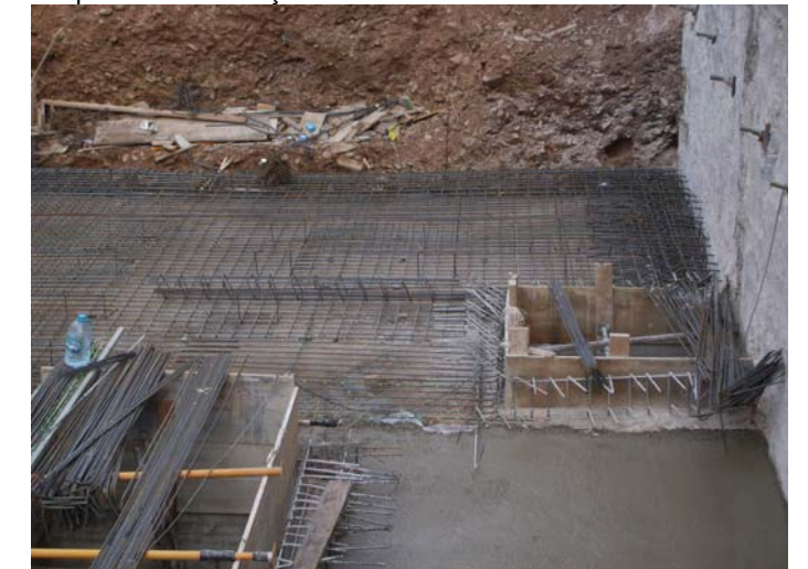
Inici de l'armat de la llosa de fonamentació de l'ala Nord.
