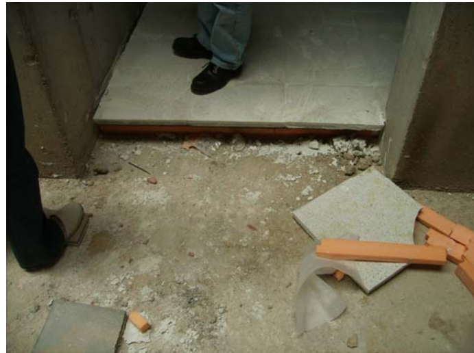
Trobada del paviment de la sala polivalent amb el pati. Es veu l'aïllament (sense terra radiant) i el morter.
