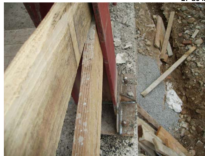
Col·locació de carteles a la base dels pilars
