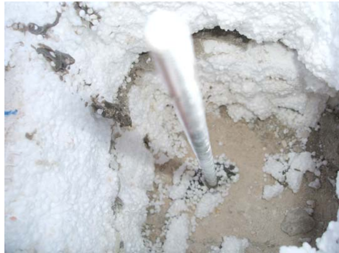
Ancoratge de suport dels perfils de suport de la coberta d'alumini de les claraboies. Ancorats a la llosa de formigó.
