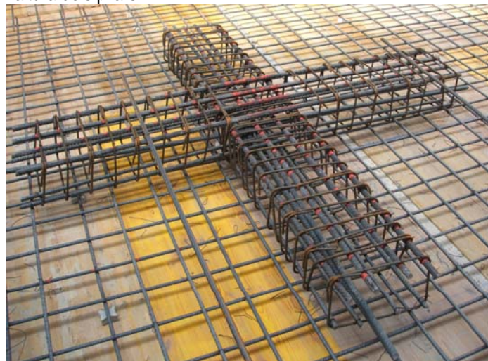
Creueta sobre un dels dos pilars. (el més llunyà a l'edifici nou)
