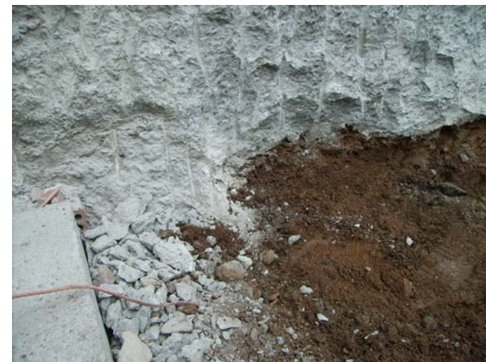
Repicat del fonament veí i excavació de la zona del generador per a recalçat.
