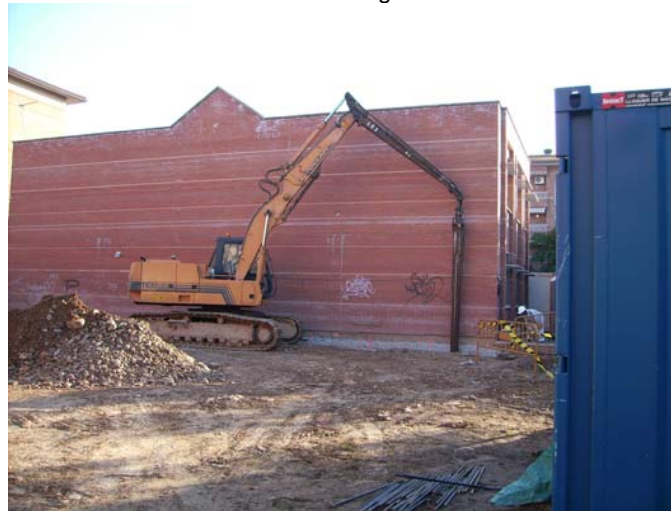
22-10-07: inici d'excavació del mur pantalla
