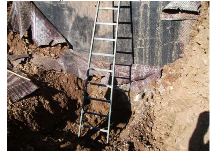
Excavació al límit amb el mur del garatge veí. Es veu l'antic tub de drenatge de color groc.
