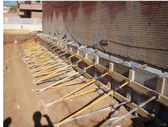
Encofrat de la biga de coronació del mur pantalla
