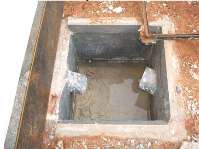
Arqueta de pluvials de l'ala Nord (al pati central)
