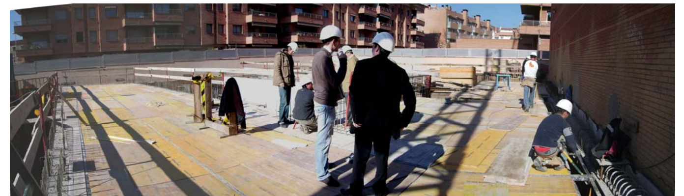
Visió general de tot l'encofrat per a la llosa de formigó del terra de la planta baixa. (composició de 3 fotos)
