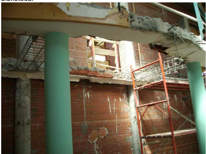
Conservació de l'armat de les jàsseres existents, per a poder integrar-les a la nova llosa.
