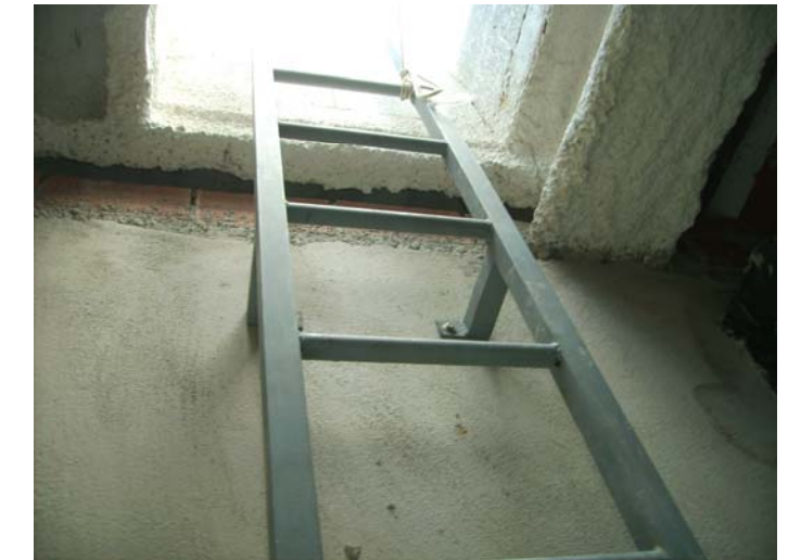
Escala de sortida a la coberta. Necessitarà alguns retocs. (els graons estan massa a prop de la paret).
