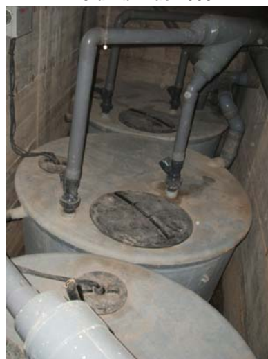
Vista dels dipòsits de sanejament. Tot connectat. Al fons es veu nova connexió provinent dels lavabos del soterrani.
