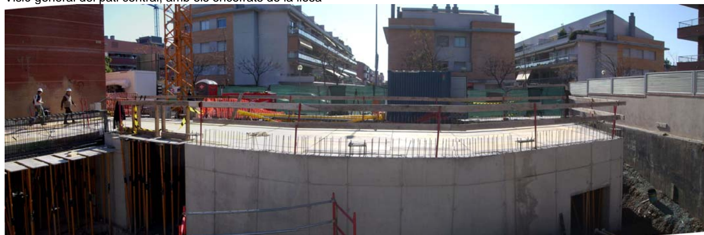
Vista general de l'ala sud. (composició de 3 fotos)
