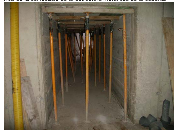
Apuntament de l'encofrat del passadís subterrani entre ales.
