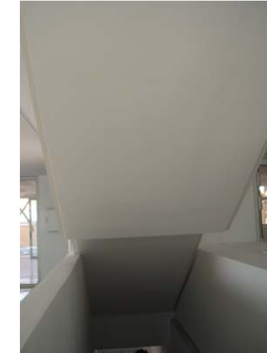
Visió de l'escala principal, amb el revestiment ignífug, i pintat.
