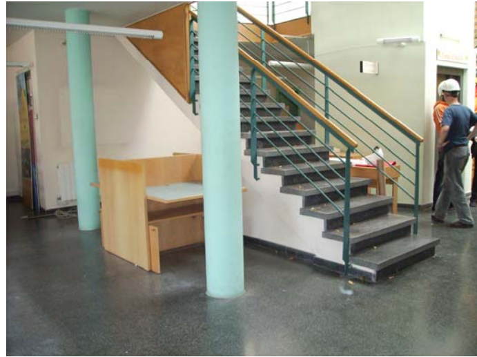
Fins aquest punt de l'obra no s'havia entrat encara a la Biblioteca original. Comencen els treballs per a la rehabilitació.
