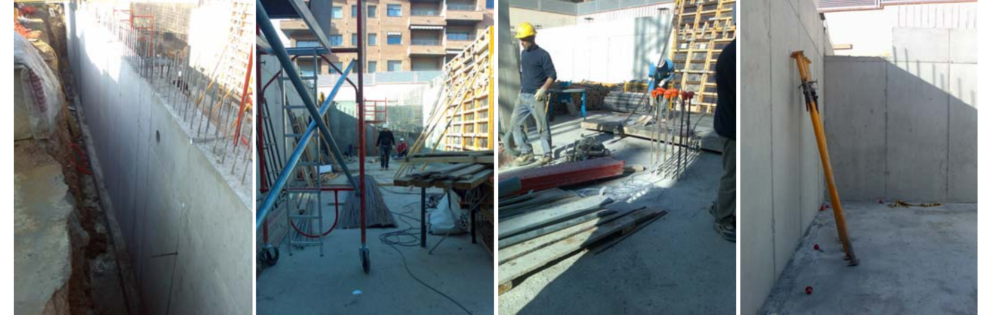
Extradós del mur sud, ala Sud
