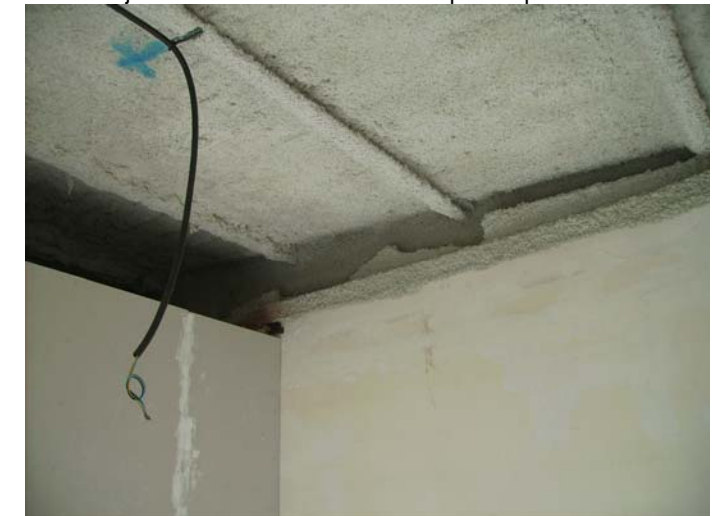
Recobriments amb projectat de llana mineral a la façana Est, Aïllant la zona a la que no arriba l'aïllament existent.
