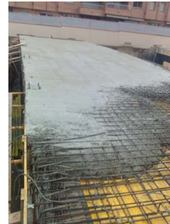
S'ha començat a formigonar per la part totalment armada.
