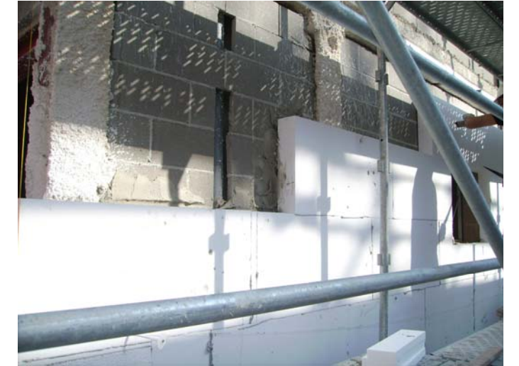
Estat del revestiment amb aïllant. Col·locació de planxes. (façana Sud de l'ala Nord) Es veu un dels tacs de fixació.
