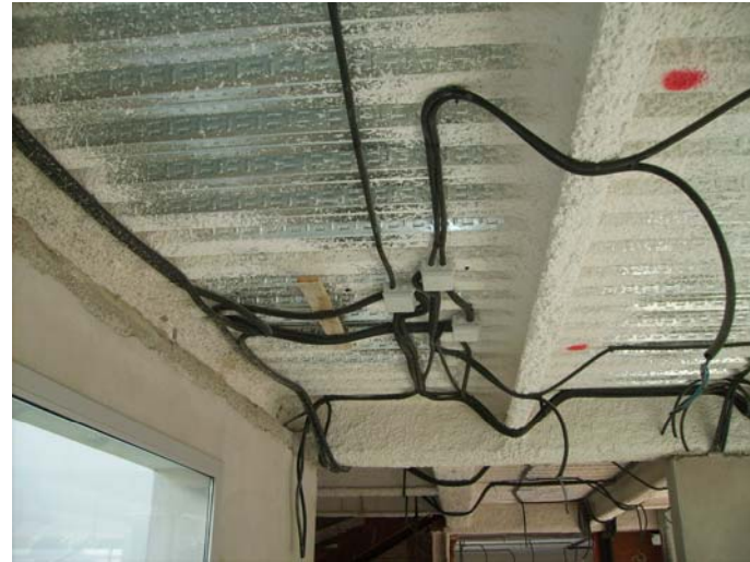
Sostre de la sala de revistes. Ala Sud, Planta baixa. Instal·lacions elèctriques.
