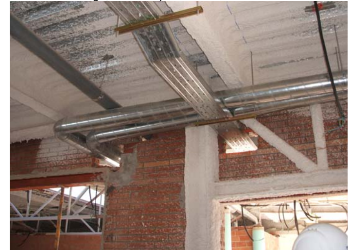
Planta pis, Connexió de la ventilació dels lavabos a la xemeneia general, sobre al entrada a la biblioteca.
