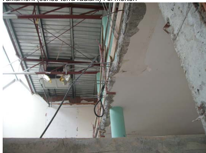
Finalment, a l'edifici antic, es retalla tot el vol, per a arribar a ancorar el nou forjat als nusos dels pilars. Això fa que la llosa central haurà de volar més.
