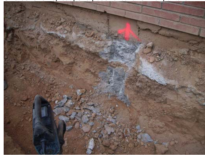
Inici del repicat. La marca assenjala la situació d'un pilar.
