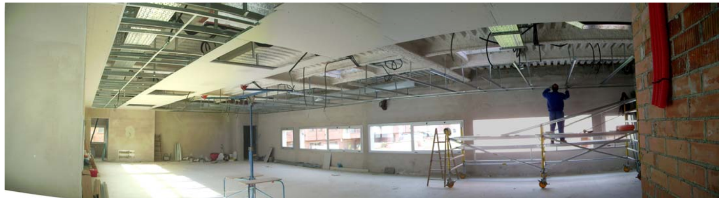
Estat del fals sostre al primer pis, ala Nord.
