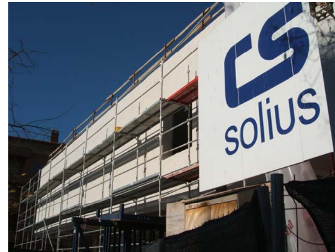
Façana Sud, aïllada i revestida amb STO Therm.
