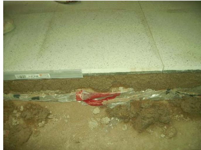
Final del paviment amb terra radiant a la sala de personal del soterrani. Mostra de la junta de dilatació proposada.
