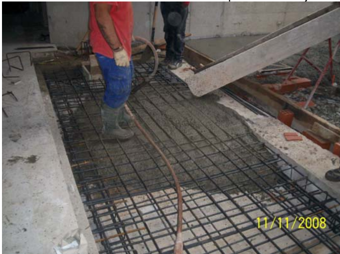
Formigonat de la llosa de sobre del recinte de dipòsits de sanejament.
