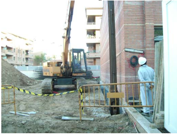
22-10-07: inici d'excavació del mur pantalla
