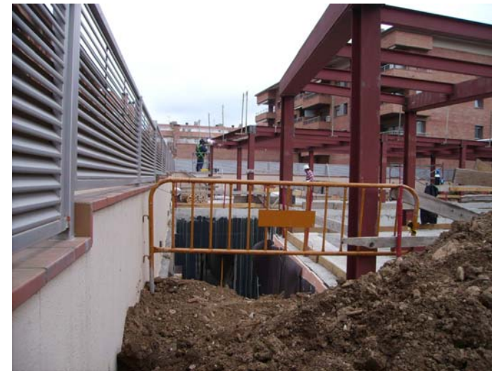
Testers de les ales. (Ala Sud i ala Nord) Al mur, es veu l'aïllament i la làmina drenant.
