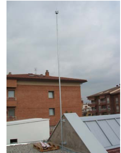
Parallamps col·locat. S'ha acabat el revestiment de la coronació de la junta entre edificis.
