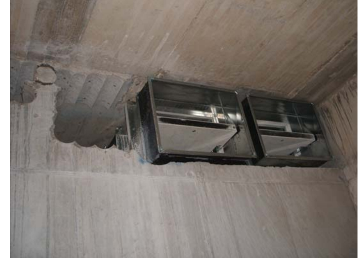
Correccions en el traçat de l'aire condicionat. Per a evitar encreuaments que haurien fet baixar el fals sostre de la sala polivalent.
