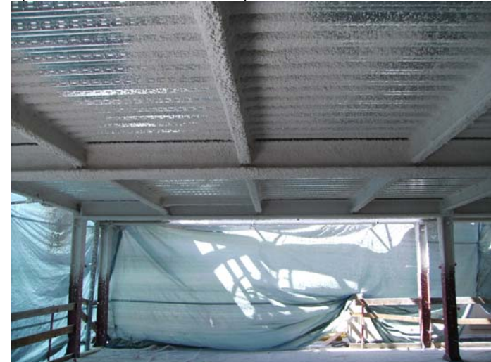
Inici dels treballs de ignifugat de l'estructura i el sostre de la Planta Baixa
