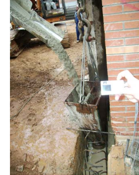
Embut de formigonat.
