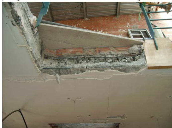
Estat del forjat, un cop enderrocada l'escala. Al fons, un forat de pas d'instal·lacions.
