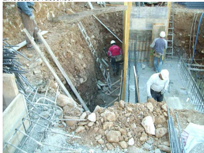
Llosa del fossat de sanejament vist des del Nord
