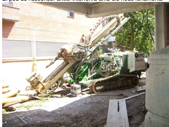
Arribada de la màquina per a perforar els pous geotèrmics.
