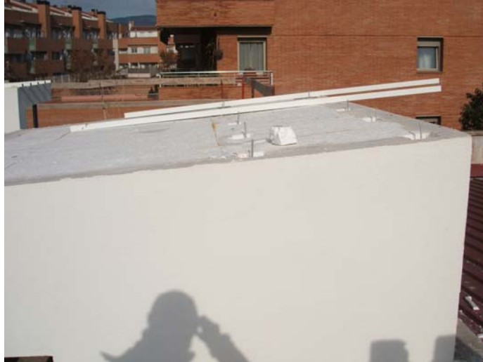
Ancoratges de suport dels perfils de suport de la coberta d'alumini de les claraboies.
