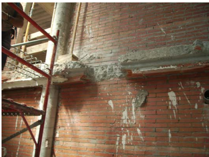
Estat de la riostra entre pilars.
