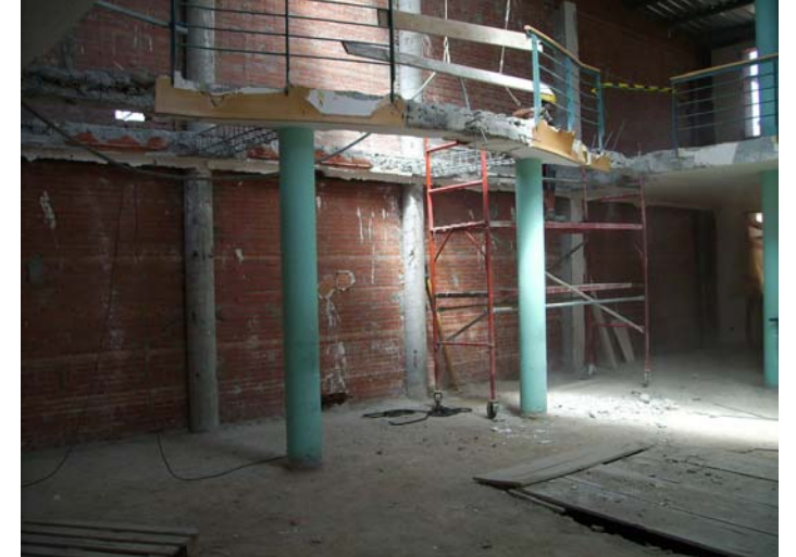
Enderroc de forjat a la biblioteca antiga.
