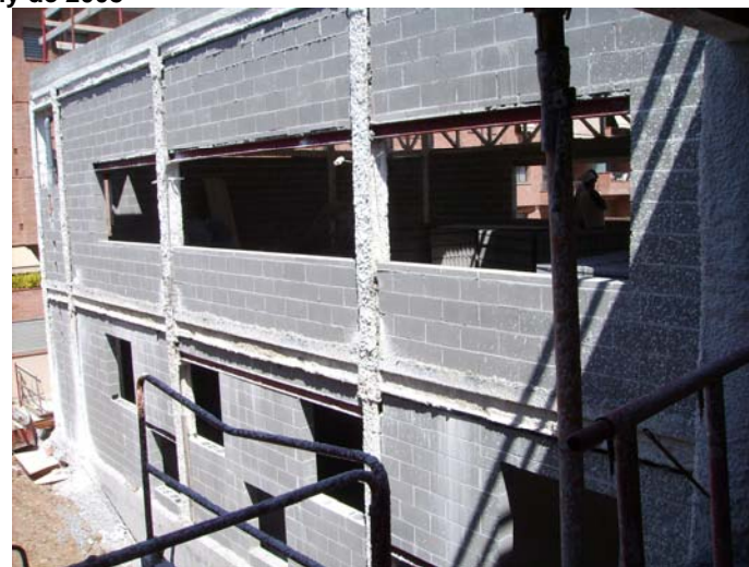
Tancaments exteriors. Ala Nord, façana Sud.
