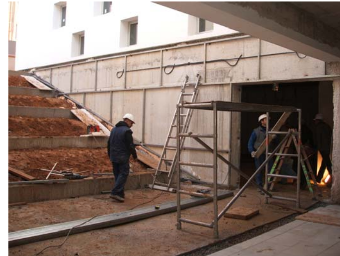
Col·locació de rastrells per a la façana de corten al soterrani.
