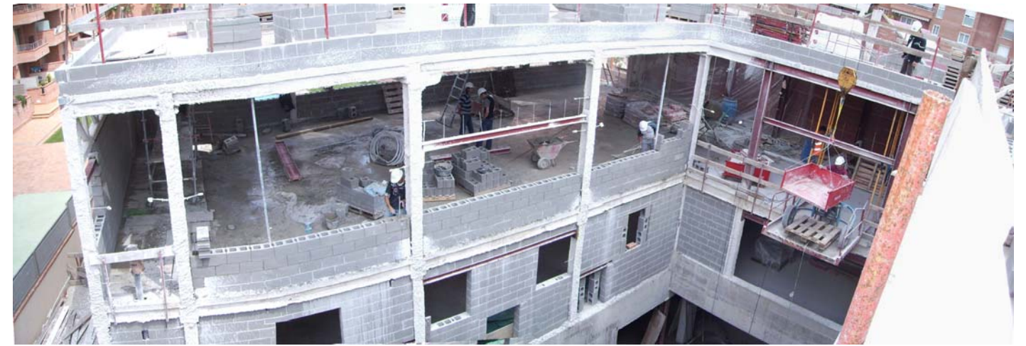
Estat general de les obres
