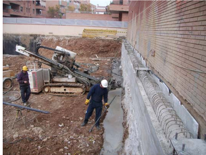
Perforació dels ancoratges del mur pantalla. (plaques d'ancoratge col·locades)
