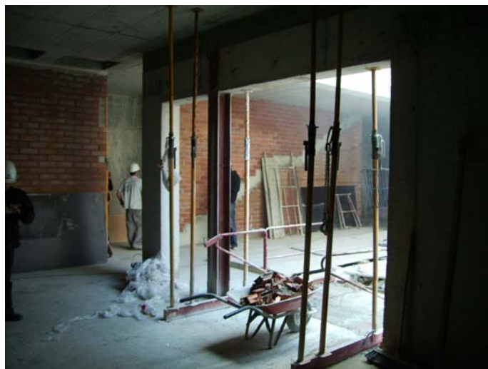
Tancaments interiors al soterrani (Tancament de l'escala)
