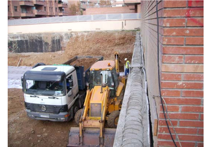
S'ha excavat fins al mur. La part que resta per excavar, correspon a zones en el que el soterrani no arriba fins al mur veí.
