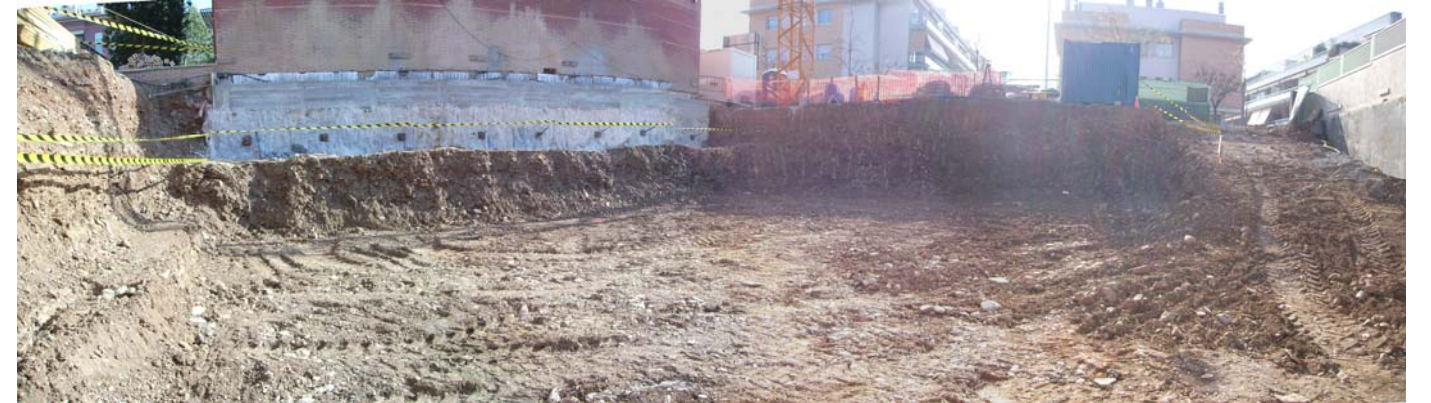
Visió general de la excavació.
