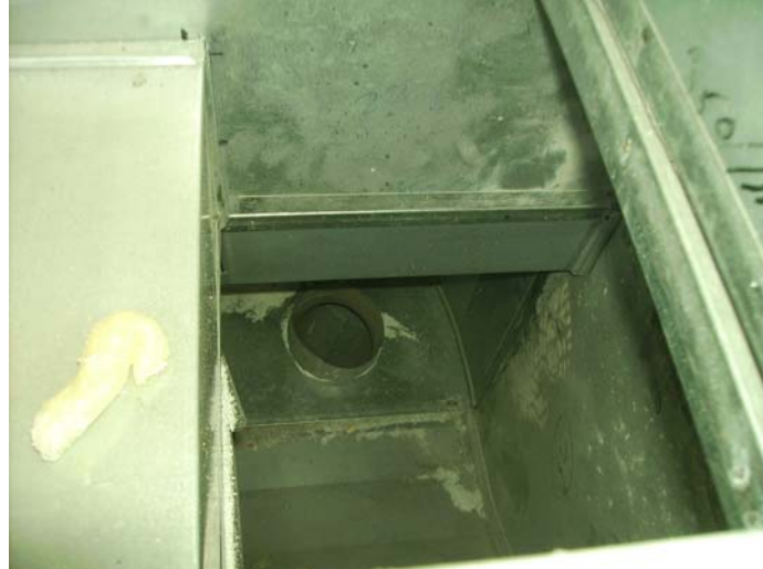
Detall de la connexió de l'admissió d'aire per a la sala d'electricitat, a dins del tub general d'admissió d'aire de l'ala Sud.
