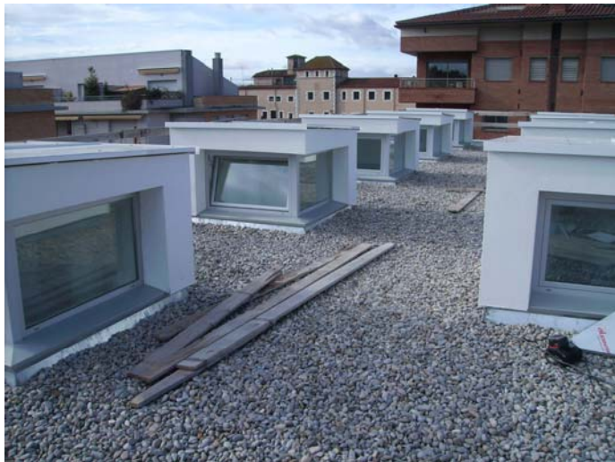
Coberta, de l'ala Sud, pràcticament acabada. Amb finestres a les claraboies i petites cobertes de planxa d'alumini.
