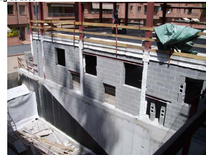
Tancaments exteriors planta baixa. Façana Sud de l'ala nord. Els murs s'enrasen a 3 cm per dins de la cara interior de pilars.
