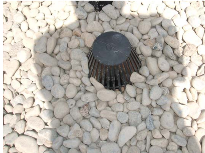
Bunera a la coberta.
