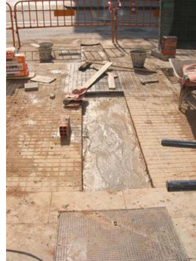
Rasa del sanejament. Des de l'arqueta sifònica on s'ajunten els pluvials i els fecals, fins al clavegueram.
