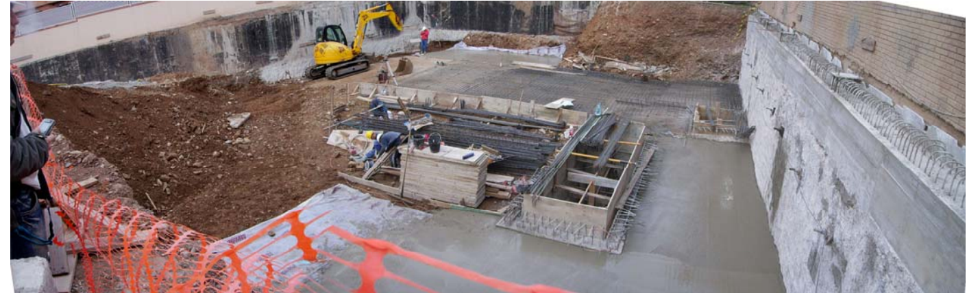
Visió general de l'obra. S'estén el formigó de neteja, i comença l'armat de la llosa de fonamentació del soterrani.
