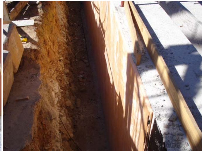
Aïllament de la cara exterior del mur del soterrani.
