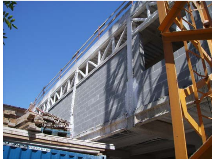
Tancaments exteriors, primer pis, façana Sud, ala Sud
