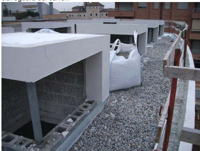
Claraboies amb l'aïllament i el revestiment. Amb el pendent decidit.
