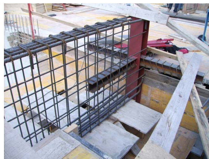
Armat de la jàssera del fons del pati. Armadures principals. Cantó Nord de la jàssera.
