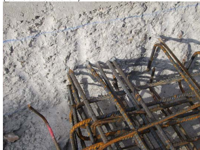
Ancoratge de l'armat de la llosa amb el fonament repicat del veí. (Ala Nord, límit amb el pati central)
