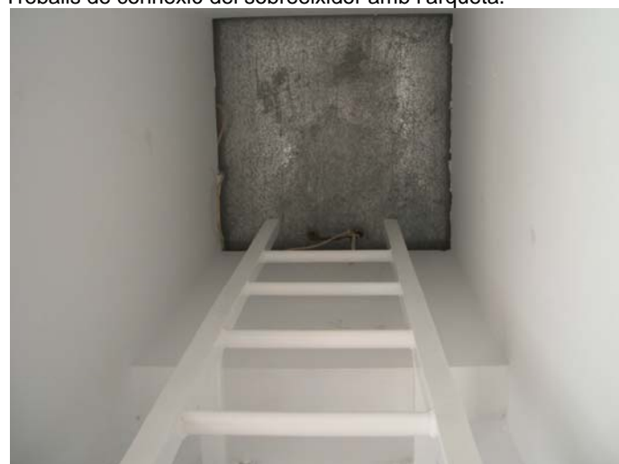
Escala de sortida al terrat. Tot revestit amb pladur.
