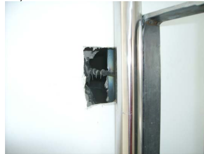
Subjecció suplementària de la barana del primer pis a l'espai de l'escala (feta als dos extrems de la barana).
