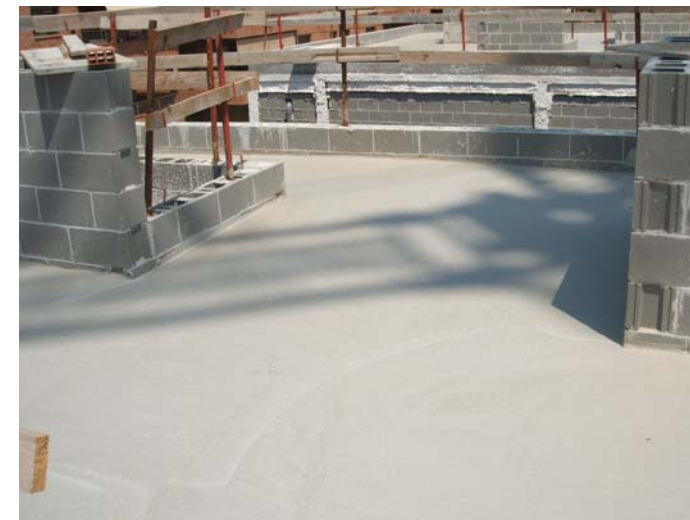
Ala Sud de l'ampliació. Enlestides pendents de coberta
