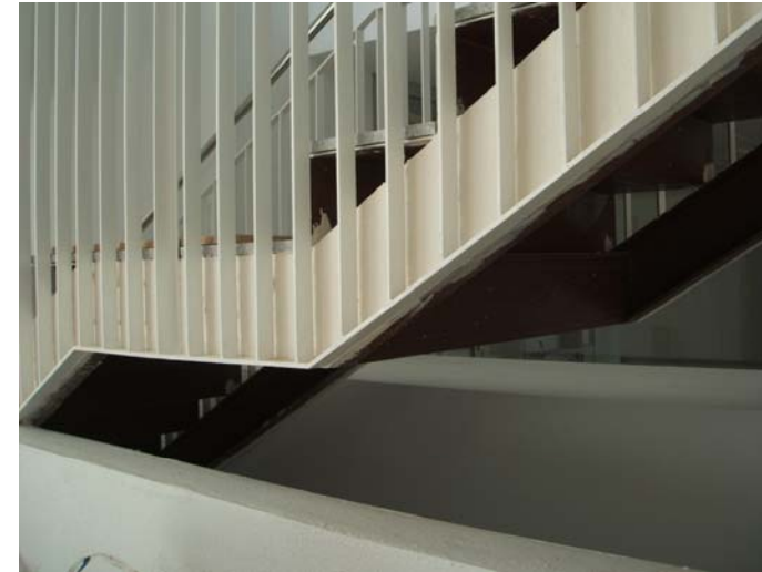
Pintura intumescent als laterals de l'escala metàl·lica principal.
