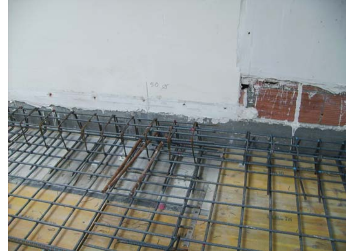
Ancoratge de la nova llosa amb l'antic forjat, a la zona de la façana amb el carrer Mare de Déu del Pilar.
