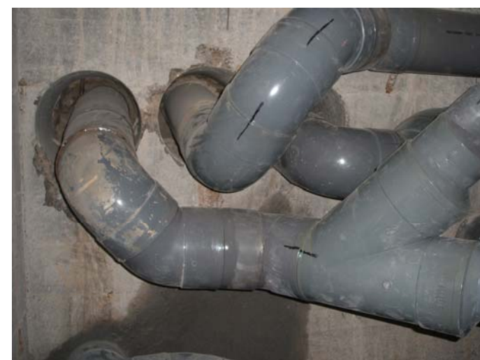
Vista de la connexió per a l'evacuació de les aigües: D'esquerra a dreta: Fecals de dipòsit 3, Pluvials de dipòsit 2 i pluvials de dipòsit 1.
