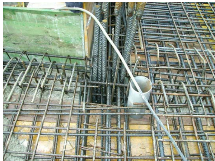
Extrem sud de la jàssera invertida i pas d'instal·lacions.
