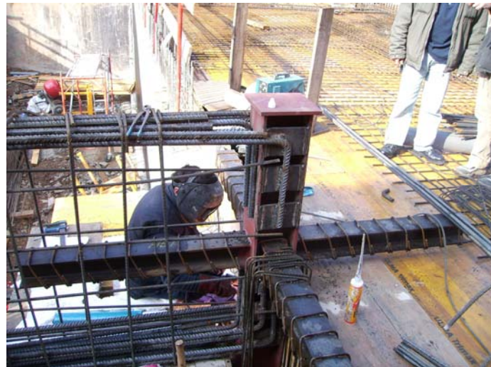
Unió de l'armat de la jàssera al pilar.
