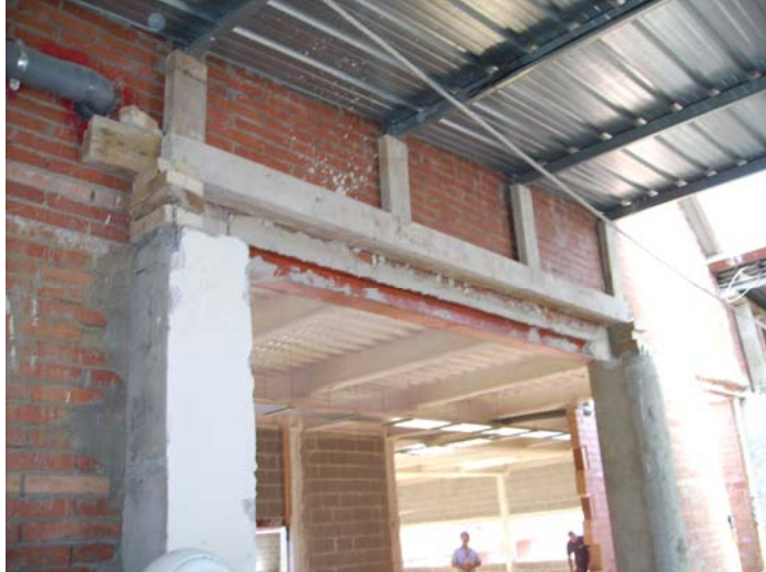
Estintolament de la gran obertura al costat de l'escala de la nova biblioteca.
