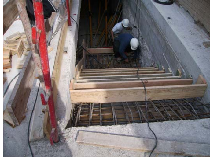
Treballs d'armat i encofrat de la llosa d'escala del soterrani.
