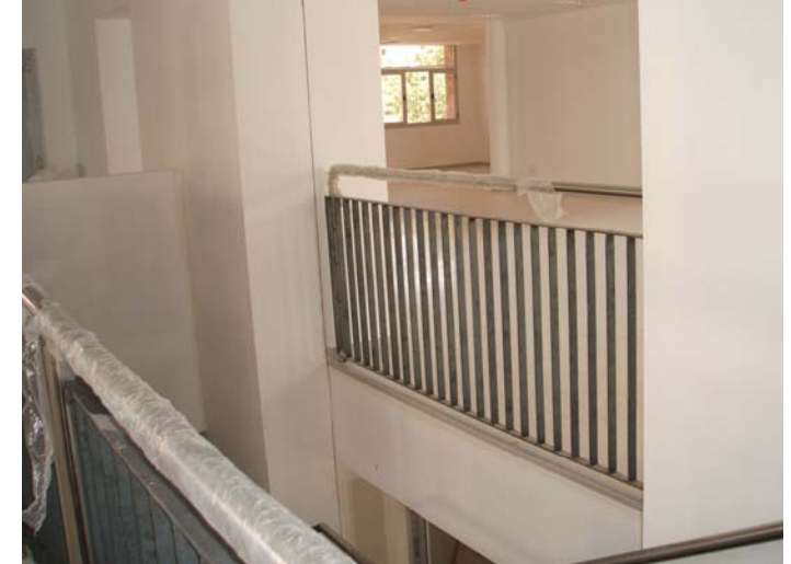
Barana de la gran obertura del primer pis. S'haurà de reforçar els suports. La barana de l'escala ja està col·locada.
