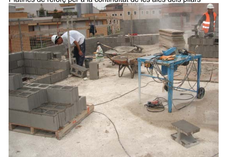
Inici de la construcció de les claraboies i les baranes de coberta.
