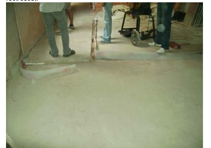
Sòl de la sala de personal. Final de la part amb sòl radiant, i inici de la part amb recrescut de morter, per a poder suportar un "Compactus". S'ha hagut de modificar la distribució.
