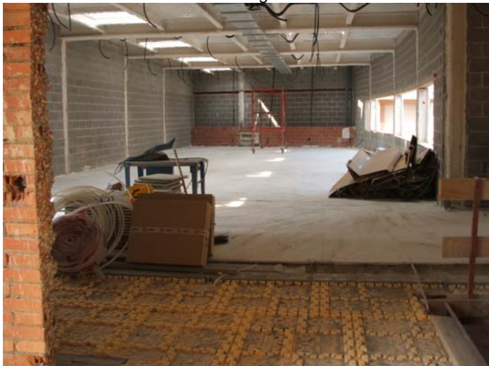
Estat de l'acabat dels paviments al primer pis. Inici del pas d'instal·lacions elèctriques.
