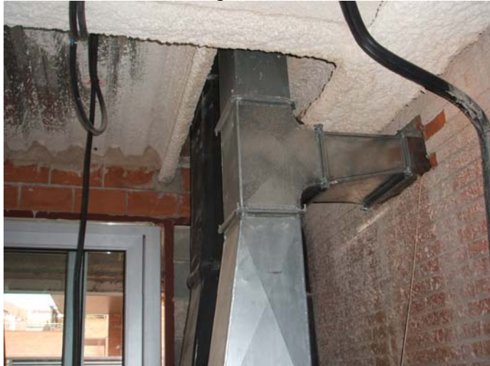
Connexió del tub de retorn procedent de la biblioteca antiga.
