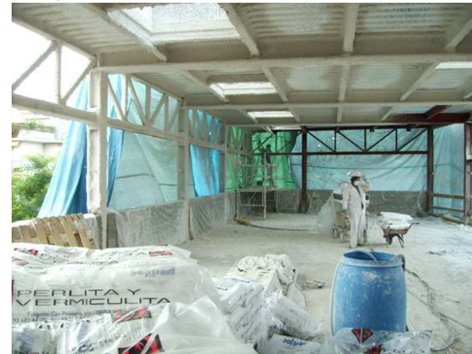
Inici del ignifugat de la estructura al primer pis.
