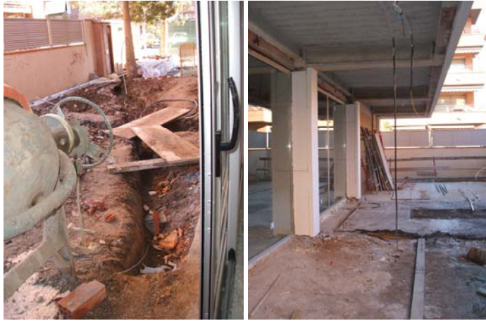
Rasa des del comptador elèctric. Escomesa d'electricitat cap al soterrani. (canvi respecte al projecte)
