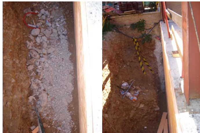
Aïllament de la cara exterior del mur del soterrani
