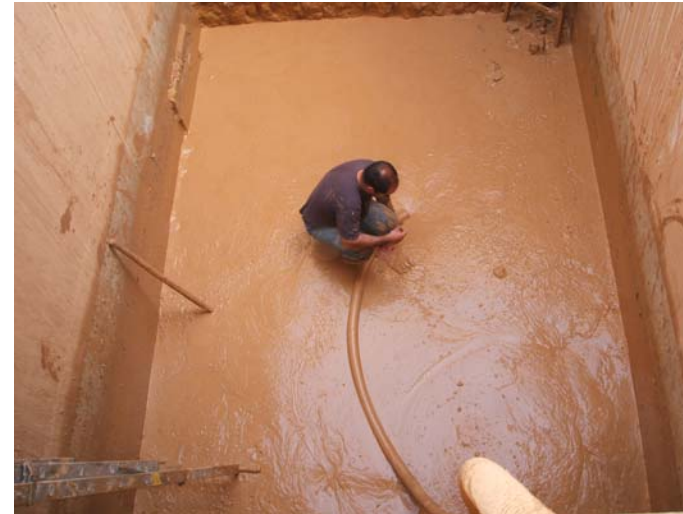
Recollida de llots al recinte del futur generador.
