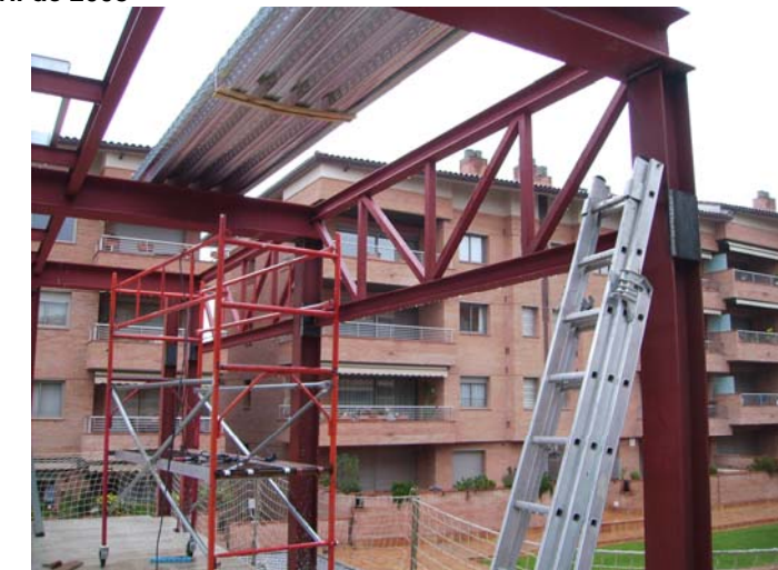
Es comencen els treballs del forjat col·laborant de coberta, i de la gelosia rigiditzadora dels voladissos.
