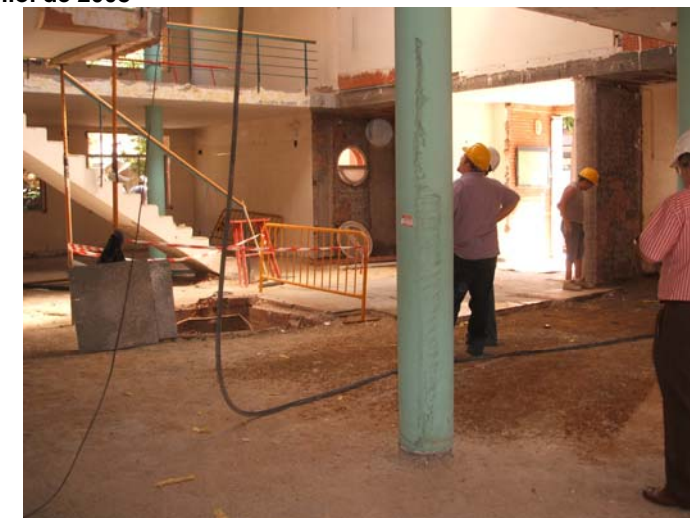
Vista general dels enderrocats a la biblioteca antiga
