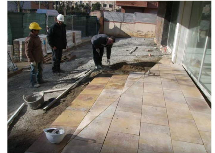
Col·locació de la llosa Vulcano al porxo de la entrada. La part que no es veu, demana una revisió dels pendents.
