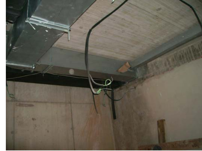
Instal·lacions d'aire condicionat i elèctriques al sostre del despatx de la Direcció de la Biblioteca. (Pas a la planta superior)
