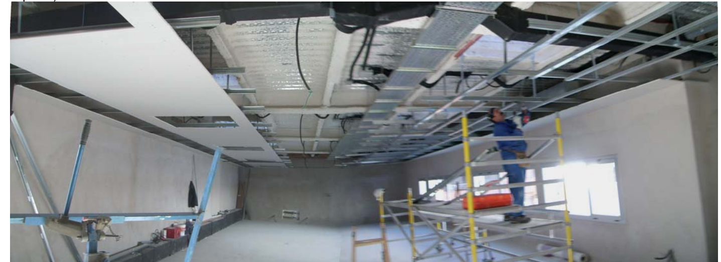
Instal·lacions, i col·locació del fals sostre de pladur i planxes perforades amb junta semi-oculta al sostre del primer pis ala Sud.
