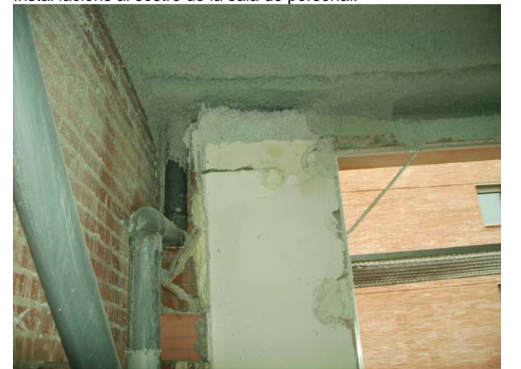
També s'ha aïllat les cambres dels murs de façana de la biblioteca antiga. (amb escuma de poliuretà)
