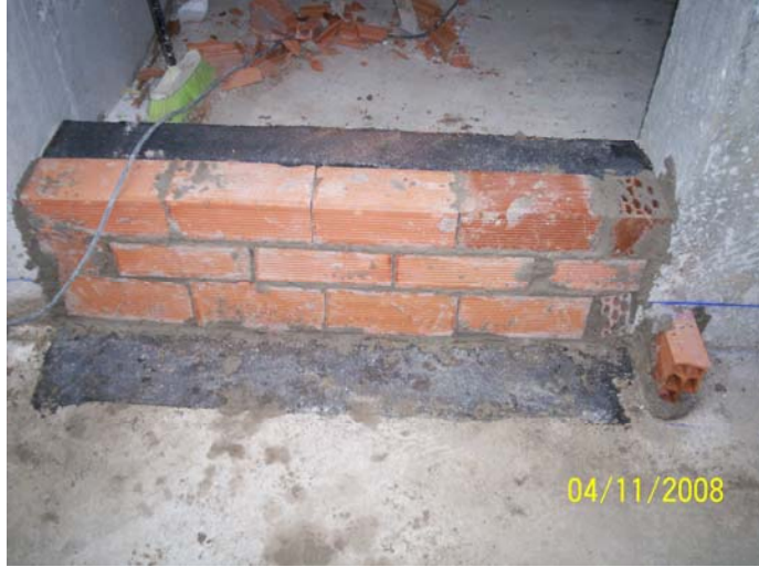
Muret amb impermeabilització a la sortida al pati d'instal·lacions de la sala polivalent.
