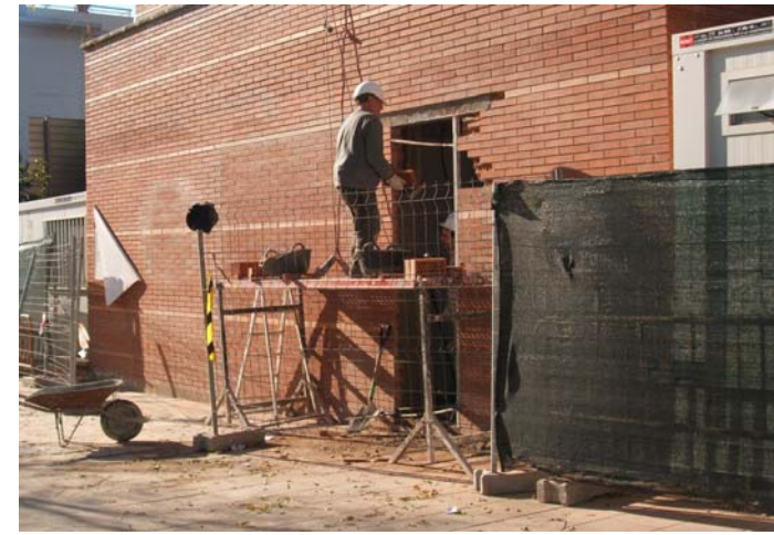
Treballs de tancament d'obertures a l'edifici vell de la biblioteca. Ja s'ha tapat una finestra rodona, i s'està tancant la porta principal.
