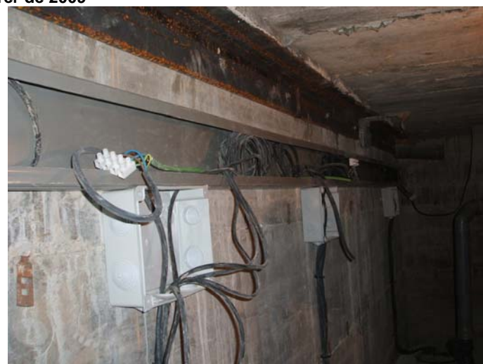
Mur del fons. (al fons, es veu el tub de fecals que encara no s'ha connectat al seu dipòsit)
