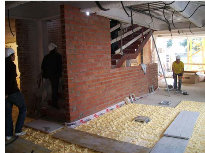
Construït el mur de darrera de recepció. No estava al projecte, però es necessita per a passar instal·lacions i suportar diversos elements de tancament.
