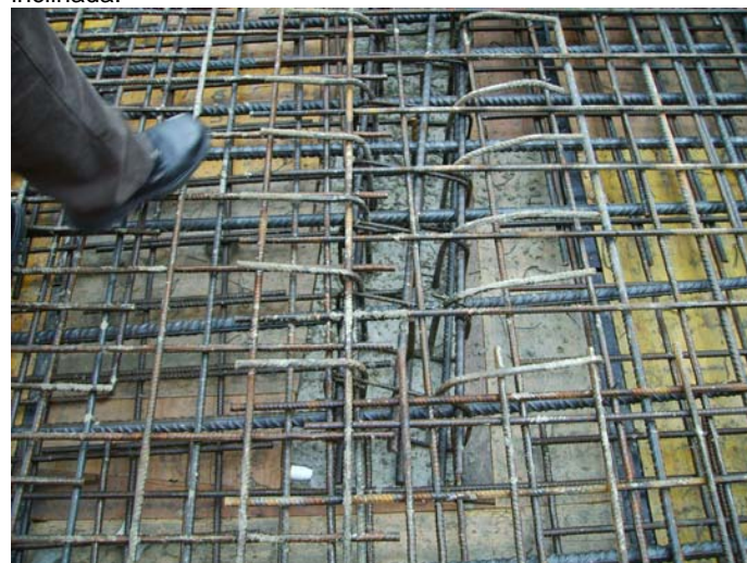
Armat sobre mur de formigó. Armat de 25 a la cara superior.
