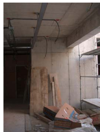
Premarc a la gran balconera corredissa de 3 fulles al soterrani.
