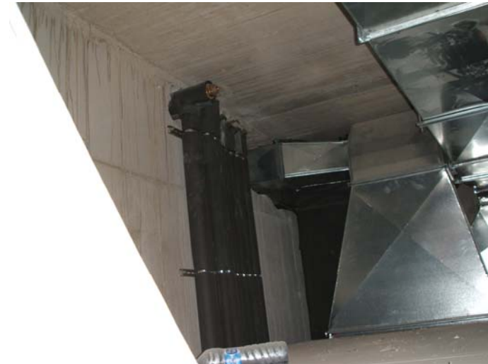
A l'altre cantó sortida del tub de retorn, i del terra radiant.
