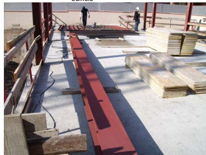
Ala Nord. Treballs amb l'acer dels pilars.
