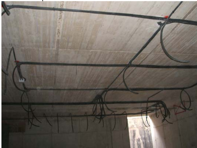
Inici del traçat de les instal·lacions elèctriques. Punts de llum a la sala polivalent.
