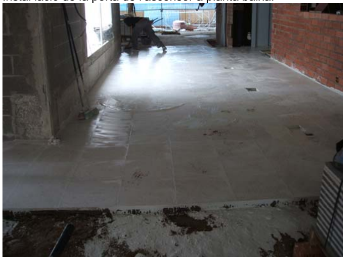
Col·locació i polit del paviment de planta baixa.
