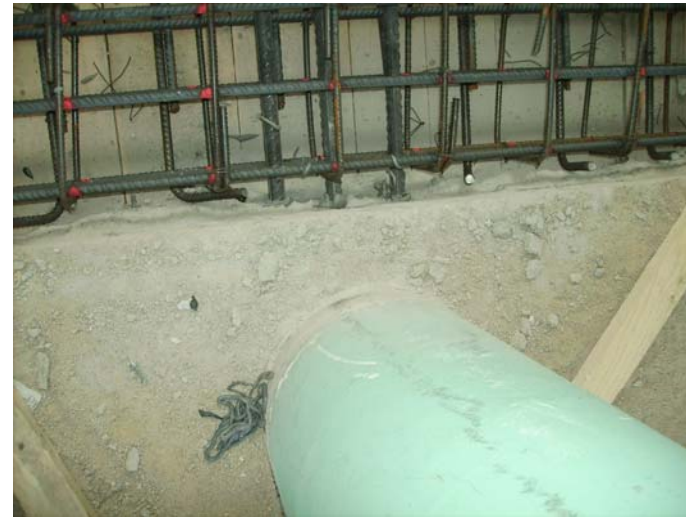
Tres rodons de connexió entre la nova llosa i l'antic forjat a l'altura dels pilars.
