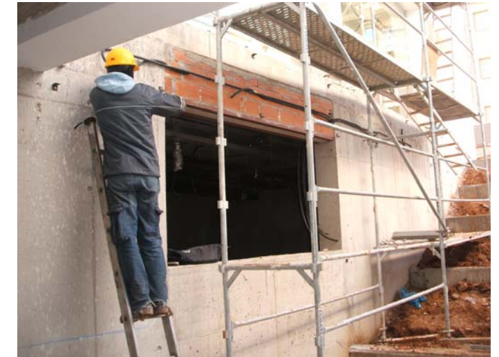
Construcció de la llinda de la finestra de la sala de personal.
