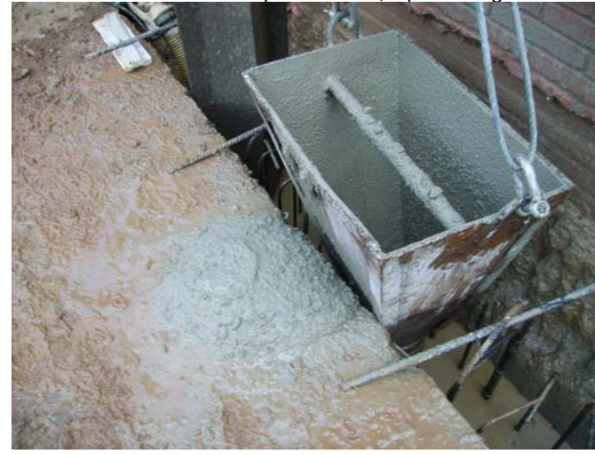
Embut de formigonat.
