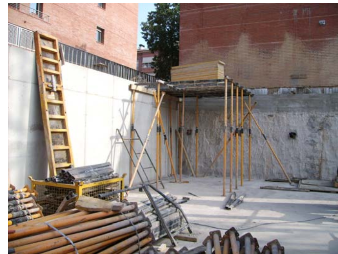
Inici dels treballs d'encofrat de la llosa del primer forjat.
