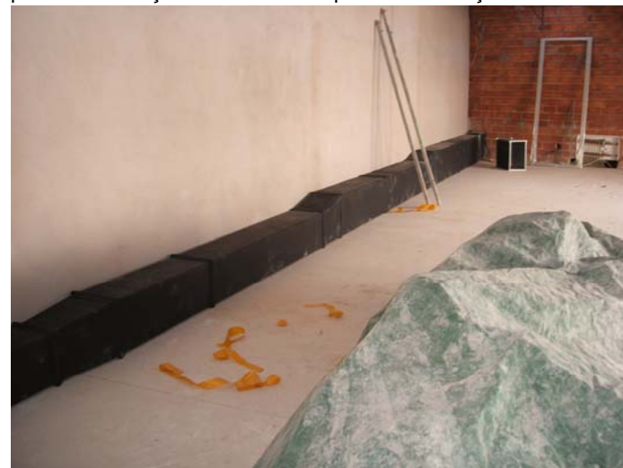
Conducte de l'aire condicionat al primer pis, façana Sud de l'ala Sud.
