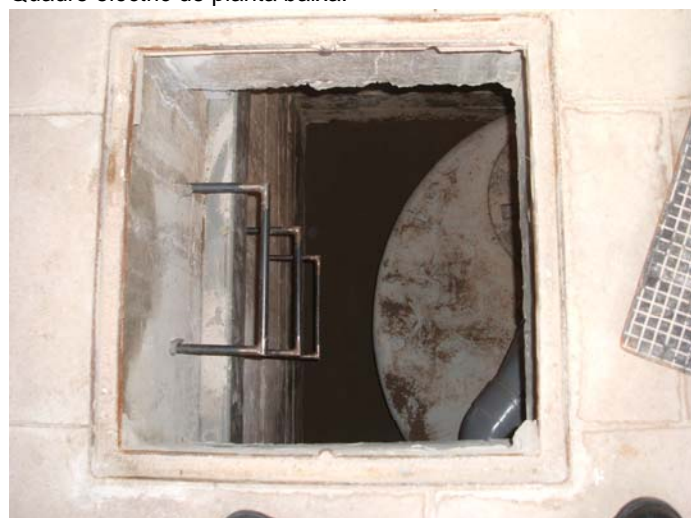
Entrada al recinte de sanejament. Ja s'ha col·locat la sorra.
