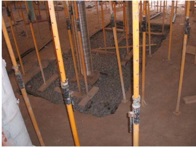
Fets els fonaments dels dos pilars centrals de suport per a la nova llosa de la biblioteca antiga.
