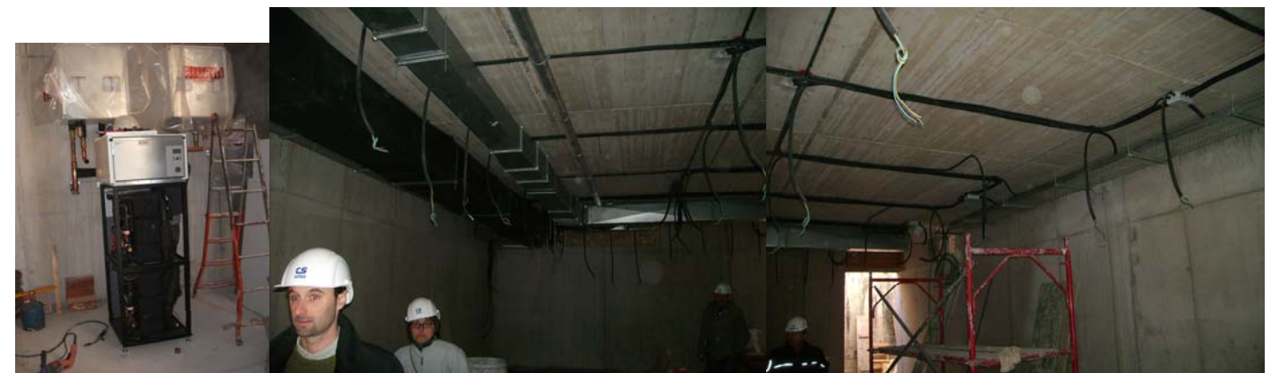
Inici de la instal·lació de la bomba geotèrmica aigua/aigua i dels dos hpac al recinte tècnic del soterrani.
