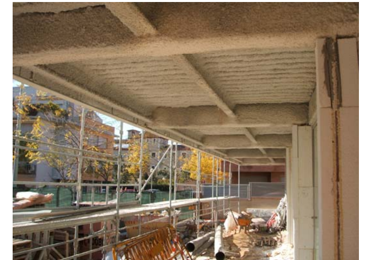
S'ha projectat llana de roca el mateix aïllament de la coberta de la biblioteca antiga, a sota el porxo.
