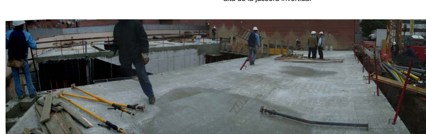
Vista general de l'estat de l'obra. (composició de 4 fotos)
