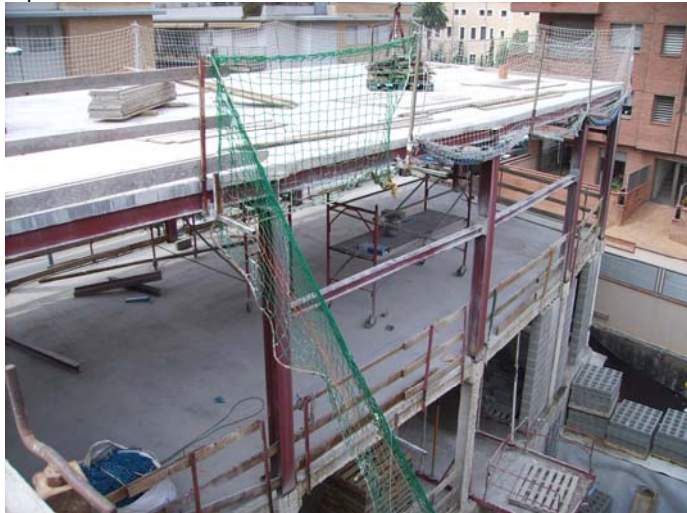
Col·locada la corretja de llinda de finestra a la façana Nord de l'ala Sud.
