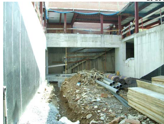
Obertura de la rasa per al sanejament i drenatges de l'ala Nord.
