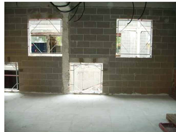
Inici de la col·locació dels premarcs a les finestres de la façana Sud de l'ala Nord, a planta baixa.
