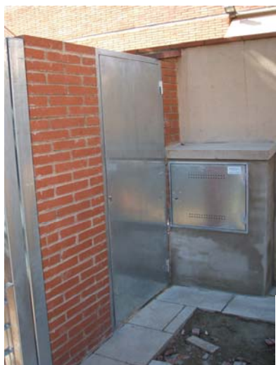
Nou armari de l'aigua, i porta d'accés al nou recinte per als comptadors elèctrics.
