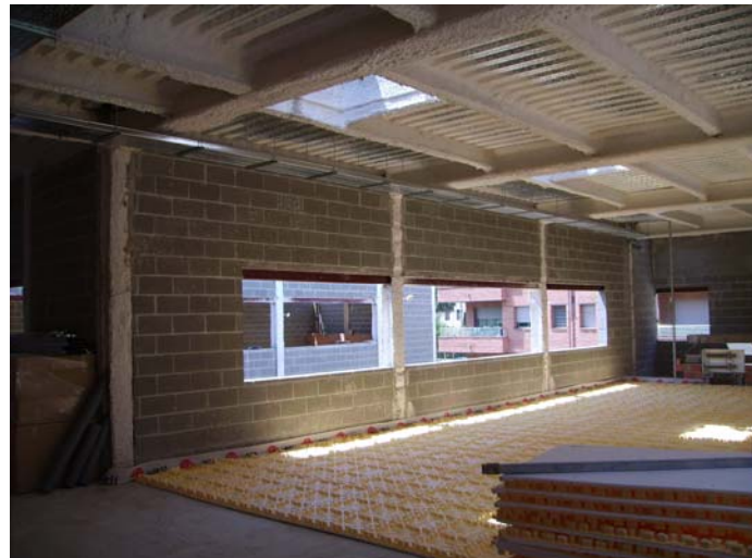
Estesa de planxes aïllants a l'ala Nord del primer pis. Safates per a instal·lacions amb cables al sostre.
