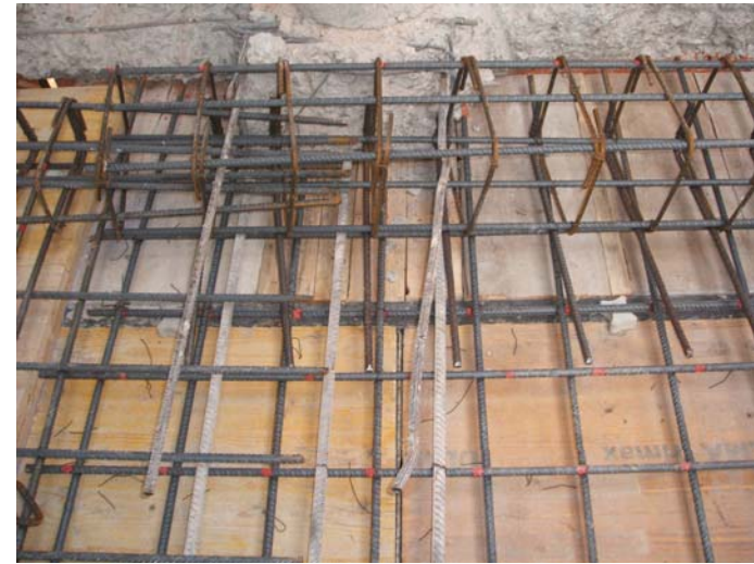
Armat de l'antiga jàssera plana, integrada a la nova llosa. Junta entre edificis.
