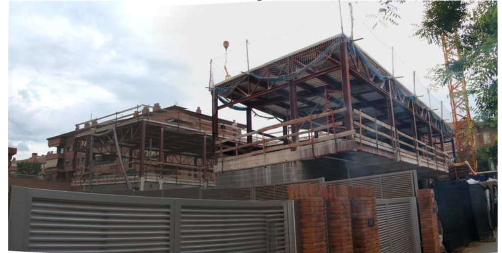
Visió general de la estructura. Revisió de detalls i reforços.
