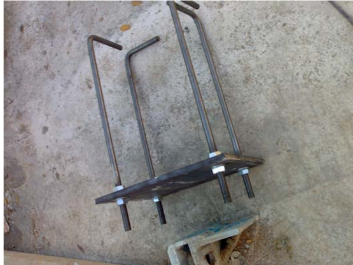
Placa d'ancoratge dels pilars abans de formigonar la jàssera de coronació del mur pantalla. (foto de la visita anterior)
