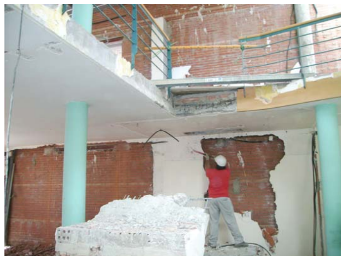
Enderroc d'envans a planta baixa. Ja s'ha enderrocat una de les escales de la biblioteca antiga.
