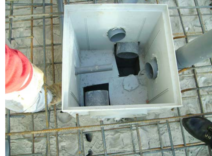
(1) Interior arqueta. Té 2 nivells. El de sota recull el tub enterrat sota la llosa que ve de la futura sala del generador.
