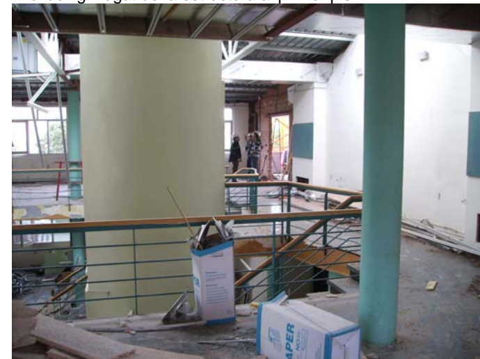
Arrencada de revestiments i instal·lacions a la biblioteca antiga.
