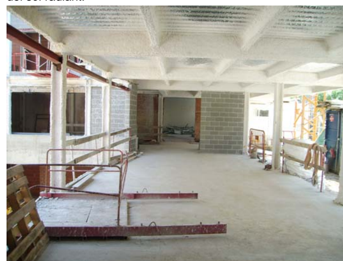
Planta Baixa, ala sud. Vista del vestíbul d'entrada i connexió amb edifici antic.
