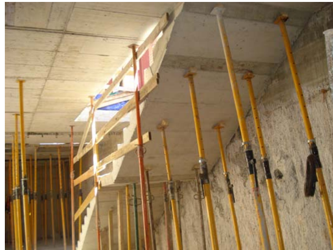
Escala del soterrani desencofrada i apuntalada.
