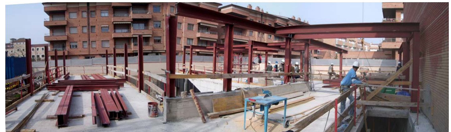
Vista general de la col·locació de pilars i jàsseres
